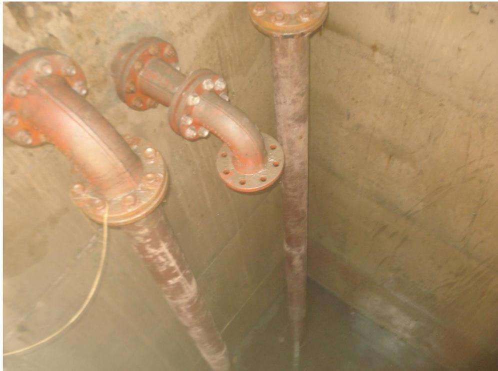
Foto 06 – Tubulações em Ferro Fundido (EEE)
