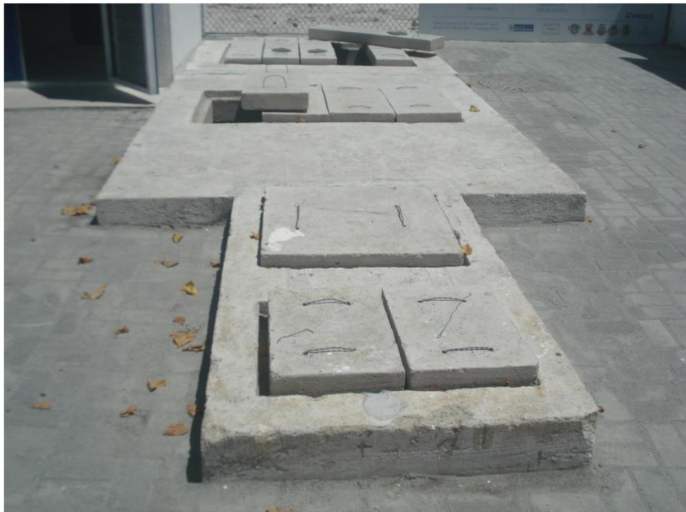
Foto 05 – Caixa de Válvulas (EEE)
