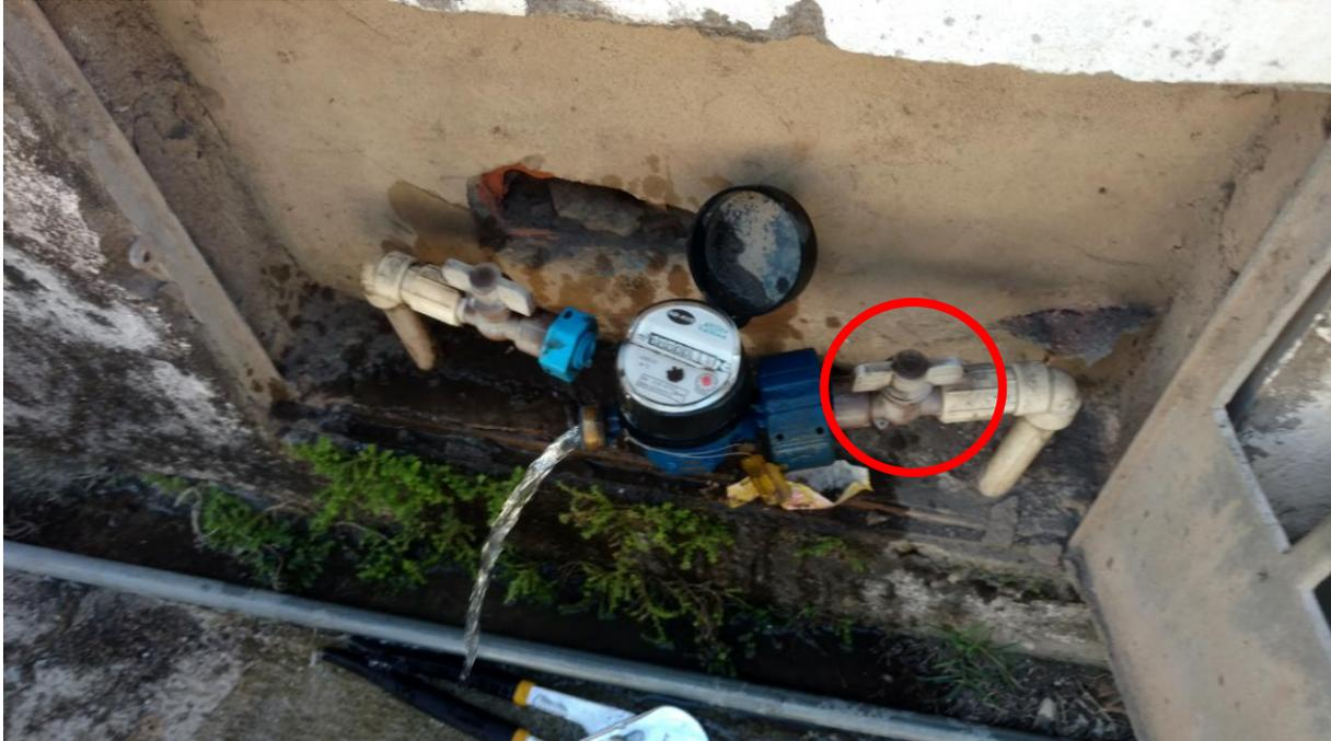
DESMONTAGEM DO CAVALETE - DETALHE EM VERMELHO (ABERTURA DO REGISTRO)
