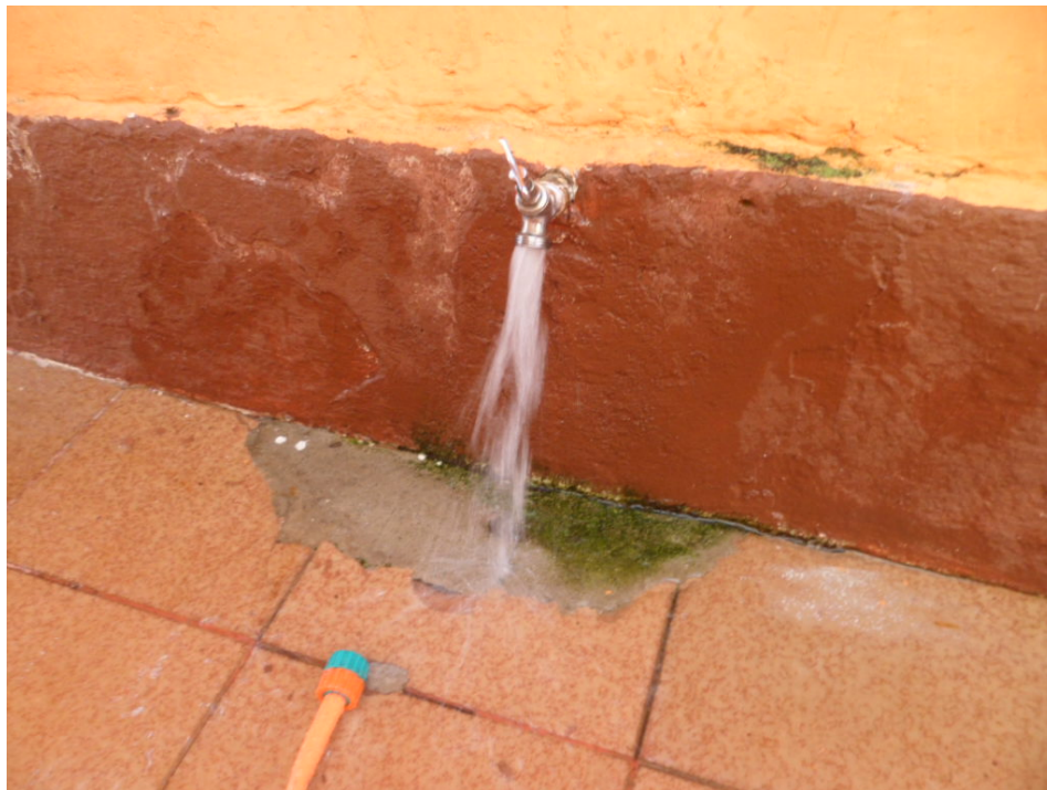
Foto 05 – Abastecimento Normal, Torneira Interna com Água
