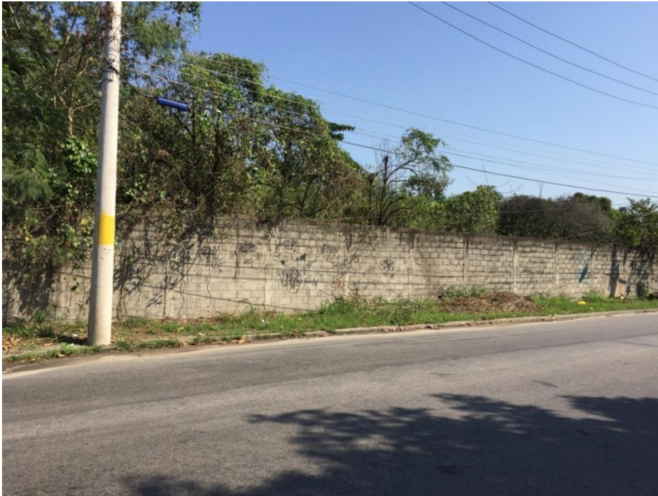
Estrada Camboatá - Local onde estaria o buraco de 1,5 m
