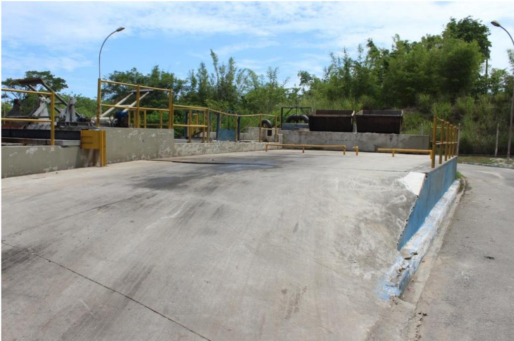
Foto 06 – Rampa de subida de caminhão fossa para despejo nas caçambas
