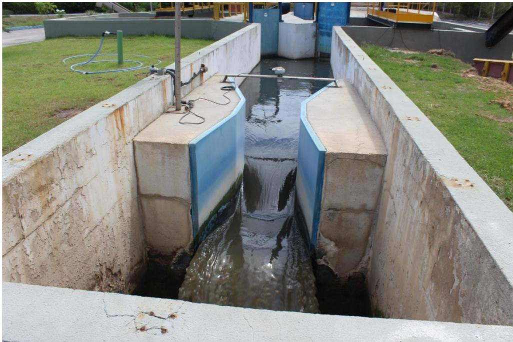
Foto 12 – Medidor de vazão (vista superior)
