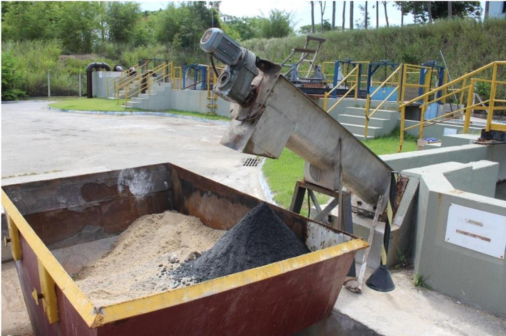
Foto 10 – Areia retirada do desarenador
