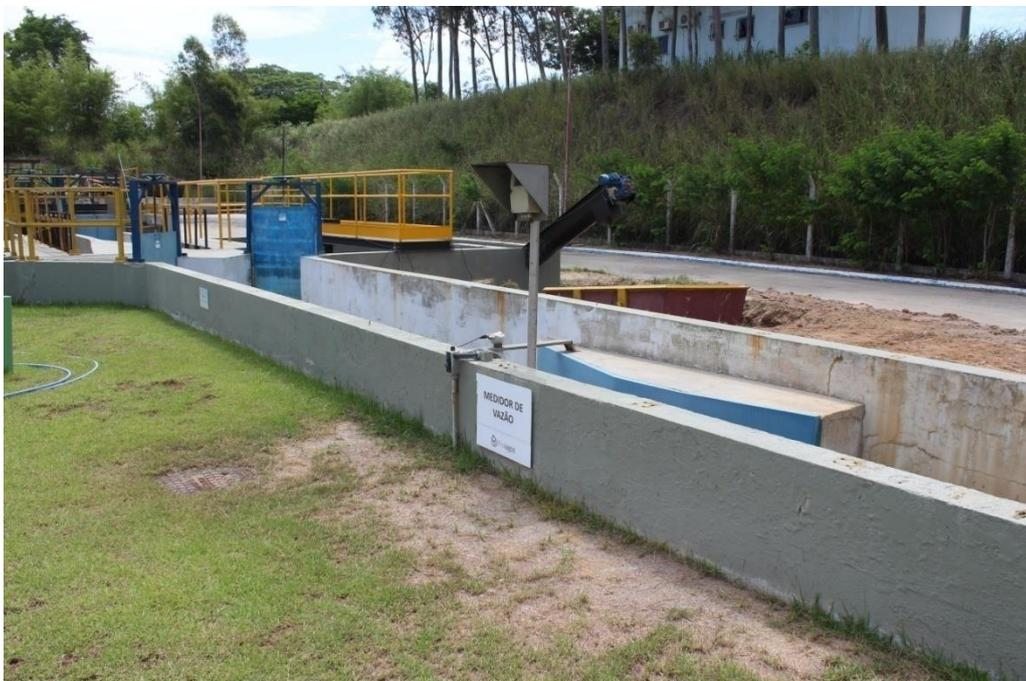
Foto 13 – Medidor de vazão
