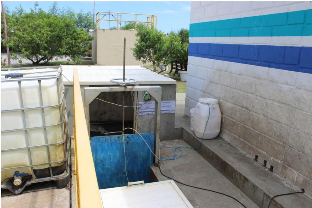
Foto 34 – Desinfecção com ácido tricloroisocianúrico e antiespumante
