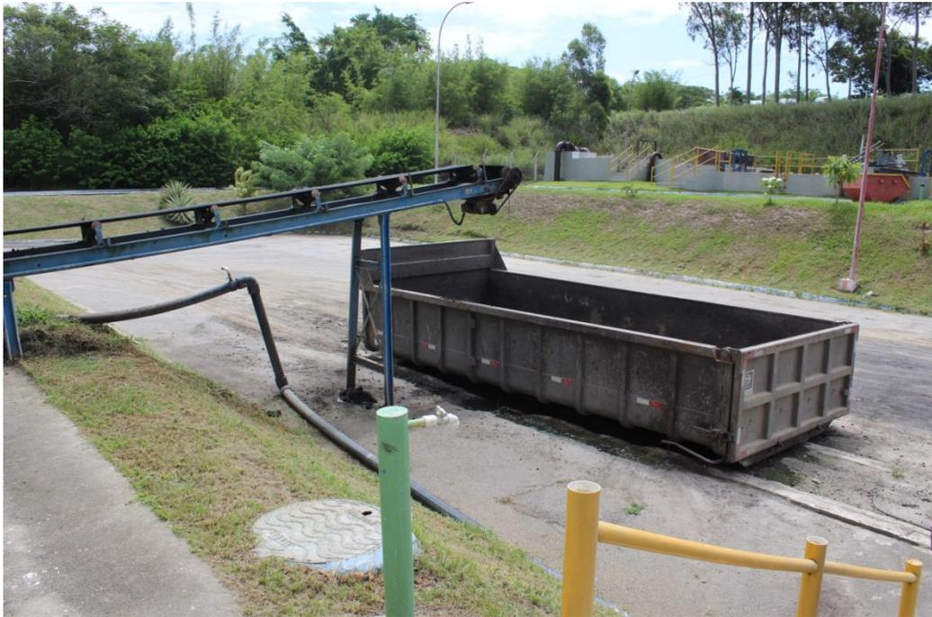
Foto 24 – Esteira de retirada do lodo e lançamento na caçamba
