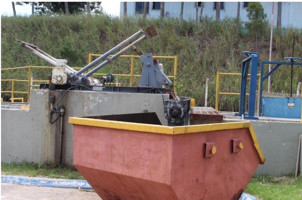
Foto 11 – Gradeamento mecanizado lançando resíduos sólidos na caçamba
