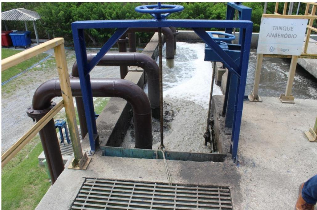
Foto 15 – Tanque anaeróbico
