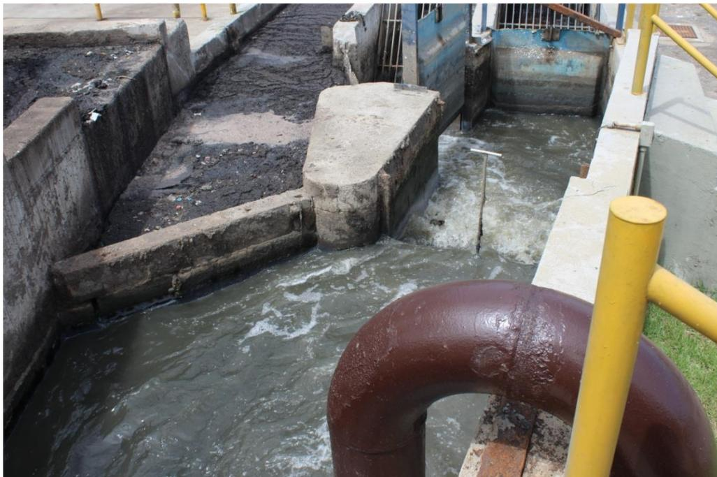
Foto 05 – Entrada do esgoto para os desarenadores divididos por comportas
