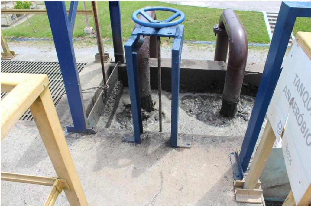
Foto 16 – Recalque de esgoto bruto no tanque anaeróbio
