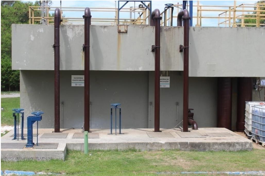
Foto 14 – Elevatória de esgoto bruto
