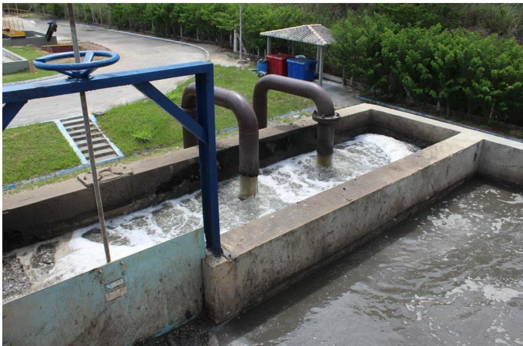
Foto 17 – Recalque do decantador para o tanque anaeróbio
