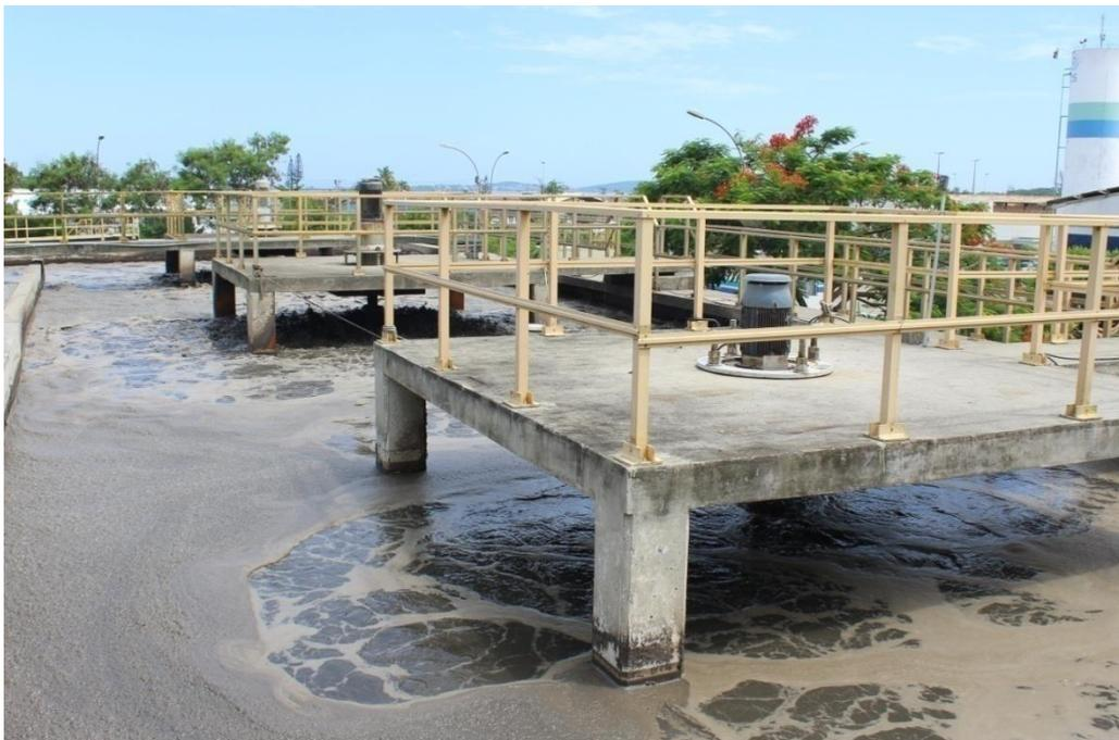
Foto 19 – Tanque aerador com 4 motores
