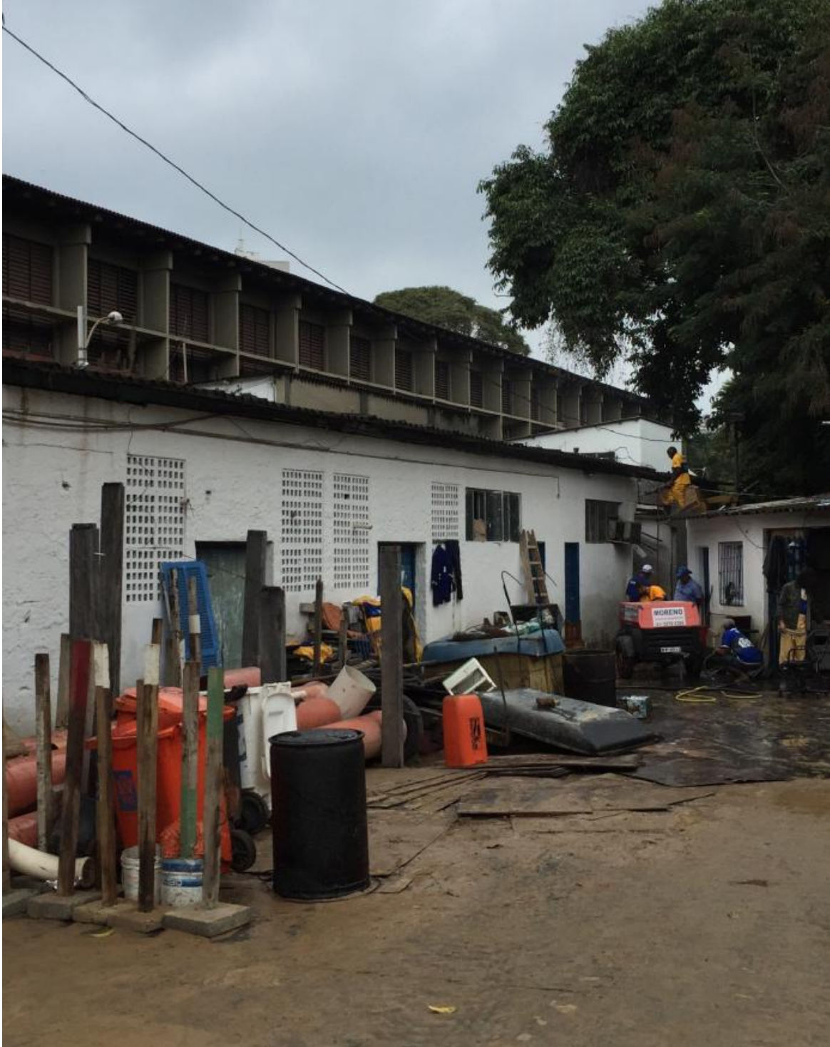
DEMOLIÇÃO DO PRÉDIO ANEXO CONSTRUÍDO SOBRE A ADUTORA DN 600 MM
