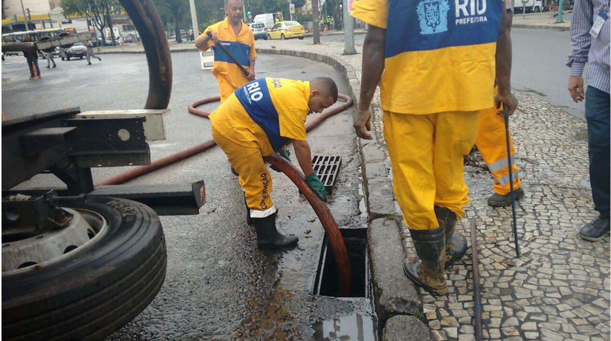
LIMPEZA DE BOCA DE LOBO NA RUA BARTOLOMEU MITRE
