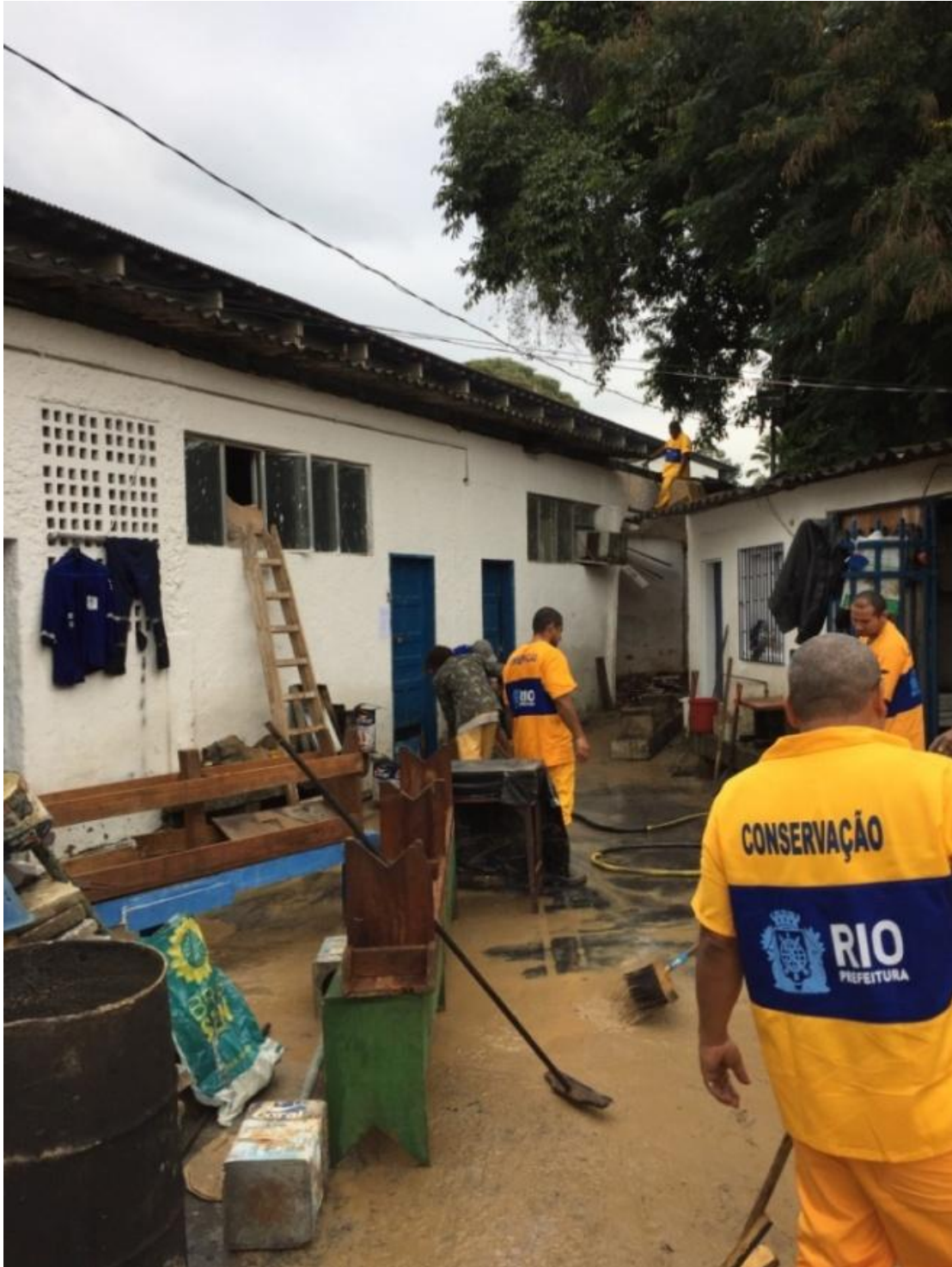
DEMOLIÇÃO DO PRÉDIO ANEXO CONSTRUÍDO SOBRE A ADUTORA DN 600 MM
