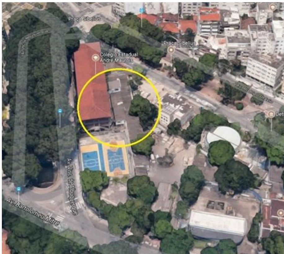
PONTO DO ROMPIMENTO DA ADUTORA - DETALHE EM AMARELO
