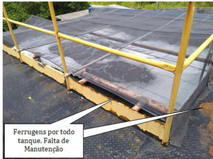
Foto 08 – Tanque de Biofiltro
