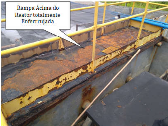
Foto 17 – Rampa do Reator Totalmente Enferrujada e Tanque de Biofiltro Desativado
