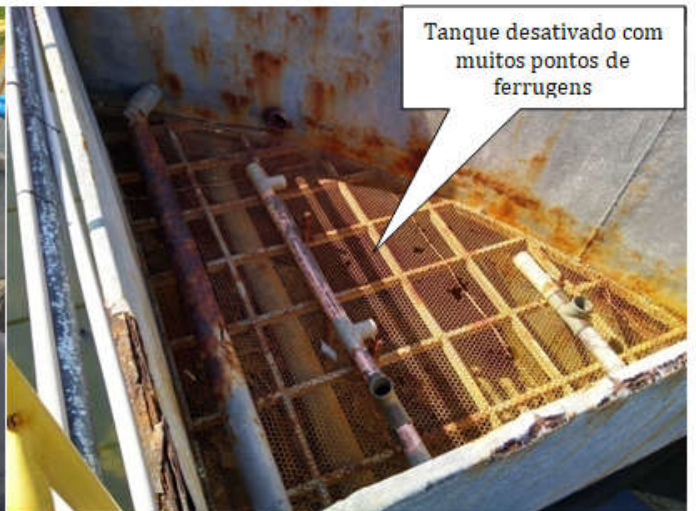
Foto 17 – Rampa do Reator Totalmente Enferrujada e Tanque de Biofiltro Desativado
