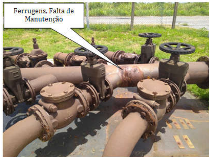
Foto 05 – Elevatória dentro da Estação
