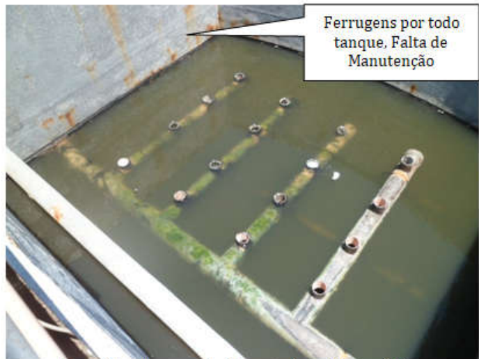
Foto 10 – Tanques de Decantadores Secundários
