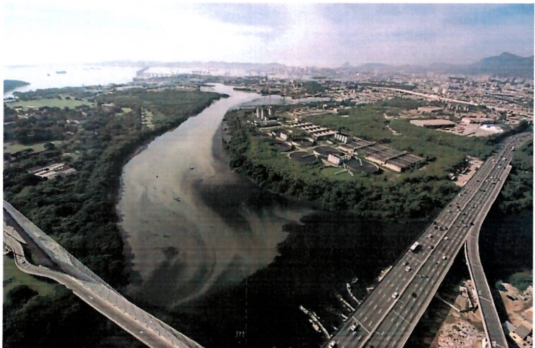
Vista aérea da ETE Alegria
