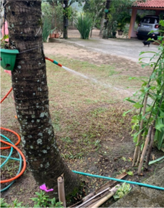
Foto 2 - 1ª torneira de água direta da rede
