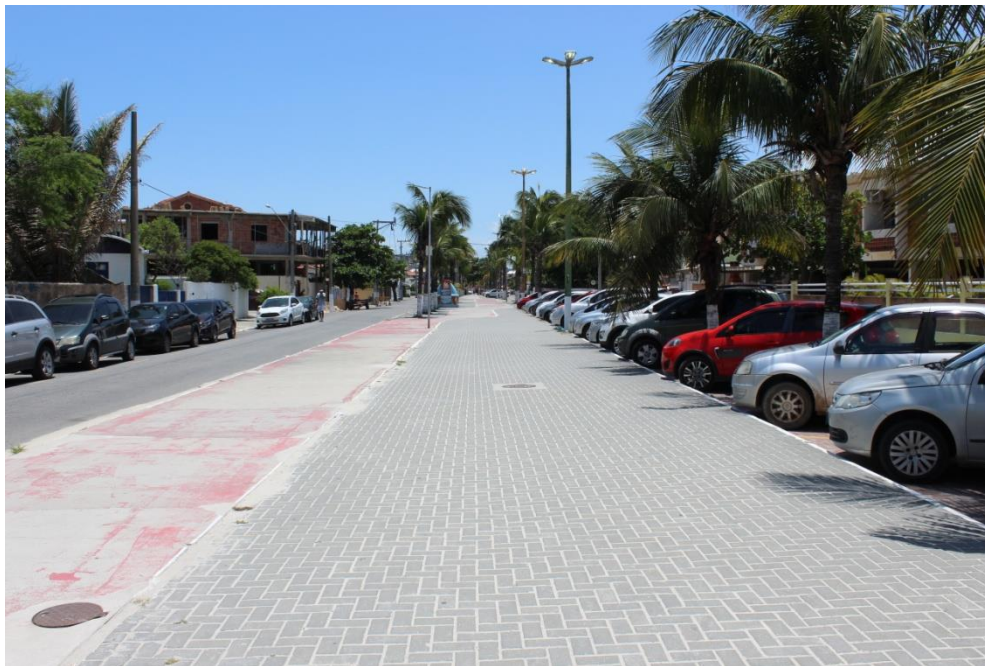
Foto 09 – Poço de Visita na Av.da Liberdade
