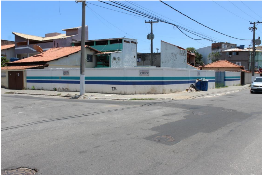
Foto 12 – Estação Elevatória (Recalque para a ETE)
