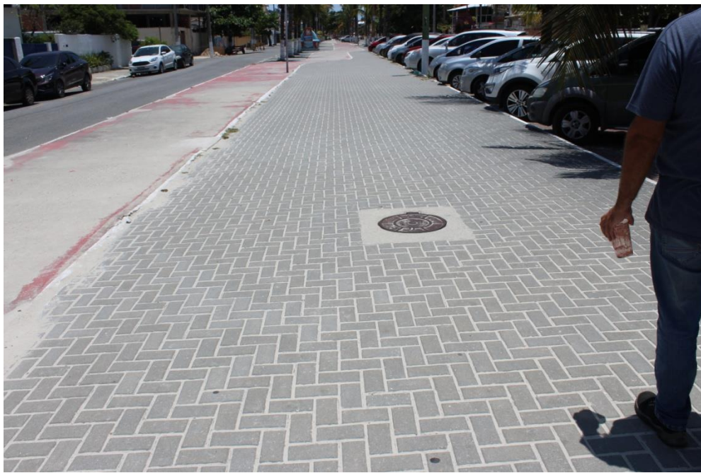
Foto 11 – Poço de Visita na Av. da Liberdade
