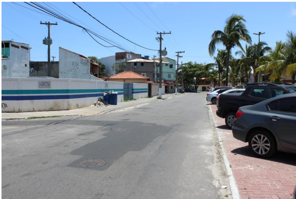
Foto 13 – Estação Elevatória Av: da Liberdade
