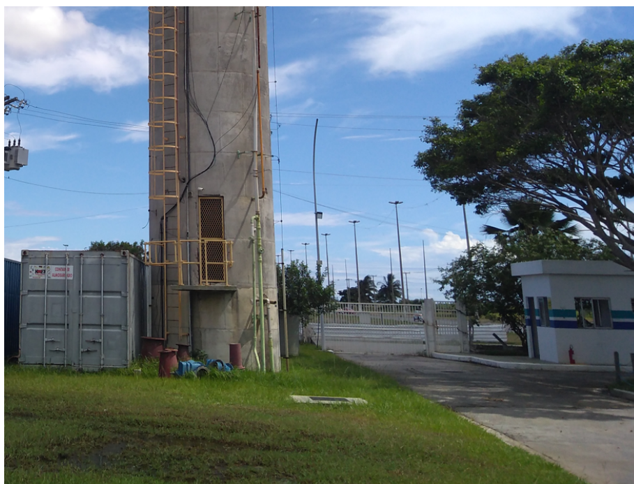
Entrada da Estação de Tratamento de Esgoto Praia do Siqueira (ETE Cabo Frio)
