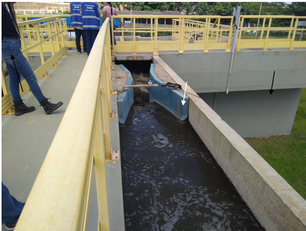
Figura 9 – Calha Parshall com Medidor de Vazão Ultrassônico, régua ilegível,
