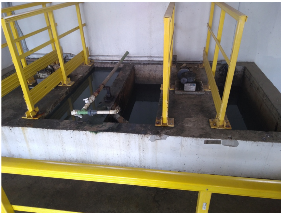
Figura 20 – Tanque de preparo (vista superior) e dosagem de polímeros para a centrífuga
