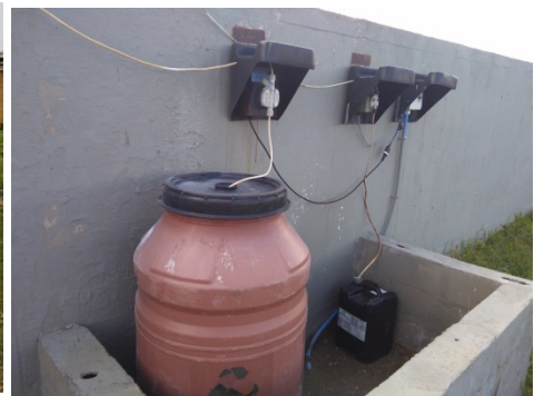
Figura 17 – Câmara de contato para a desinfecção do efluente final com cloro (nível terciário), incluindo dosagem deste cloro no início das chicanas (vide dosadores na imagem da direita)
