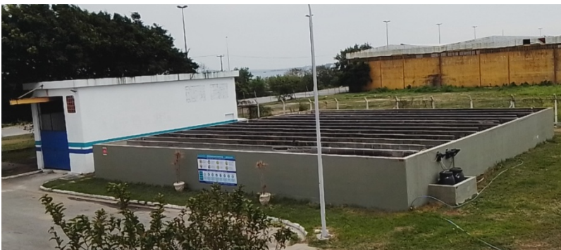
Figura 17 – Câmara de contato para a desinfecção do efluente final com cloro (nível terciário), incluindo dosagem deste cloro no início das chicanas (vide dosadores na imagem da direita)
