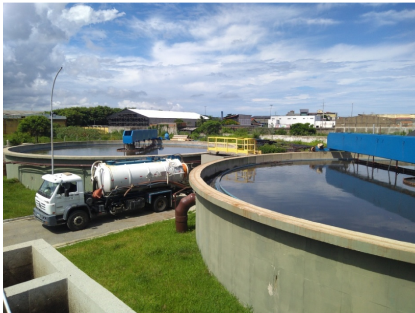
Figura 11 – Dois decantadores circulares com raspadores de escuma na parte superior e de lodo na parte inferior (vistas superiores e lateral). Destaque para pequenas infiltrações nas paredes
