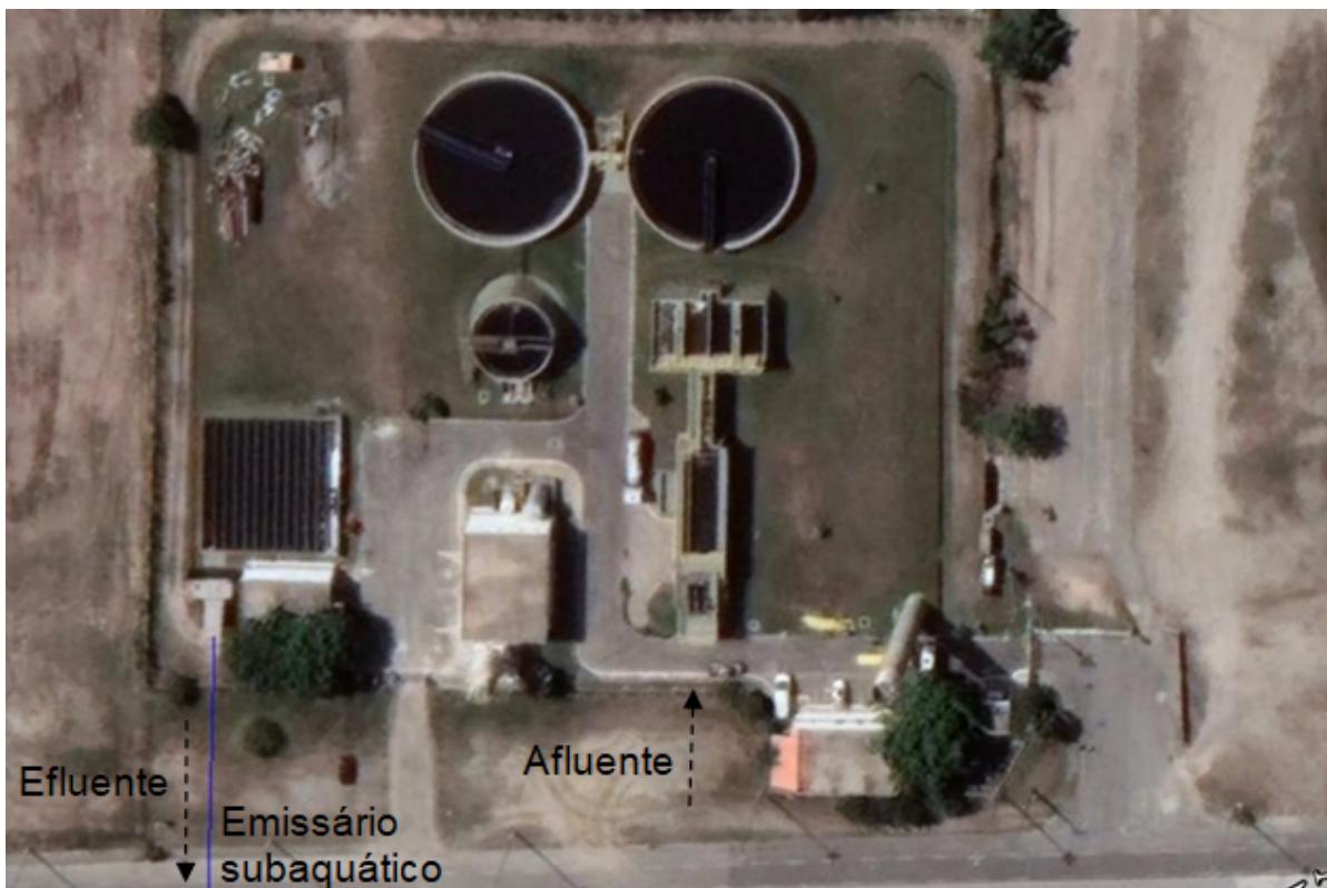
Vista Aérea da ETE Praia do Siqueira (Fonte: Google de mar/2022)
