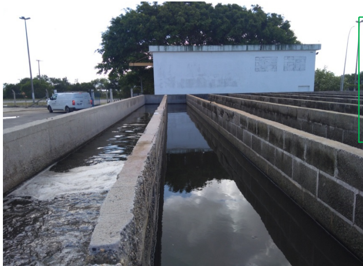
Figura 16 – Tanque de contato
