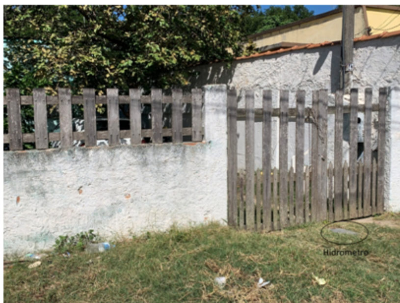
Figura 4 (Hidrômetro frente da casa)
