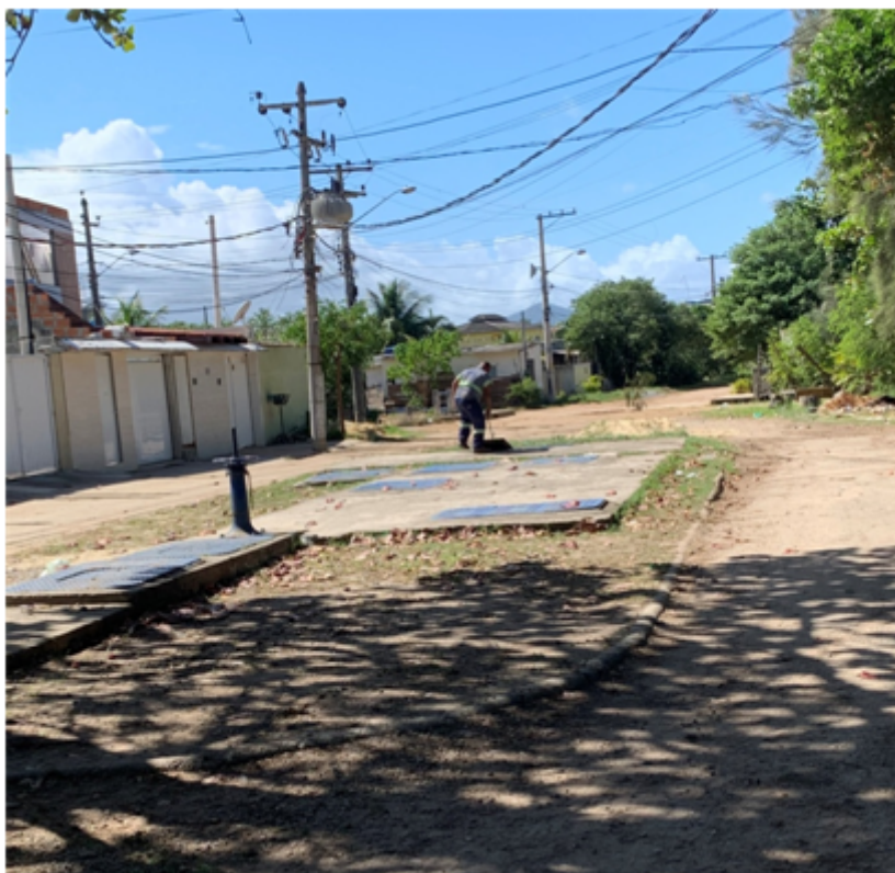
Figura 3 (Manutenção bomba elevatória)
