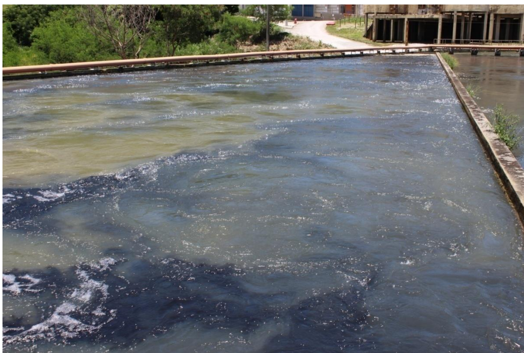
Mistura do Carvão Ativado na Entrada da Água
