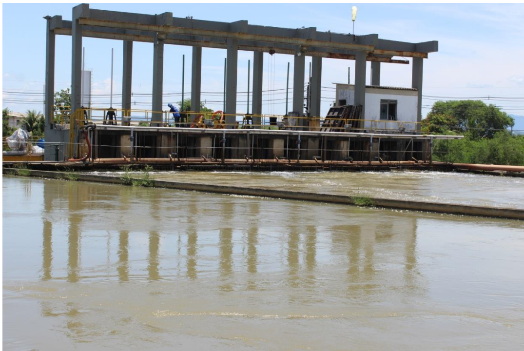
Entrada da Água vinda das Adutoras
