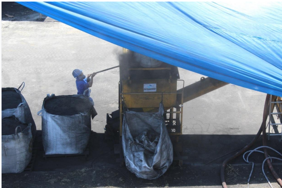
Equipamento de lançamento do Carvão Ativado
