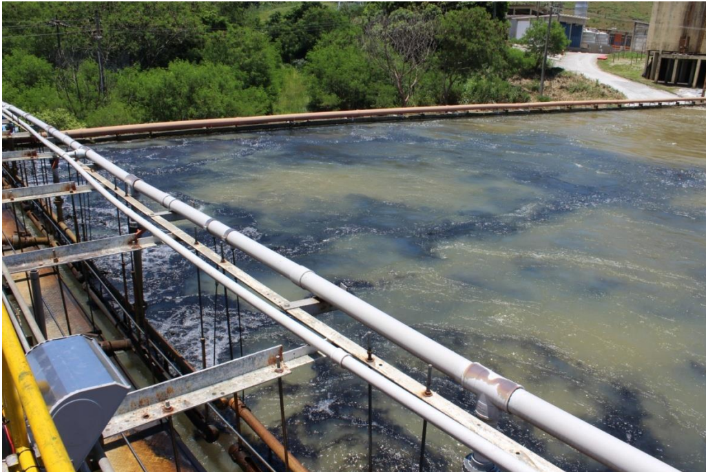
Aplicação do Carvão Ativado na Entrada da Água
