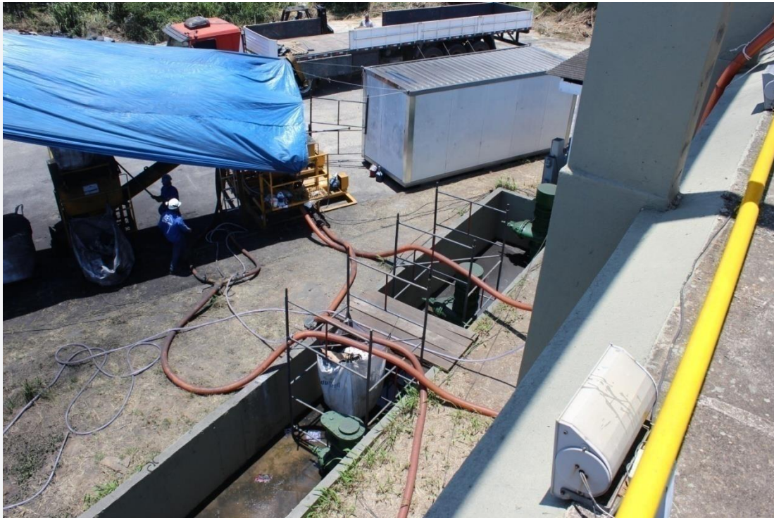
Equipamento de lançamento do Carvão Ativado (Funcionário se Máscara)
