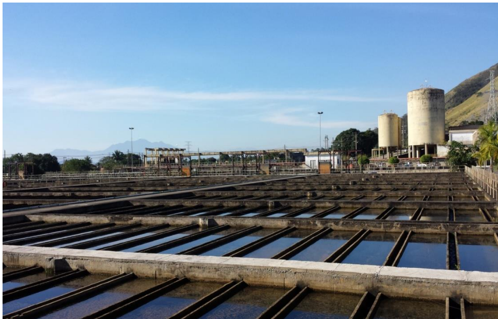
Tanque de Decantação
