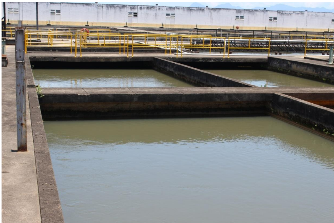
Tanque de Floculação
