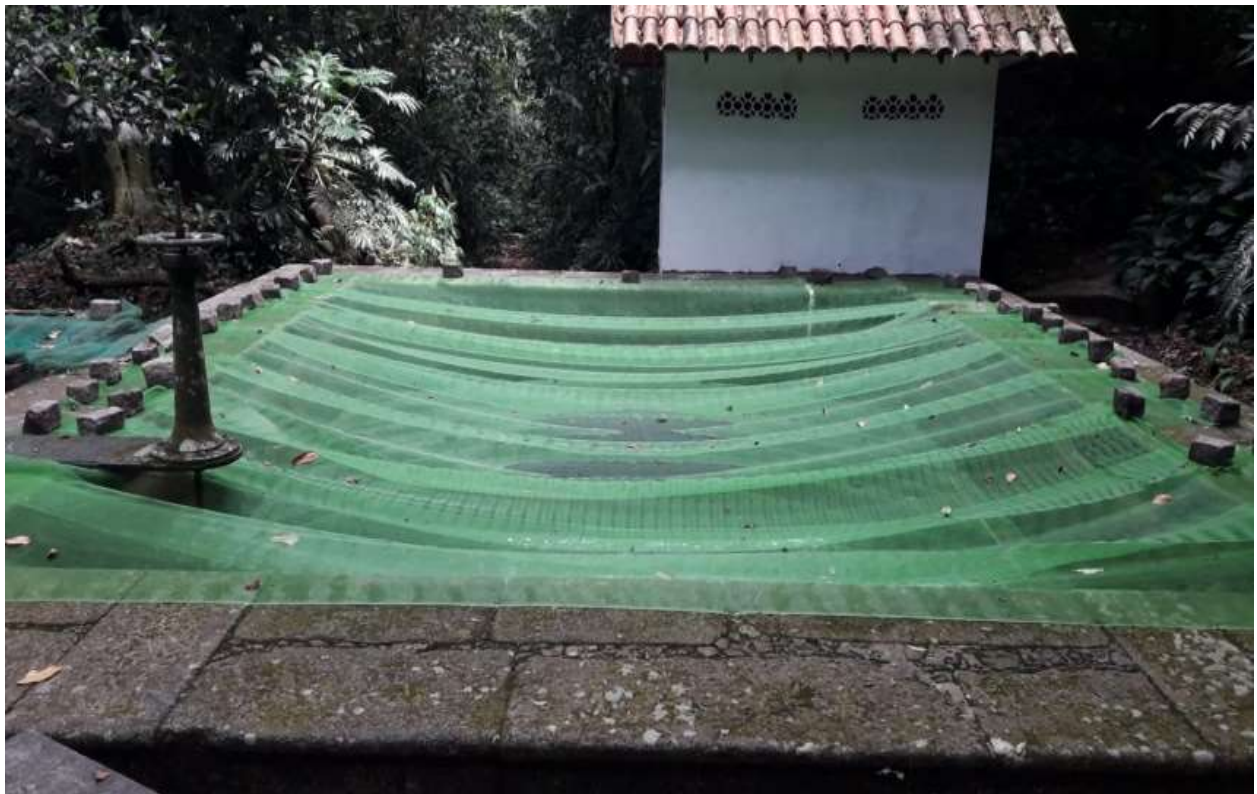
Reservatório/Tratamento da UT Gávea Pequena
