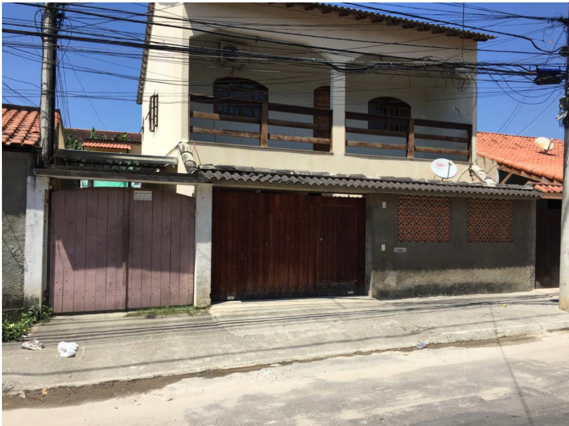
Travessa João Leite, nº 56 - Residência do Sr Yvens de Freitas
