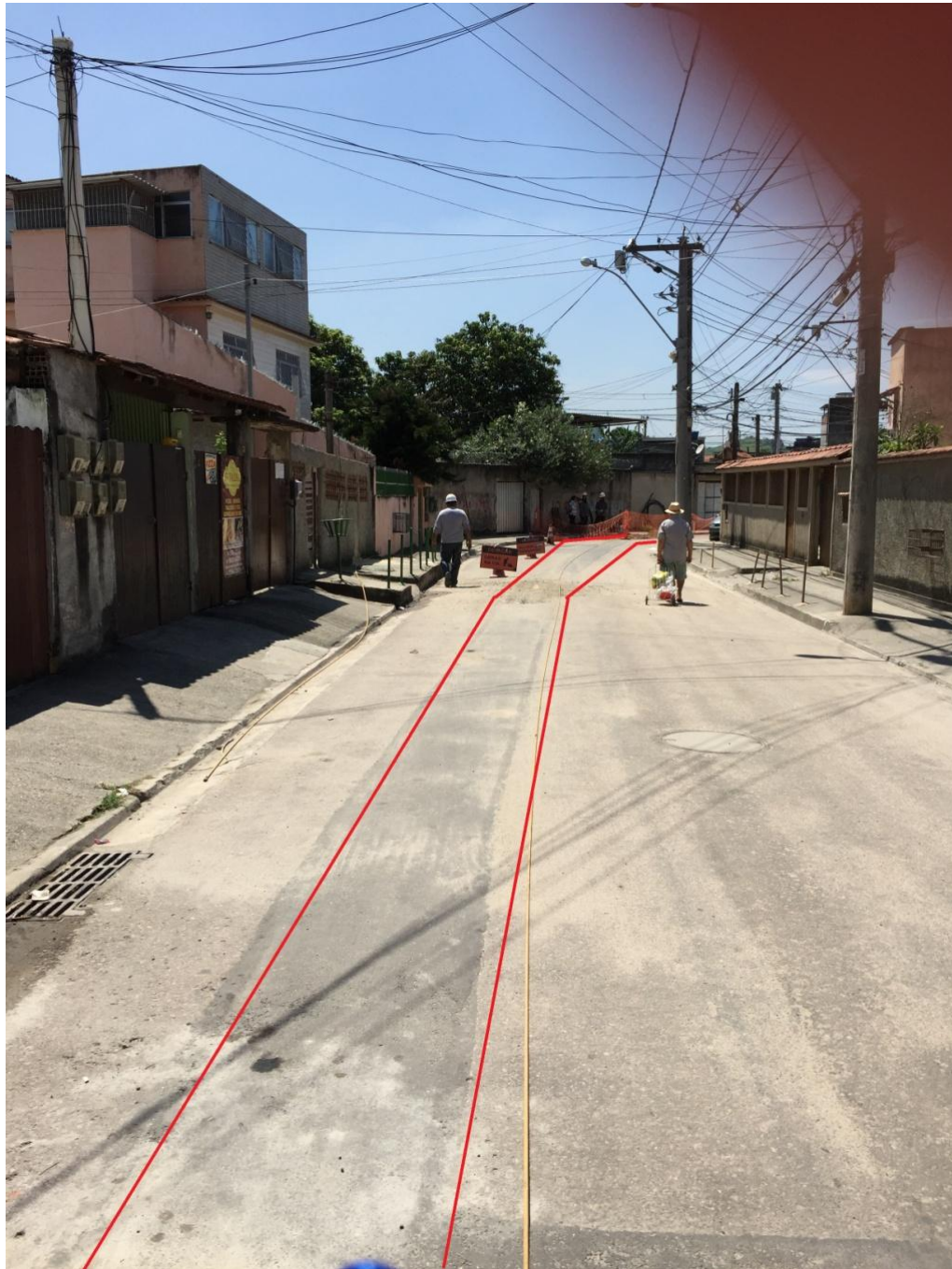
Trecho que a ENEL recuperou a rede coletora de esgoto
