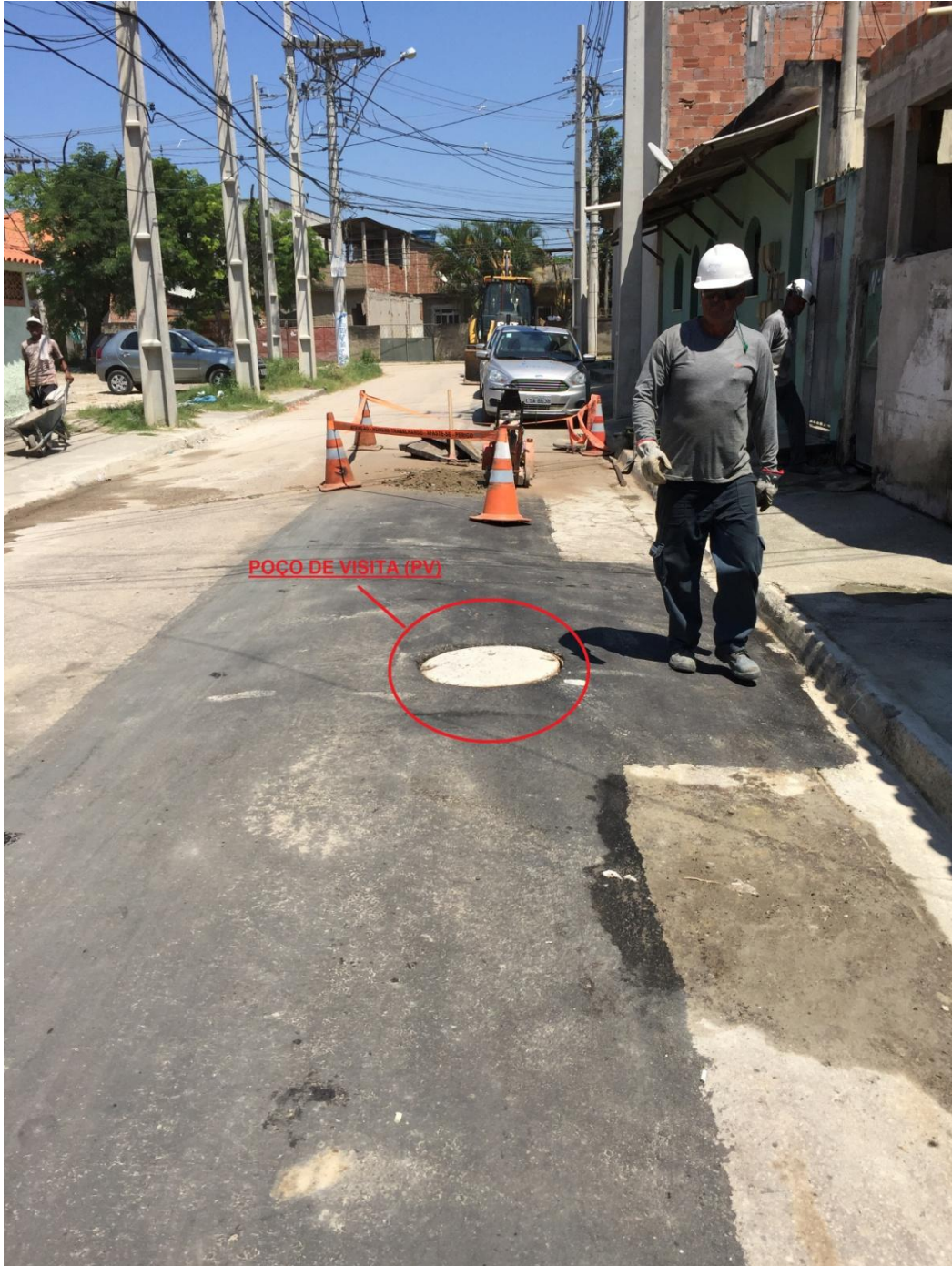
PV intermediário construído para melhorar o escoamento dos efluentes sanitários
