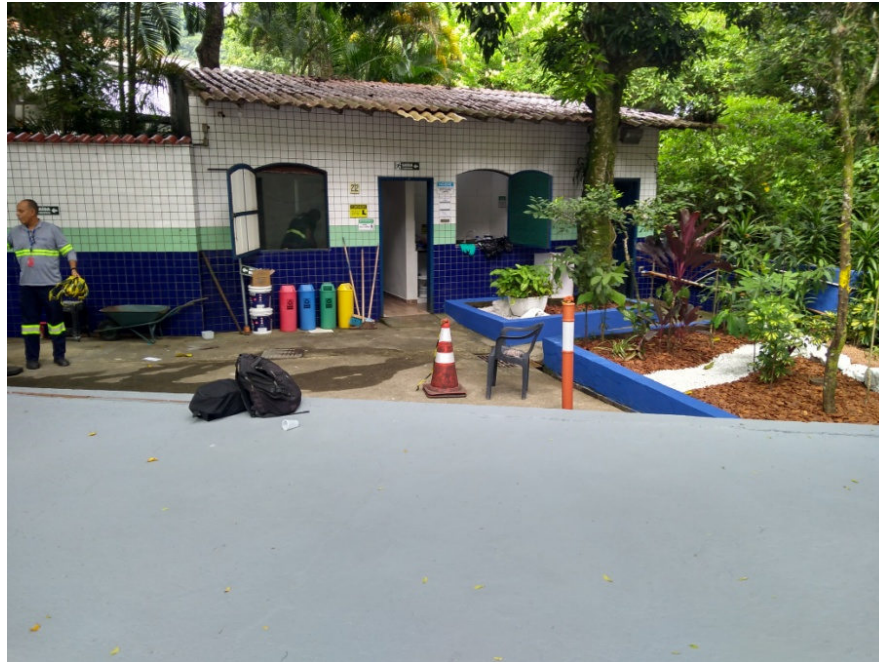
Laboratório, Administração e Depósito de Produtos Químicos com o Reservatório em primeiro plano.
