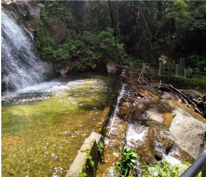
Barragem/Captação da Cascatinha
