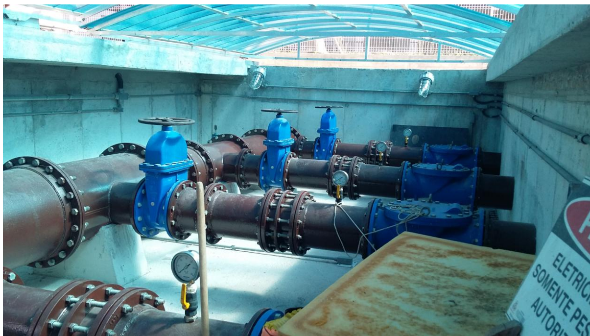
BARRILETE DE SUÇÃO - DETALHE
