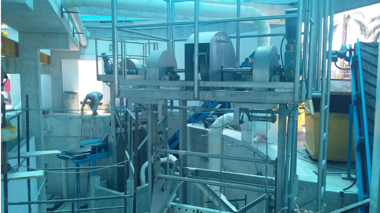
VISTA GERAL INTERNA DA EE - EM ACABAMENTO
