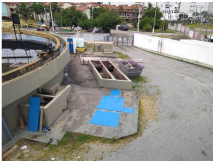
Foto 01 – Área Interna da Estação de Tratamento de Esgoto (ETE) Arraiial do Cabo Centro
