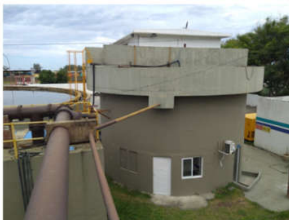
Foto 12 – Adensador de Lodo
