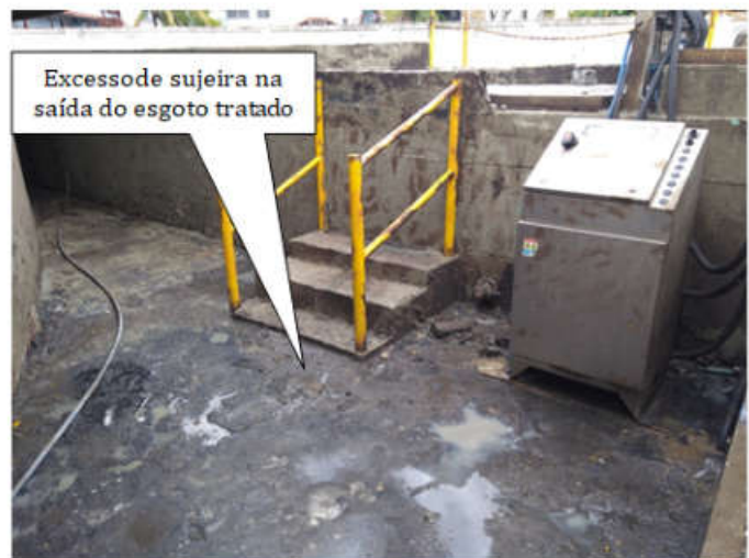
Foto 19 – Saída do Esgoto Tratado e Desinfecção com Ultravioleta (vestígio de transbordamento de esgoto)
