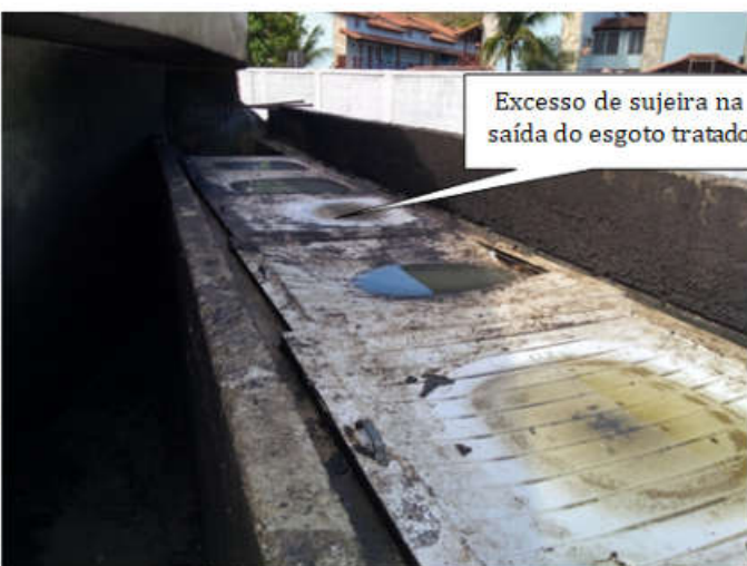
Foto 19 – Saída do Esgoto Tratado e Desinfecção com Ultravioleta (vestígio de transbordamento de esgoto)
