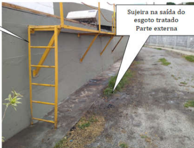
Foto 20 – Parte externa da Saída do Esgoto Tratado (vestígio de transbordamento de esgoto)
