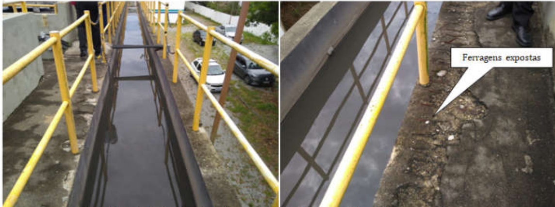
Foto 9 – Calha de Recirculação da Água do Adensador para início do Processo de Tratamento
