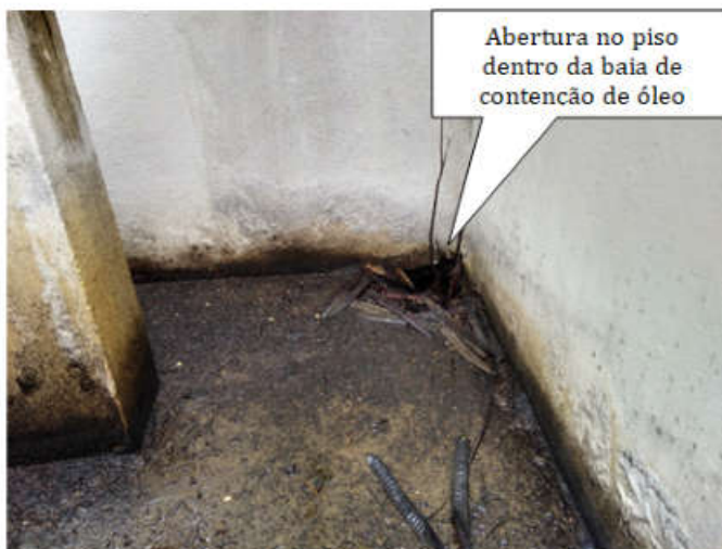
Foto 22 – Abertura no piso dentro da baia de contenção de óleo (já reparado)
