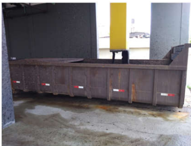
Foto 15 – Retirada do Lodo e Lançamento na Caçamba (7m³ dia)
