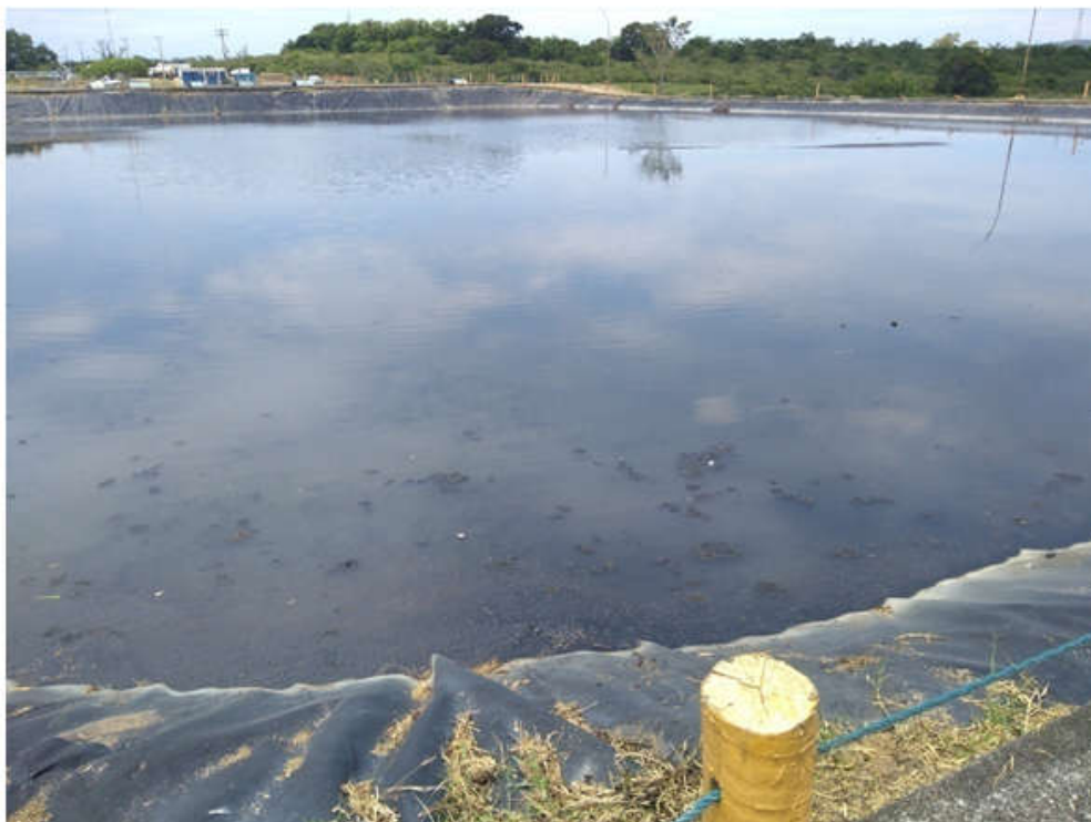
Figura 8 – Lagoa de decantação, (saturada com ilhas de lodo)
