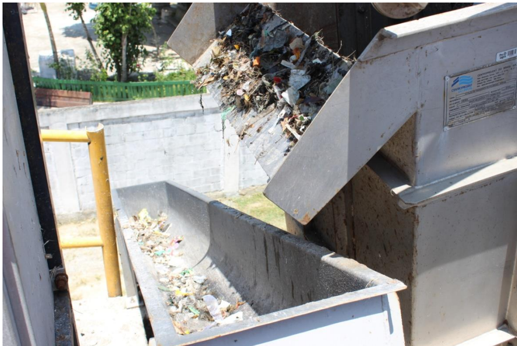
Foto 08 – Gradeamento mecanizado retirando os Resíduos Sólidos
