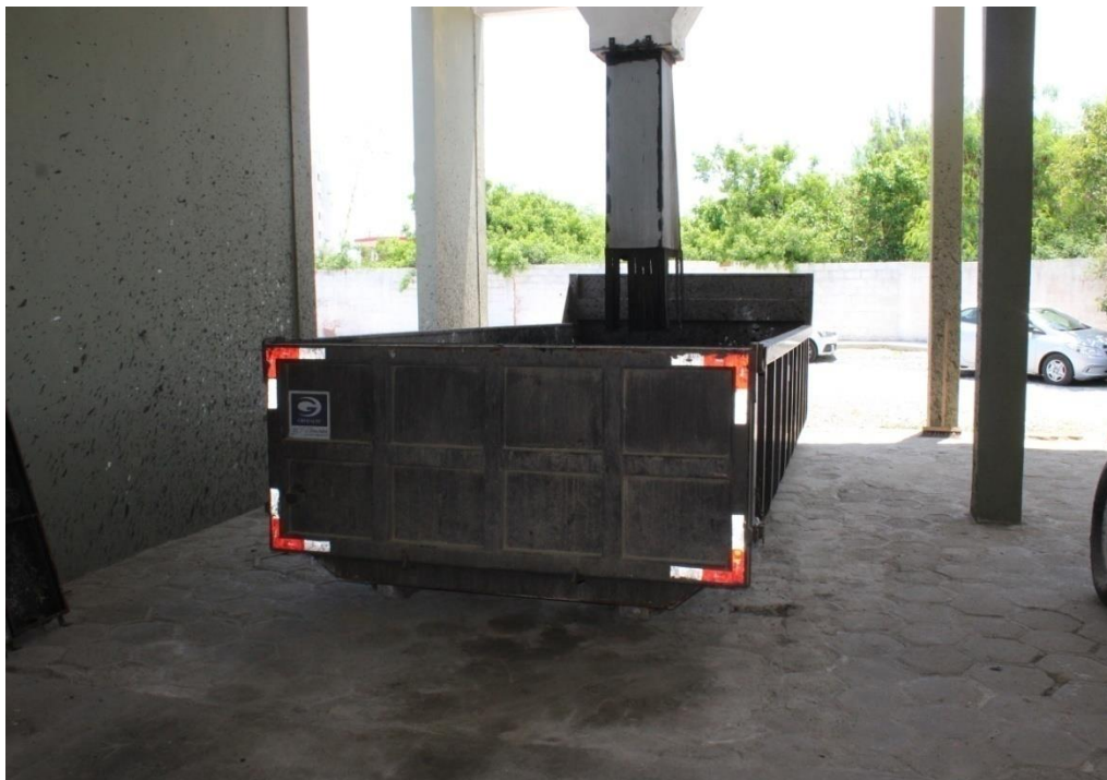
Foto 21 – Retirada do lodo e lançamento na caçamba (7m 3 dia)
