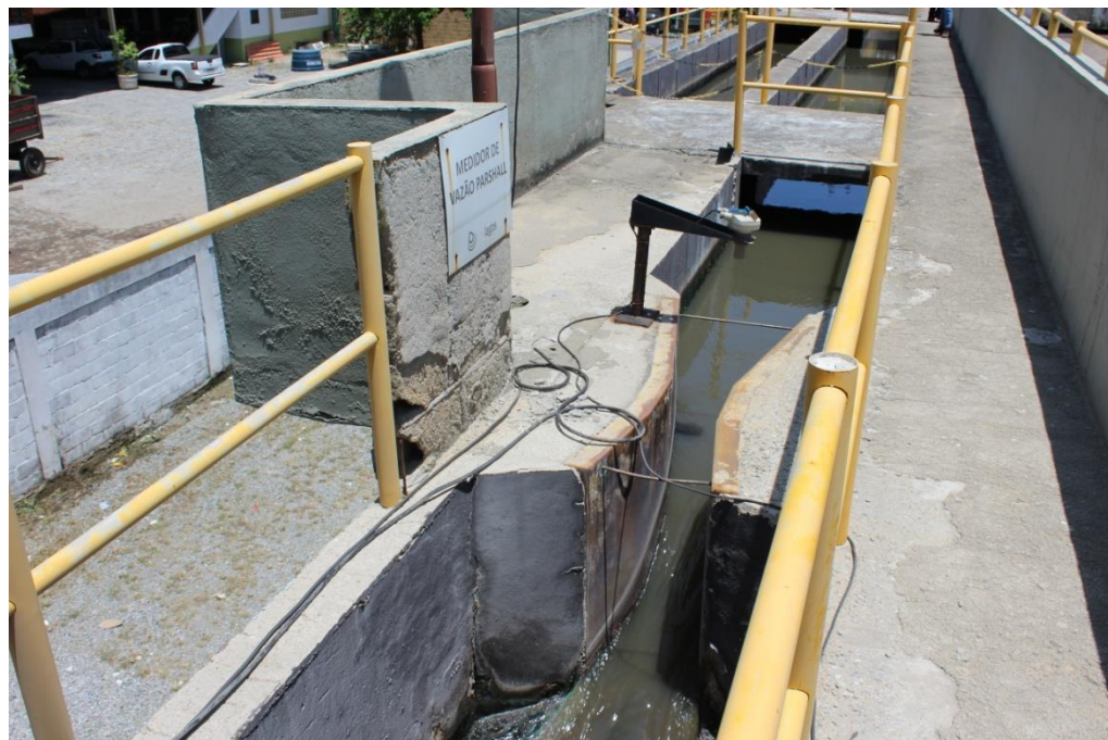
Foto 11 – Medidor de Vazão Parshall
