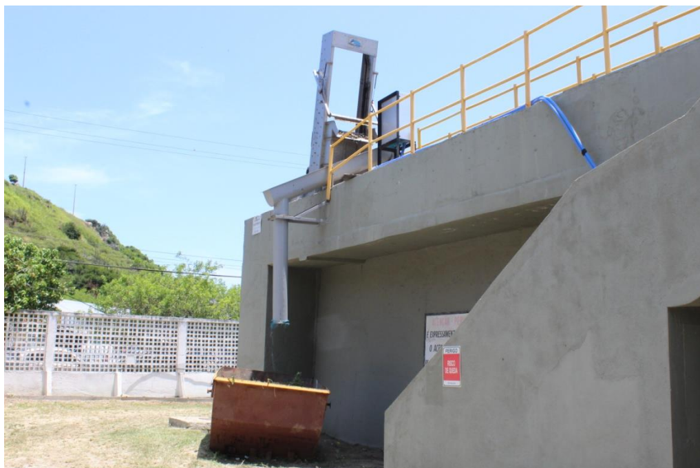
Foto 09 – Gradeamento mecanizado lançando Resíduos Sólidos na caçamba
