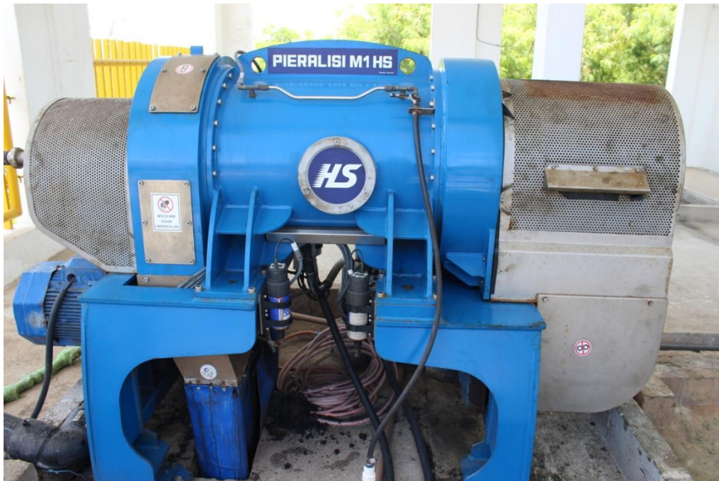
Foto 20 – Adensador mecânico
