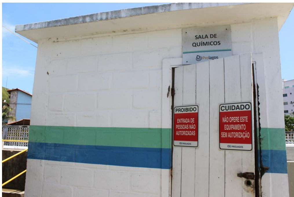
Foto 29 – Sala de Químicos
