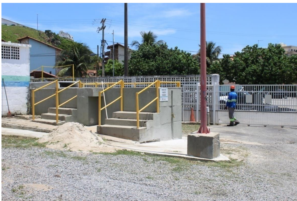
Foto 01 – Entrada da ETE de Arraial do Cabo
