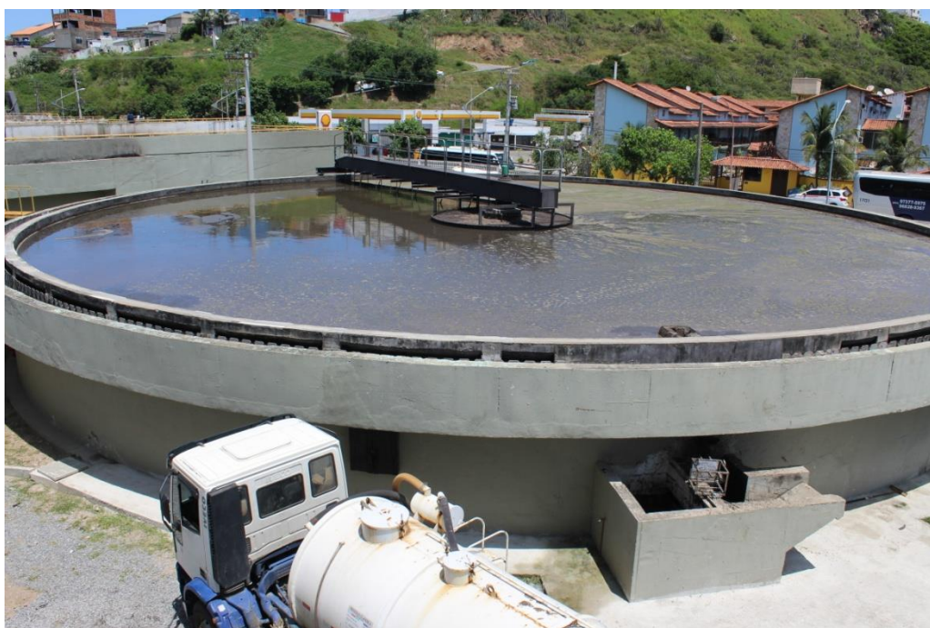
Foto 19 – Decantador (vista superior)
