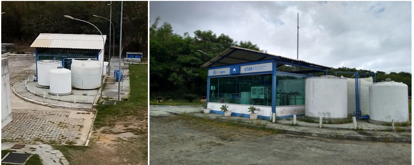
Foto 24 – Estação de Tratamento de Água de Reúso - ETAR (fora de uso)
