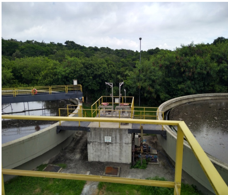
Foto 18 – Elevatória de recirculação de lodo dos decantadores 1 e 2. Destaque para corrosão nas tubulações e conjunto das bombas
