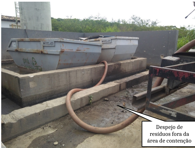
Foto 2 – Caçambas de recebimento de caminhões limpa-fossa. Mesmo com duas baias internas de contenção, ainda ocorre o despejo de resíduos no solo
