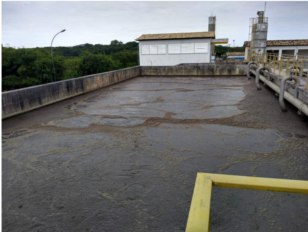
Foto 11 – Dois tanques de aeração com difusores de bolha fina
