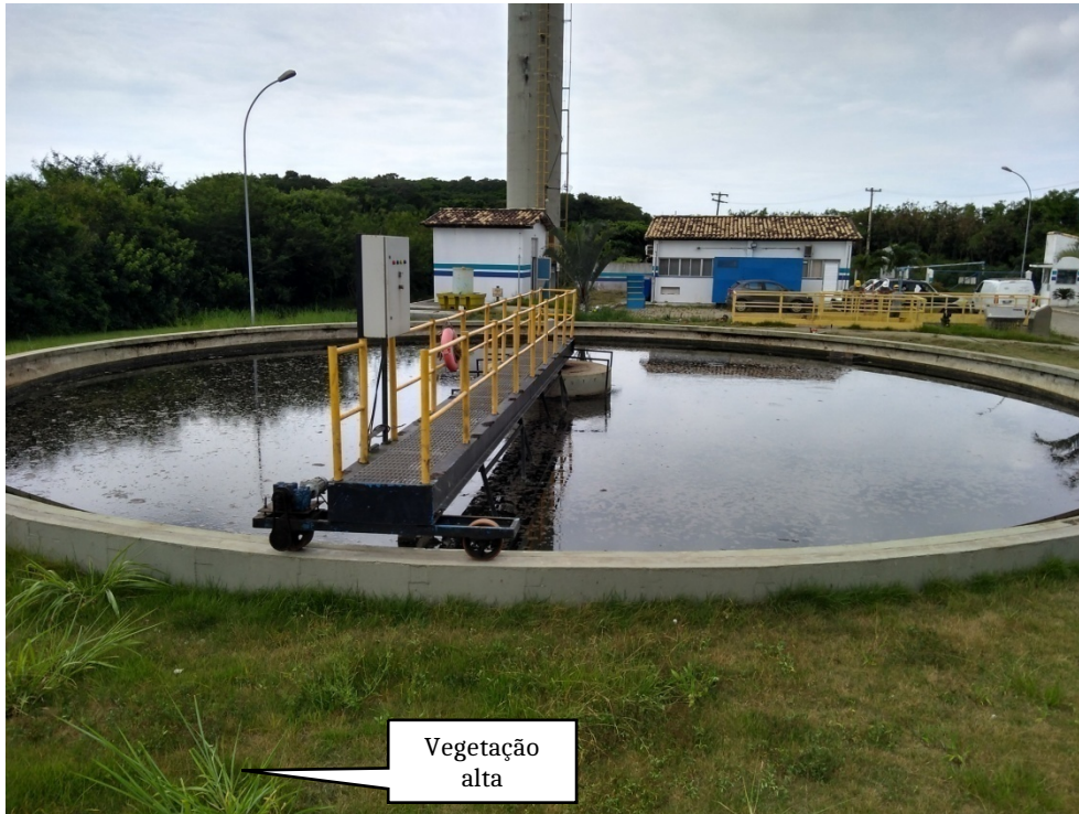
Foto 19 – Decantador secundário 3 (antigo terciário)
