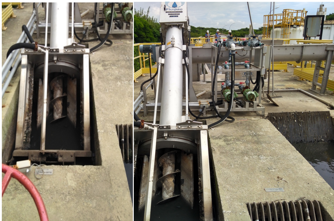
Foto 4 – Peneira Rotativa com temporizador, aparentemente (fora de carga) comporta fechada e direcionado para as grades de limpeza manual para retenção de resíduos sólidos grosseiros e finos
