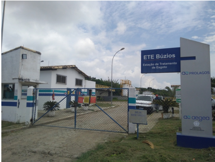
Foto 1 – Entrada da Estação de Tratamento de Esgoto
