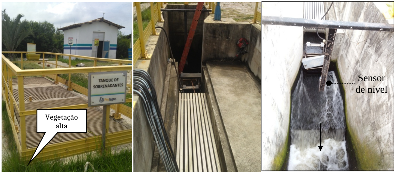
Foto 25 – Tratamento terciário: desinfecção com lâmpadas ultravioleta, com destaque para a comporta de controle de nível para manter o equipamento sempre em contato com o efluente final
