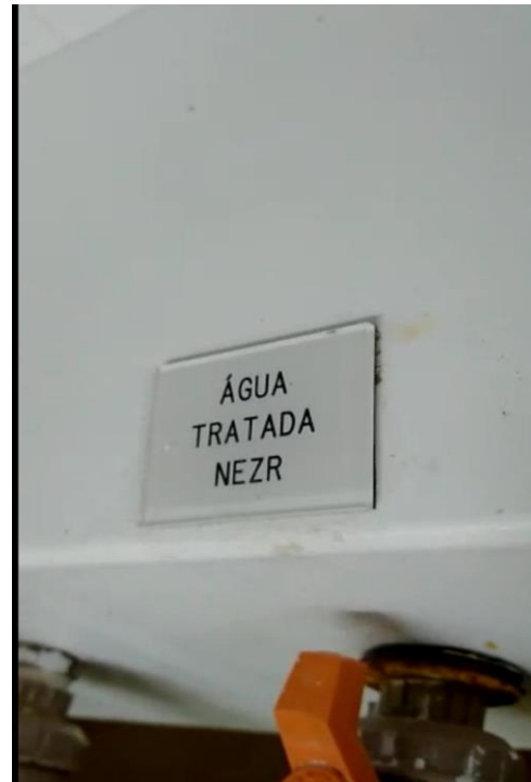
Foto 15 – Nova Elevatória da Zona Rural
