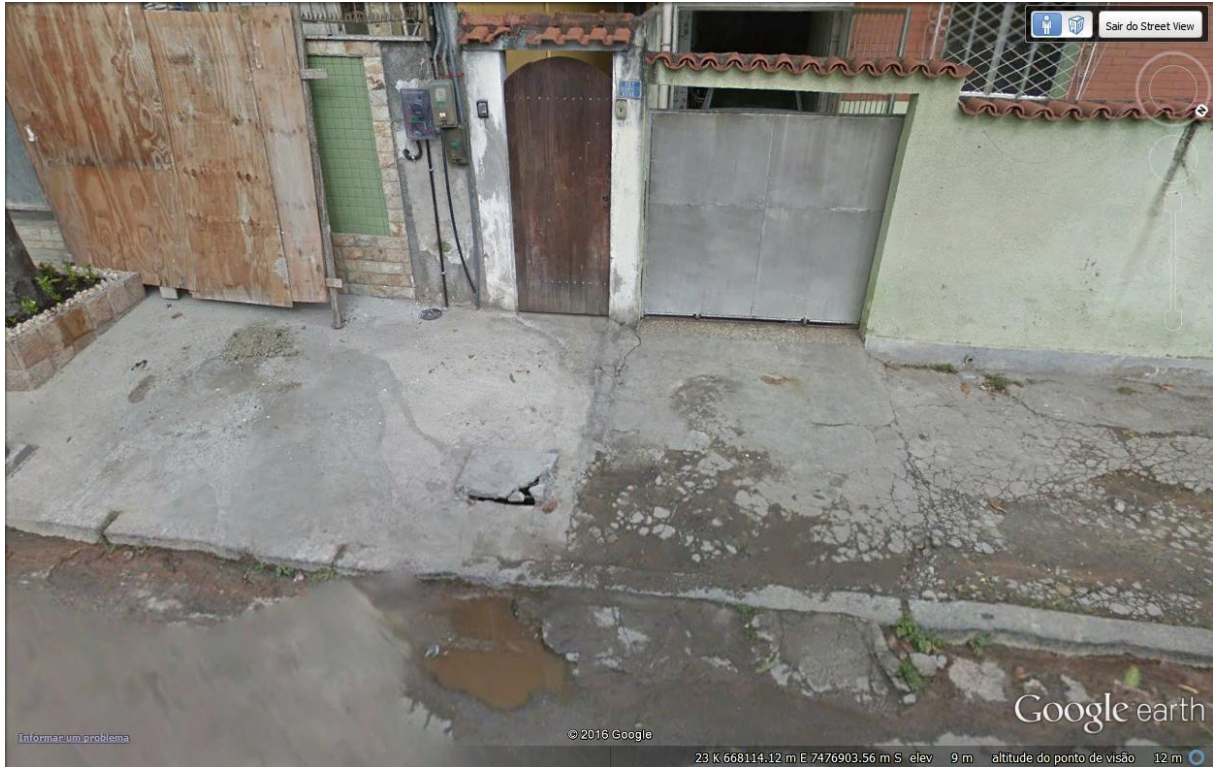
DETALHE DA CAIXA DE INSPEÇÃO - IMAGEM DO GOOGLE EARTH DE 14-05-2016
