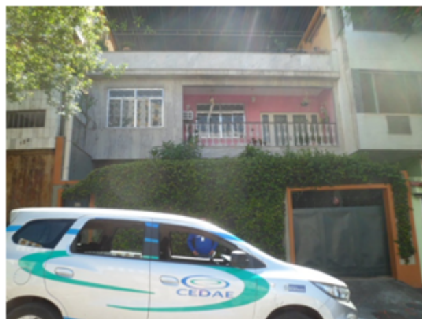
Foto 03 – Fachada do Prédio – Rua São Patrício, 128
