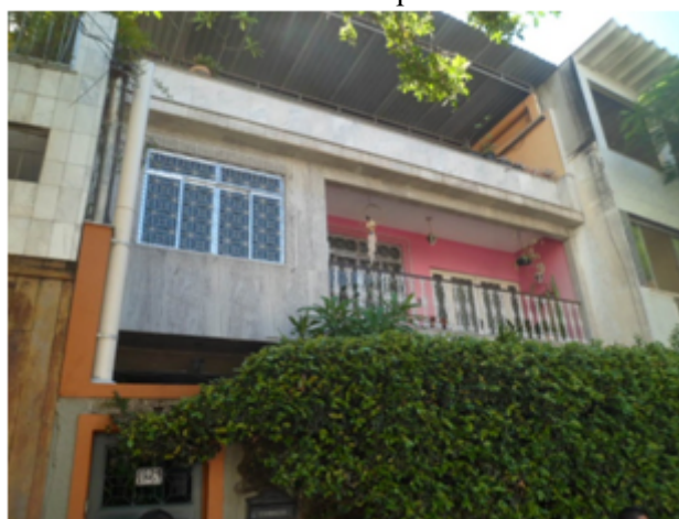
Foto 02 – Fachada do Prédio – Rua São Patrício, 128
