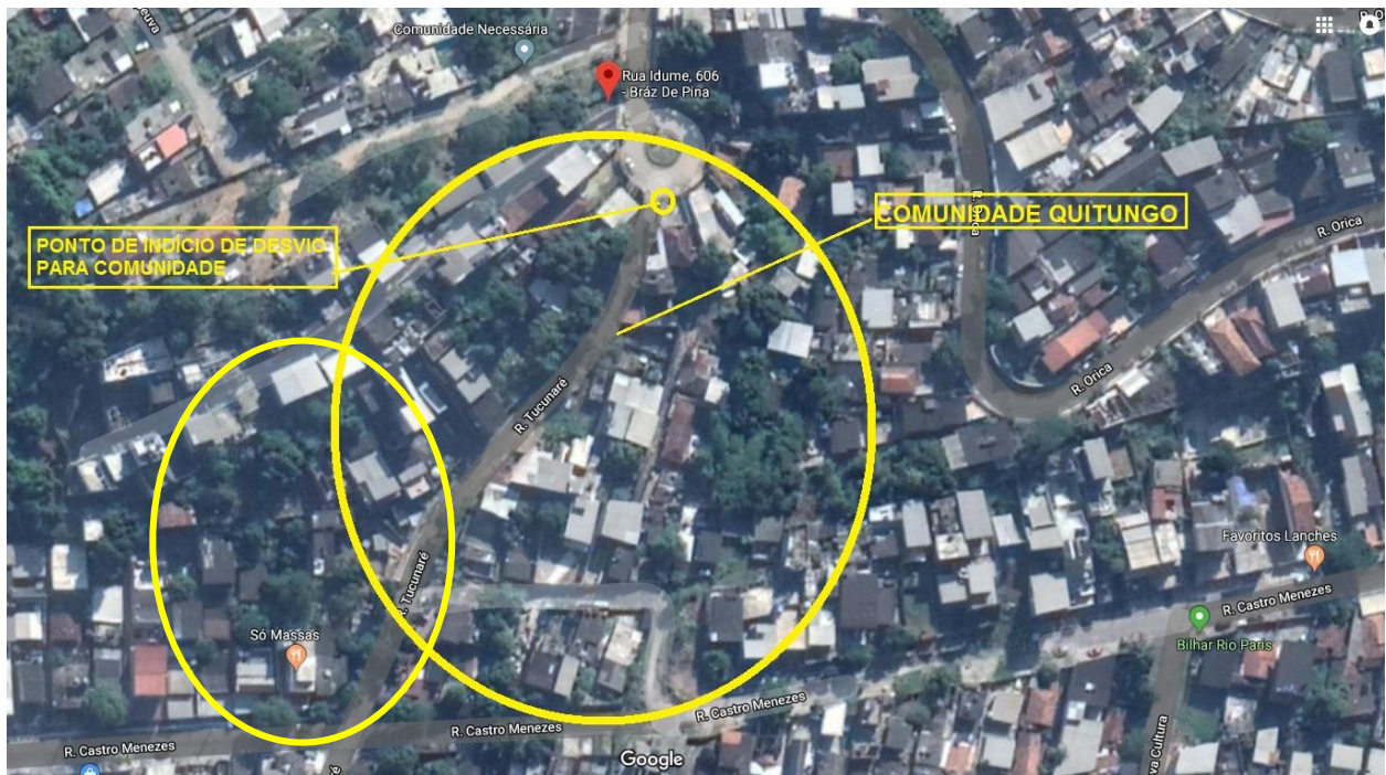
VISTA AÉREA COM INDICAÇÃO DO DESVIO DE RAMAL E A COMUNIDADE QITUNGO
