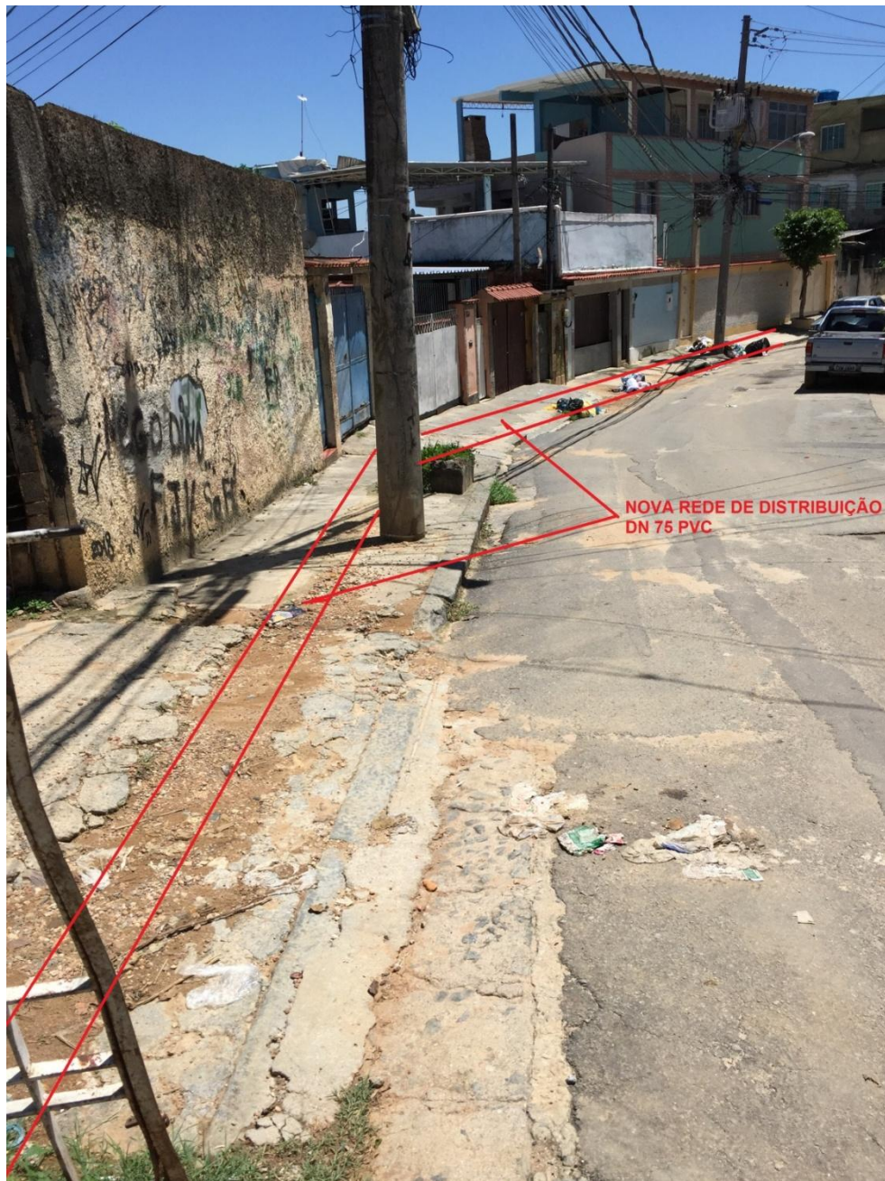
LOCAL DO ASSENTAMENTO DA TUBULAÇÃO DN75MM
