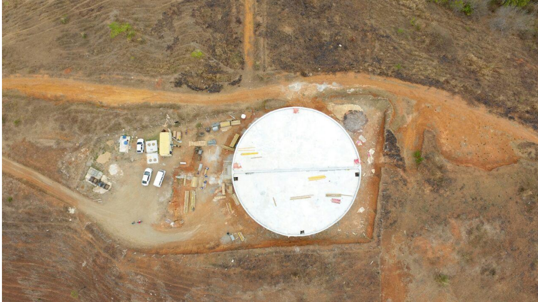
VISTA AÉREA - NOVO RESERVATÓRIO DE ÁGUA TRATADA - CAPACIDADE DE 4.000 M 3
