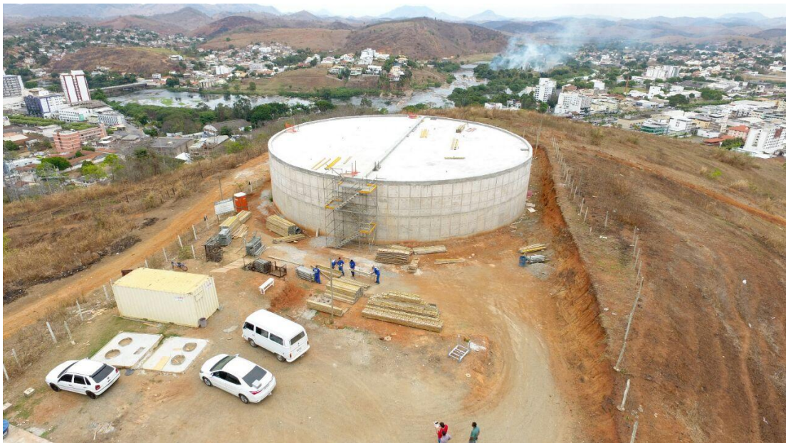
VISTA AÉREA - NOVO RESERVATÓRIO DE ÁGUA TRATADA - CAPACIDADE DE 4.000 M 3
