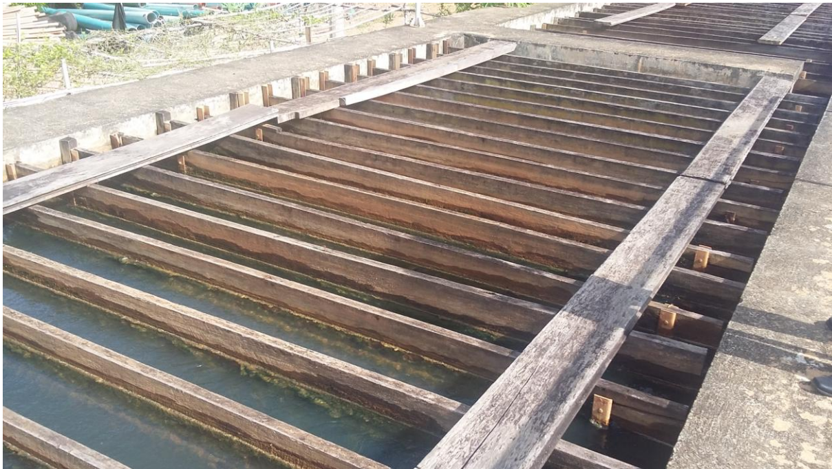
VISTA PARCIAL DOS FLOCULADORES
