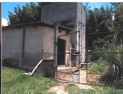
Reservatório principal (vista geral, portão e alambrado)
