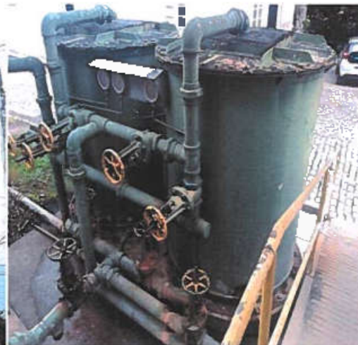
Filtro metálico fechado
