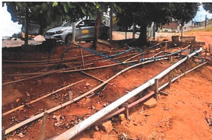
Tubulação de adução de saída da ETA Batalha - Reforço de 1/2" em tubos de PEAD
