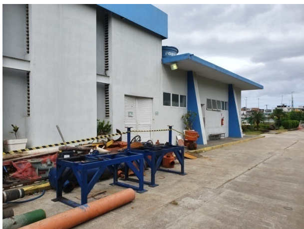
Foto 9 - Equipamentos desmontados para remoção
