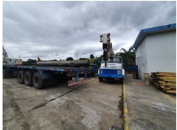
Foto 20 – Equipamentos utilizados para remoção
