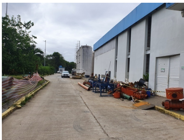
Foto 12 - Equipamentos desmontados para remoção
