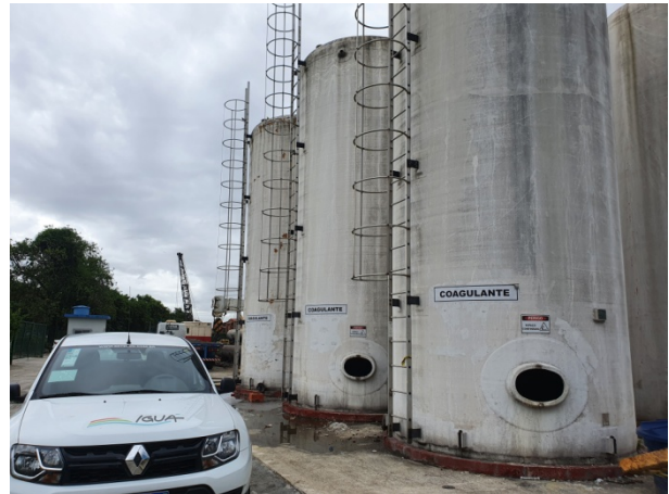
Foto 14-Tanques de coagulante VAZIOS (22/03/2022)
