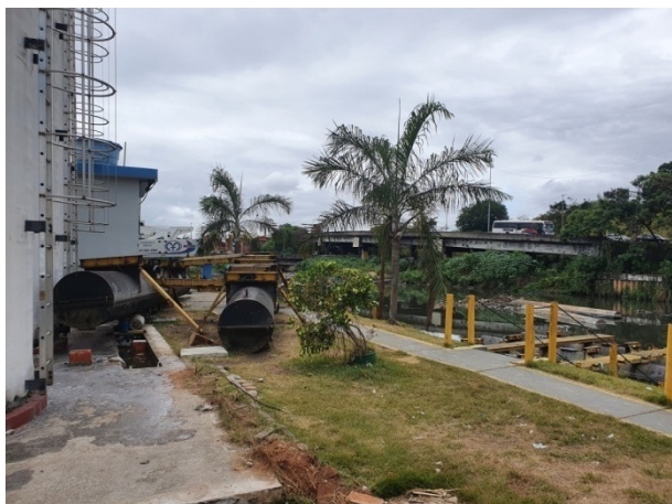
Foto 7 - Equipamentos desmontados para remoção
