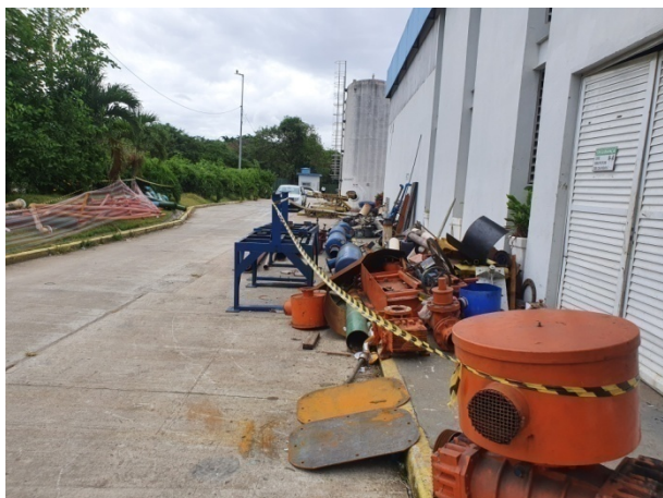
Foto 13 - Equipamentos desmontados para remoção
