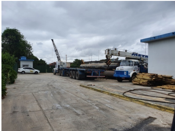
Foto 19 – Equipamentos utilizados para remoção
