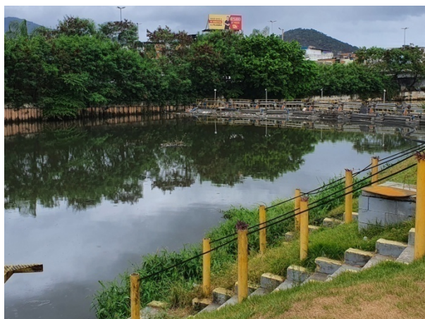
Foto 8 - Bacia de Coagulação/Floculação (22/03/2022)
