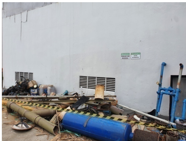
Foto 14 - Equipamentos desmontados para remoção
