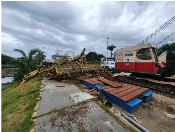
Foto 3 - Equipamentos desmontados para remoção
