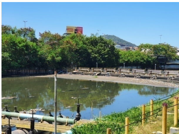
Foto 7 - Bacia de Coagulação/Floculação (11/03/2022)
