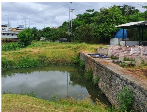
Foto 12 - Lodo gerado pelo tratamento (22/03/2022)
