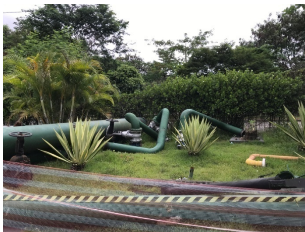
Foto 10 - Equipamentos desmontados para remoção
