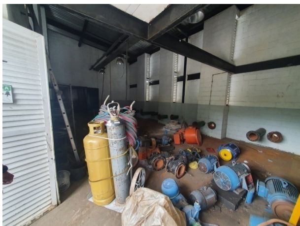
Foto 15 - Equipamentos desmontados para remoção
