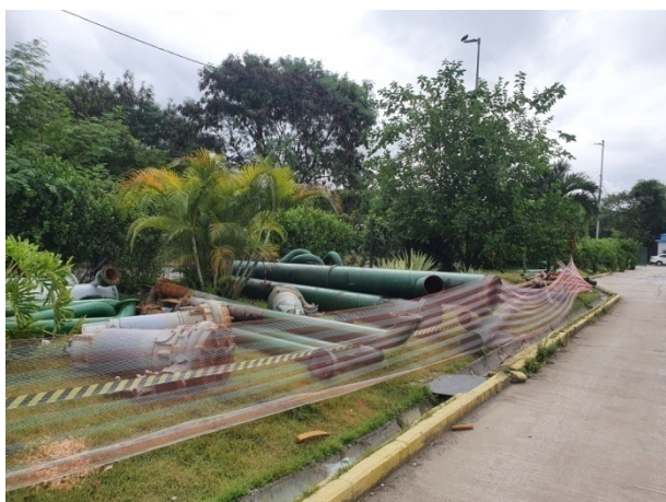
Foto 11 - Equipamentos desmontados para remoção
