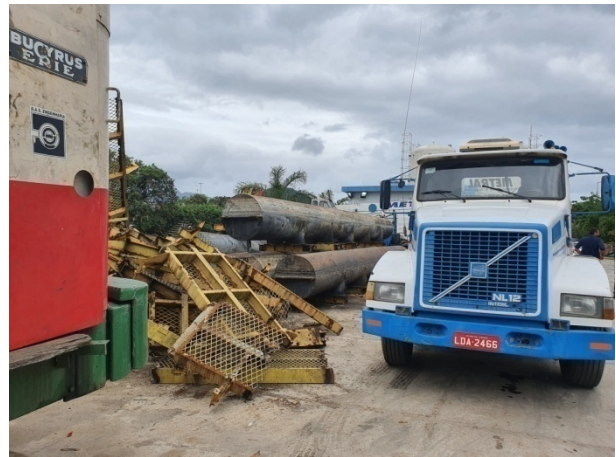
Foto 4 - Equipamentos desmontados para remoção
