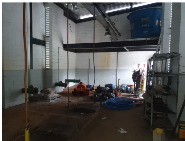
Foto 16 - Equipamentos desmontados para remoção
