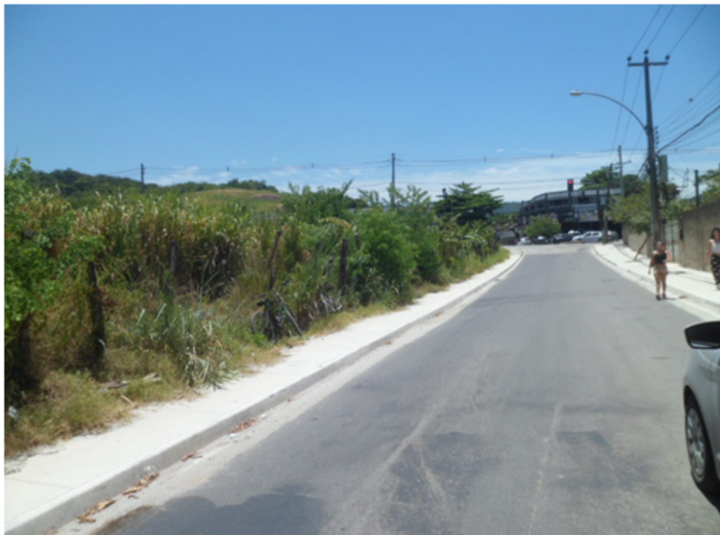
Foto 01 – Rua dos Cajueiros – Guaratiba (asfalto e calçadas novas)
