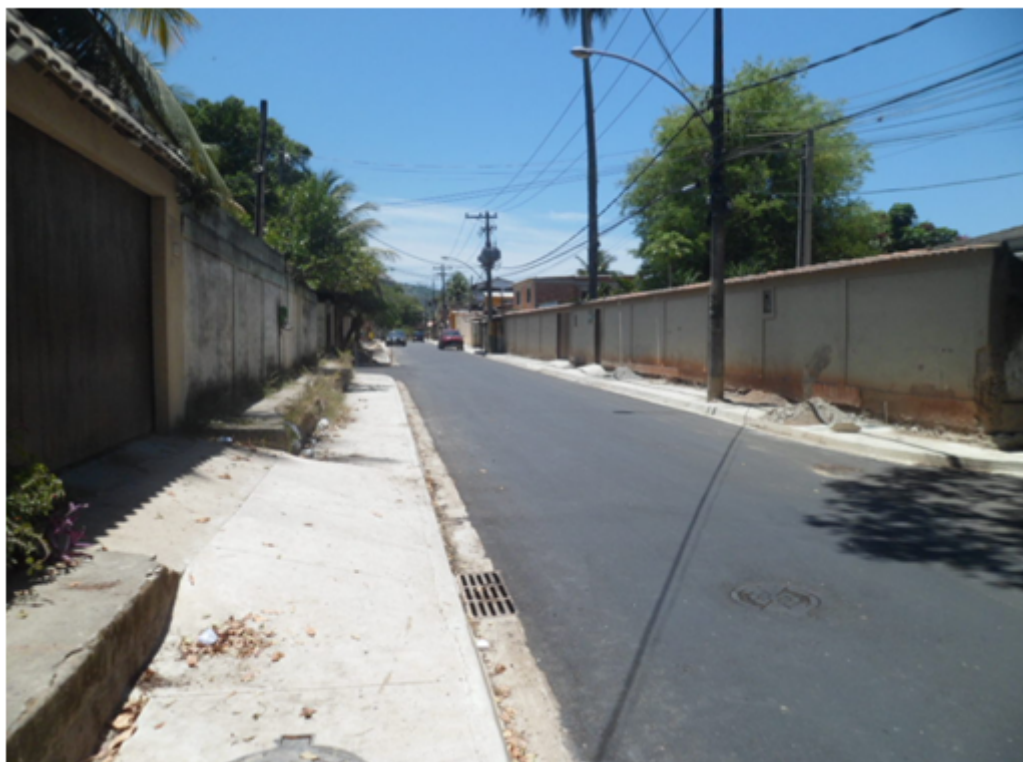
Foto 02 – Rua dos Cajueiros – Guaratiba (asfalto e calçadas novas)
