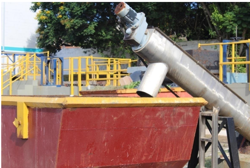
Foto 11 – Caçamba de Areia
