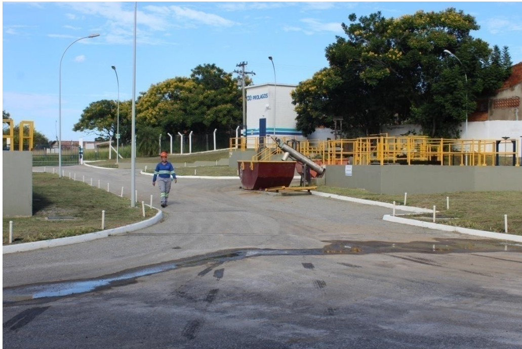
Foto 04 – Rua Principal da ETE
