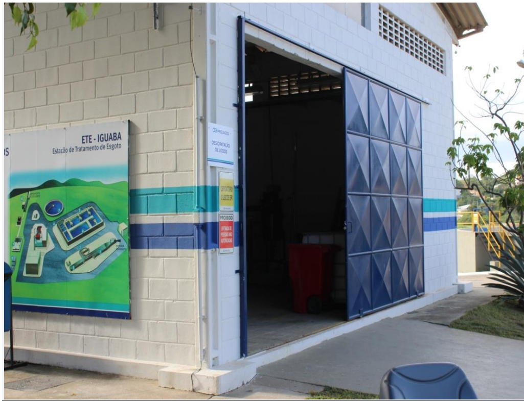
Foto 38 – Galpão de Armazenamento de Material
