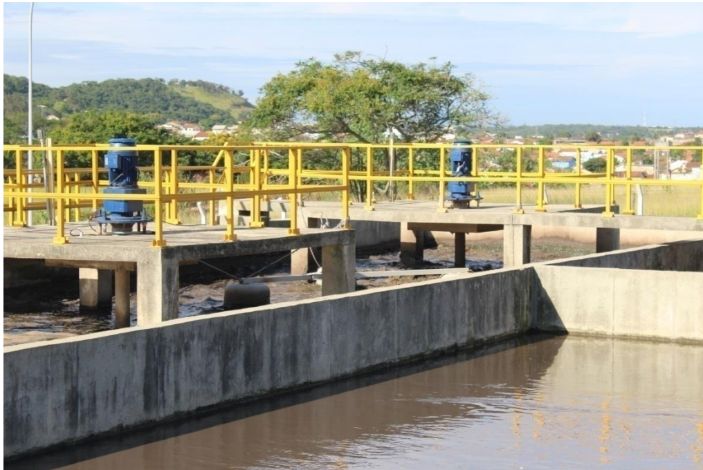
Foto 18 – Tanques de Aeração e Anóxico (vista superior)
