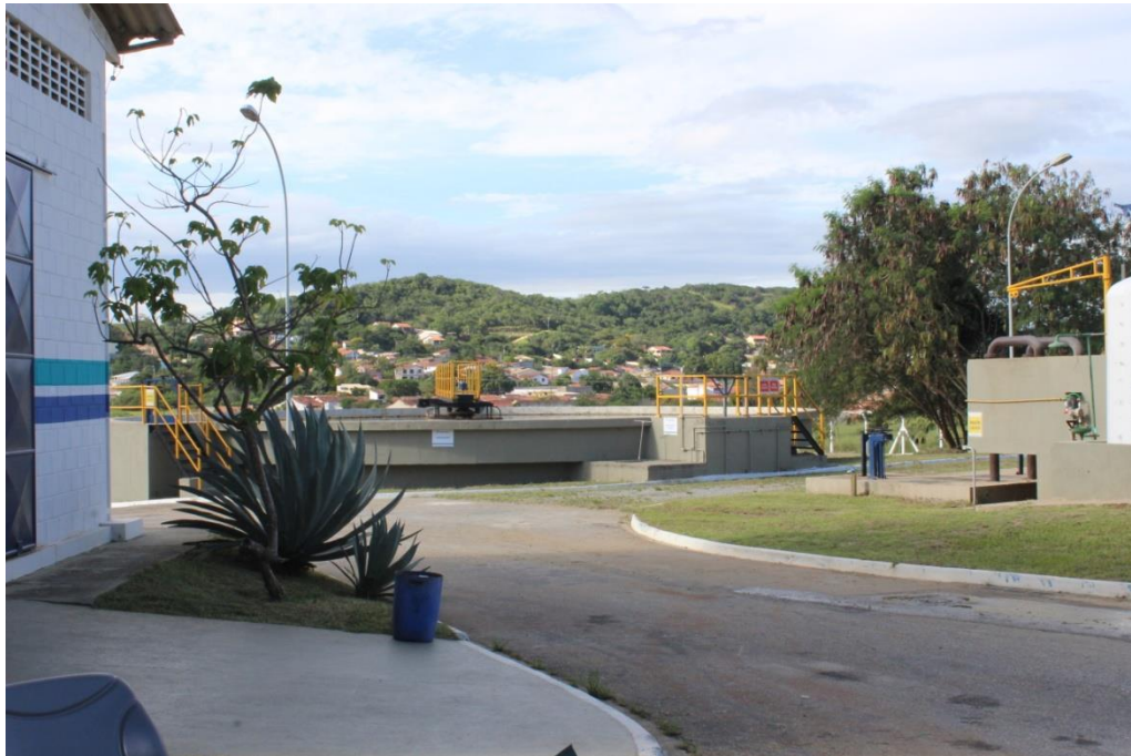
Foto 14 – Decantador ao fundo
