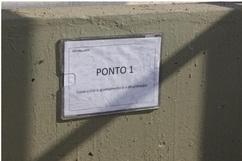
Foto 09 – Canal entre o Gradeamento e o Desarenador
