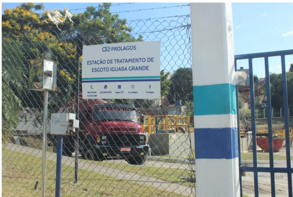
Foto 01 – Entrada da ETE de Iguaba Grande
