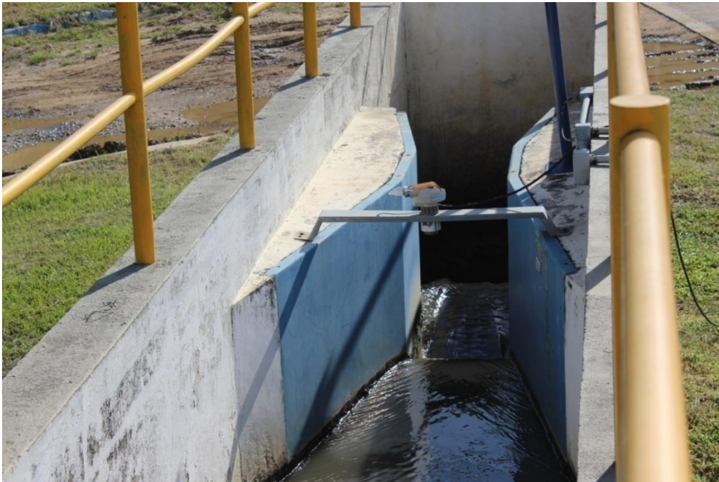
Foto 08 – Entrada do Esgoto In Natura após o Gradeamento
