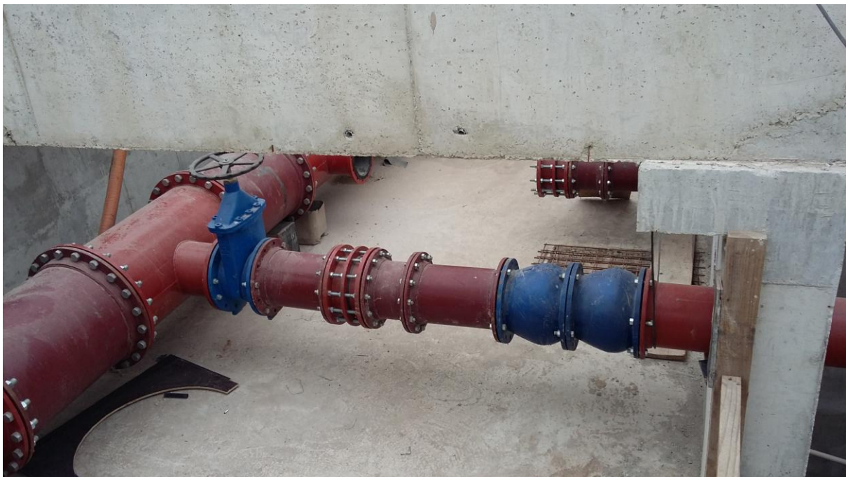
Montagem do barrilete
