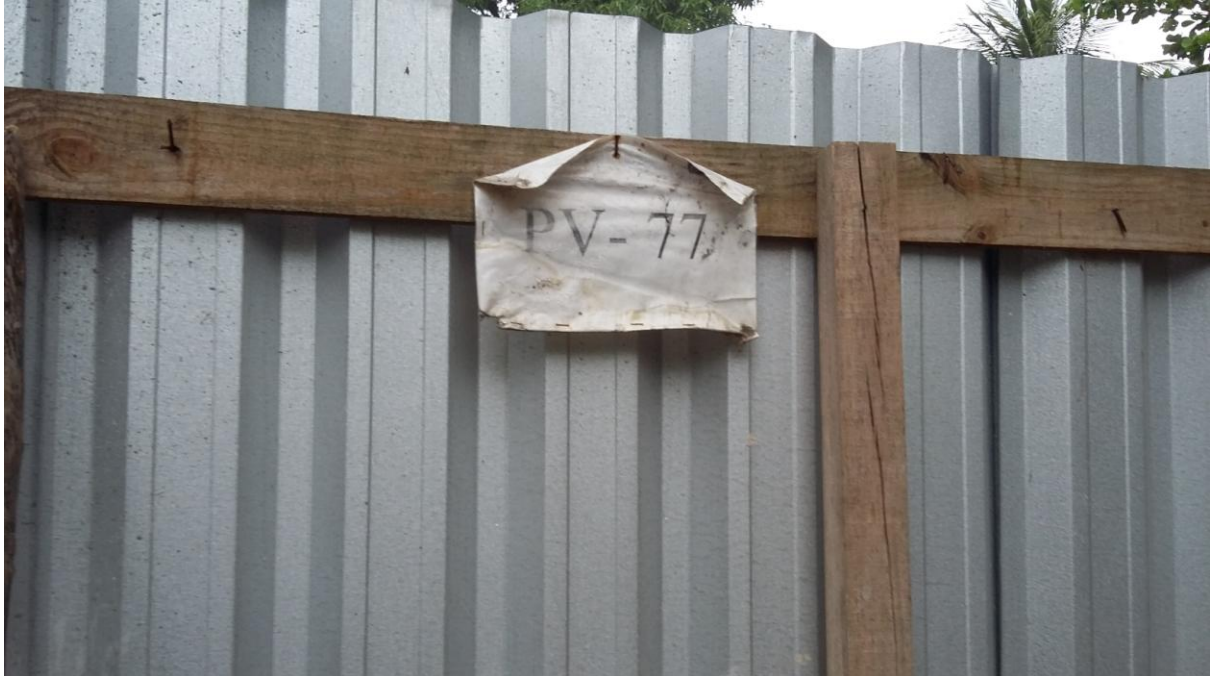
Avenida Célia Ribeiro da Silva Mendes - trecho em execução PV-77
