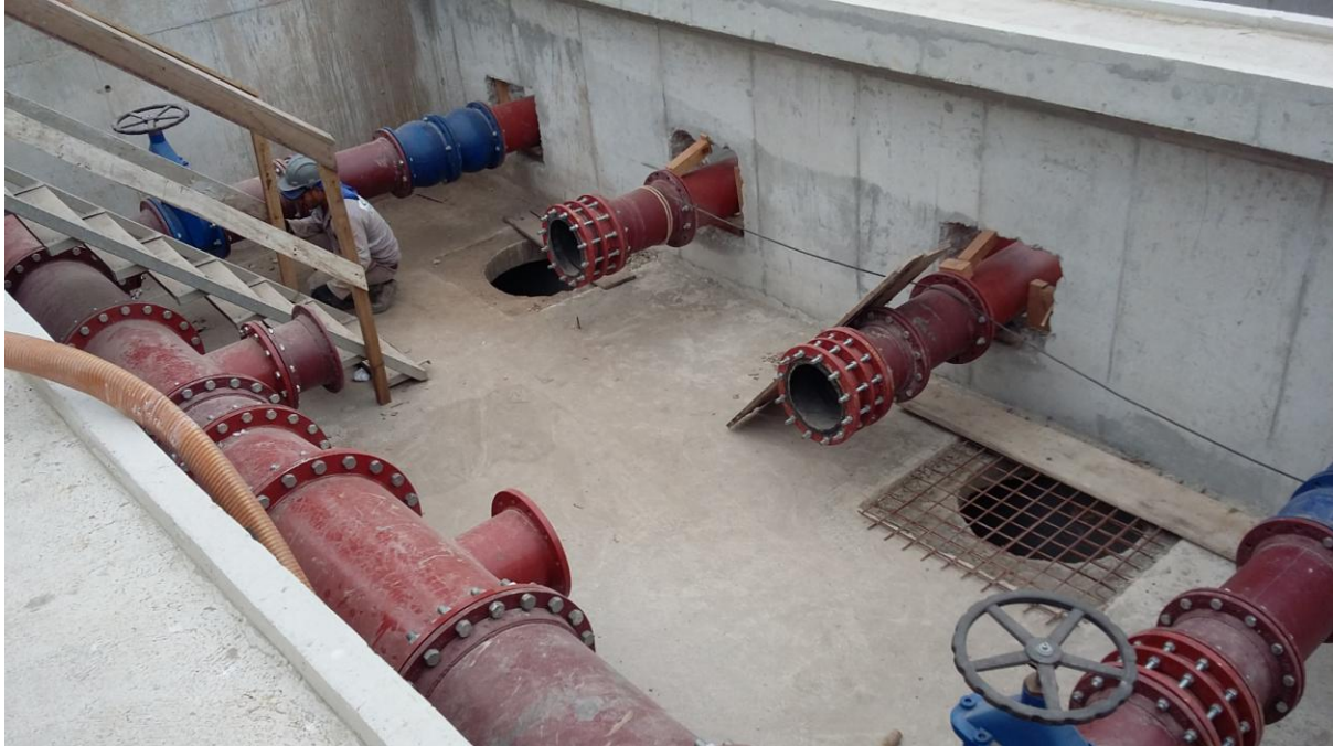
Montagem do barrilete
