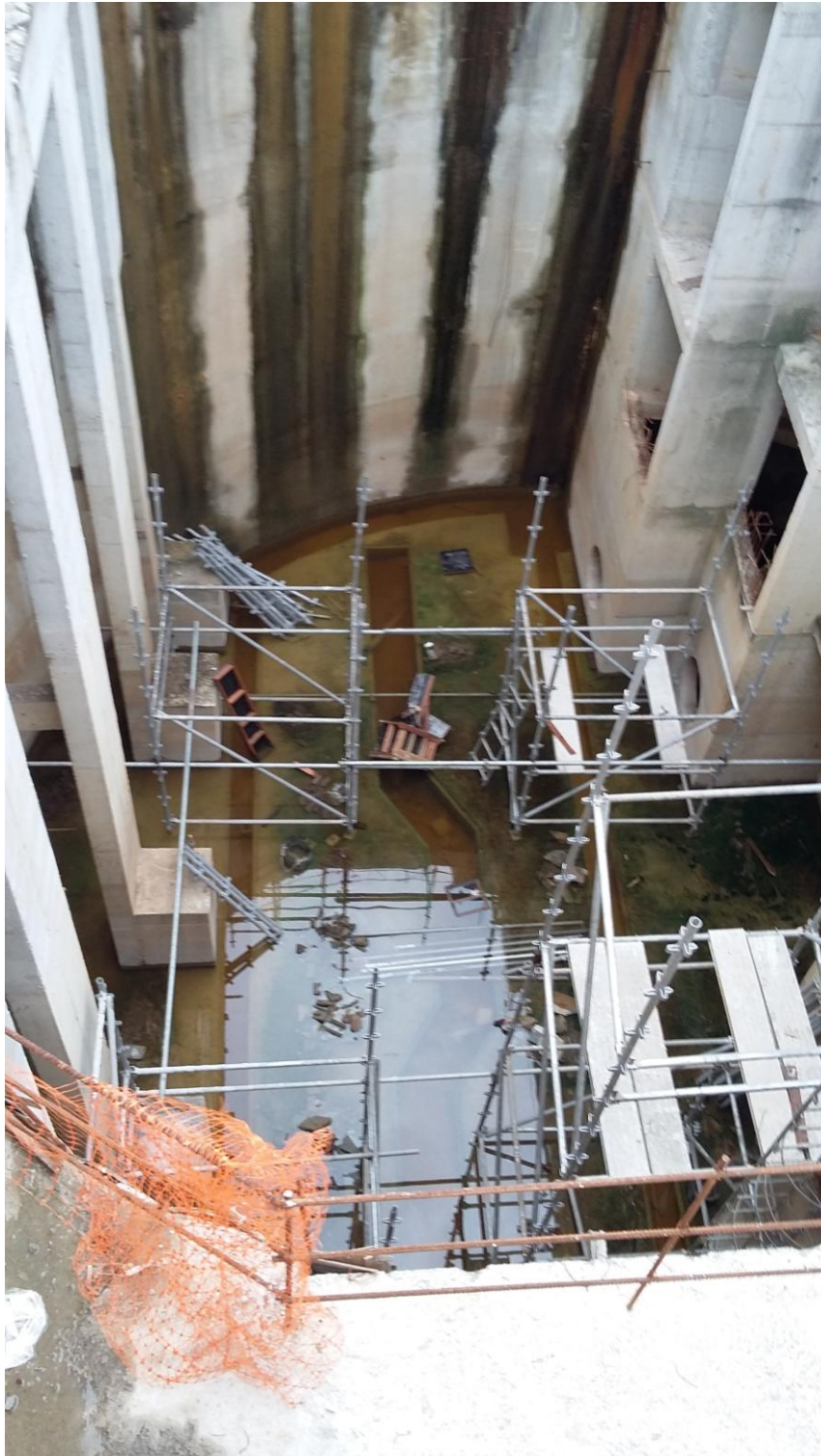
Poço de sucção
