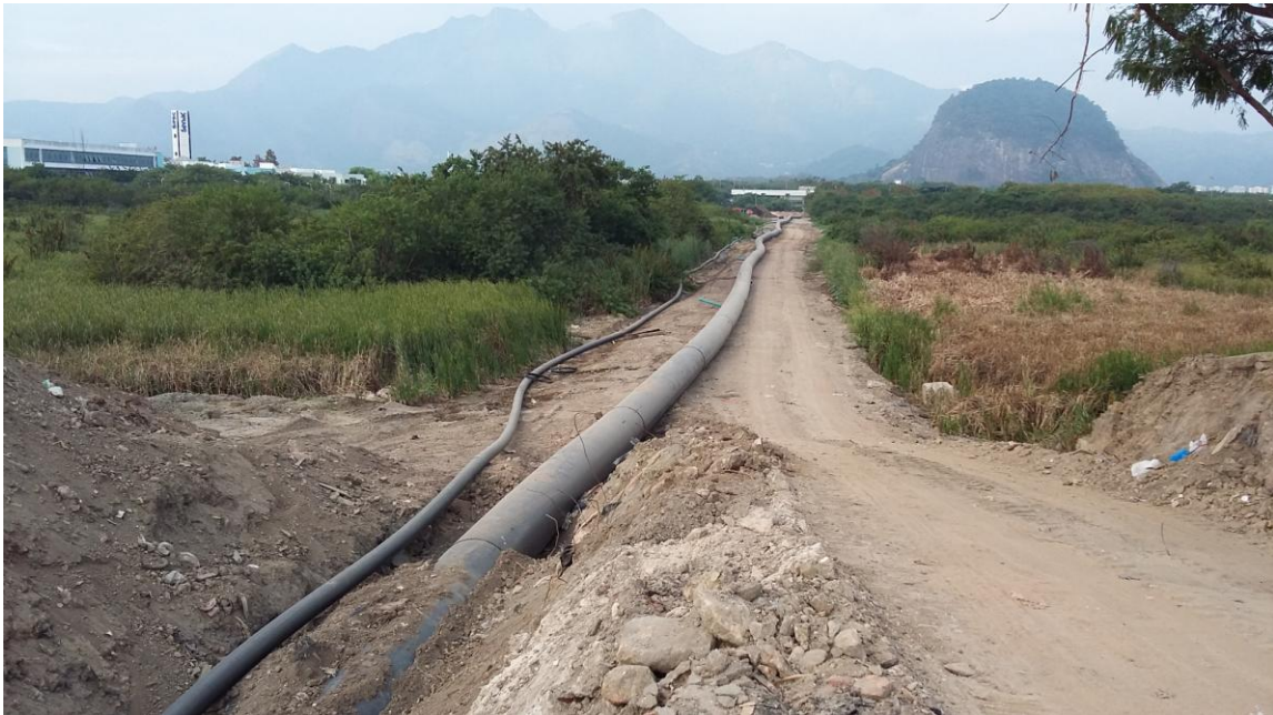
Tubulação de PEAD e diâmetro de 1000 mm - em direção à EEE de Jacarepaguá
