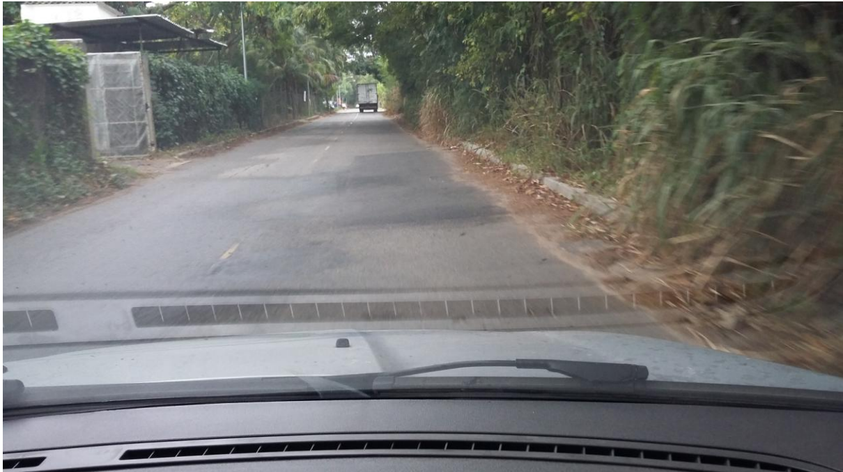
Avenida Célia Ribeiro da Silva Mendes - trecho com coletor tronco já assentado
