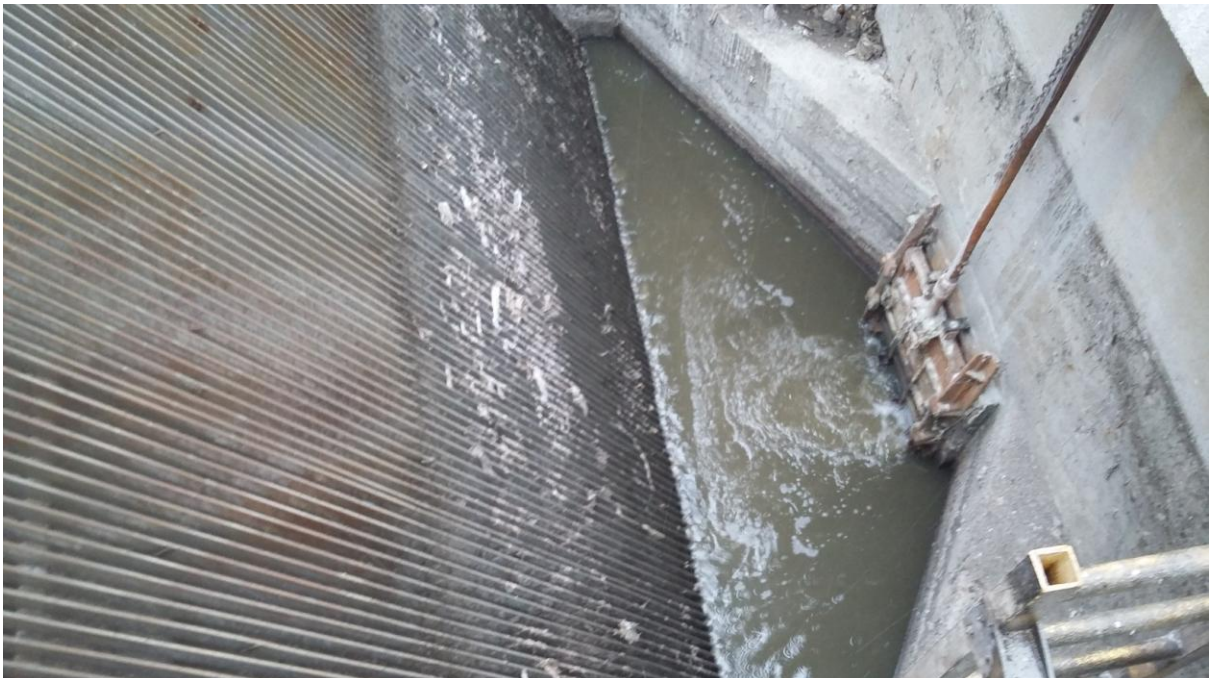
Estação Elevatória Santa Mônica - obras de ampliação em andamento
