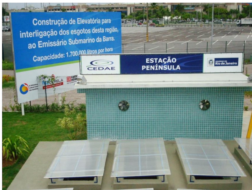
Estação Elevatória Península - Concluída em Fevereiro/2011
