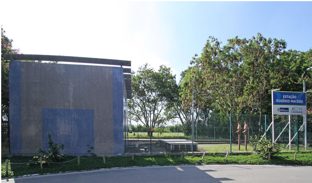
Estação Elevatória Eugênio Macedo - concluída em Novembro/2008
