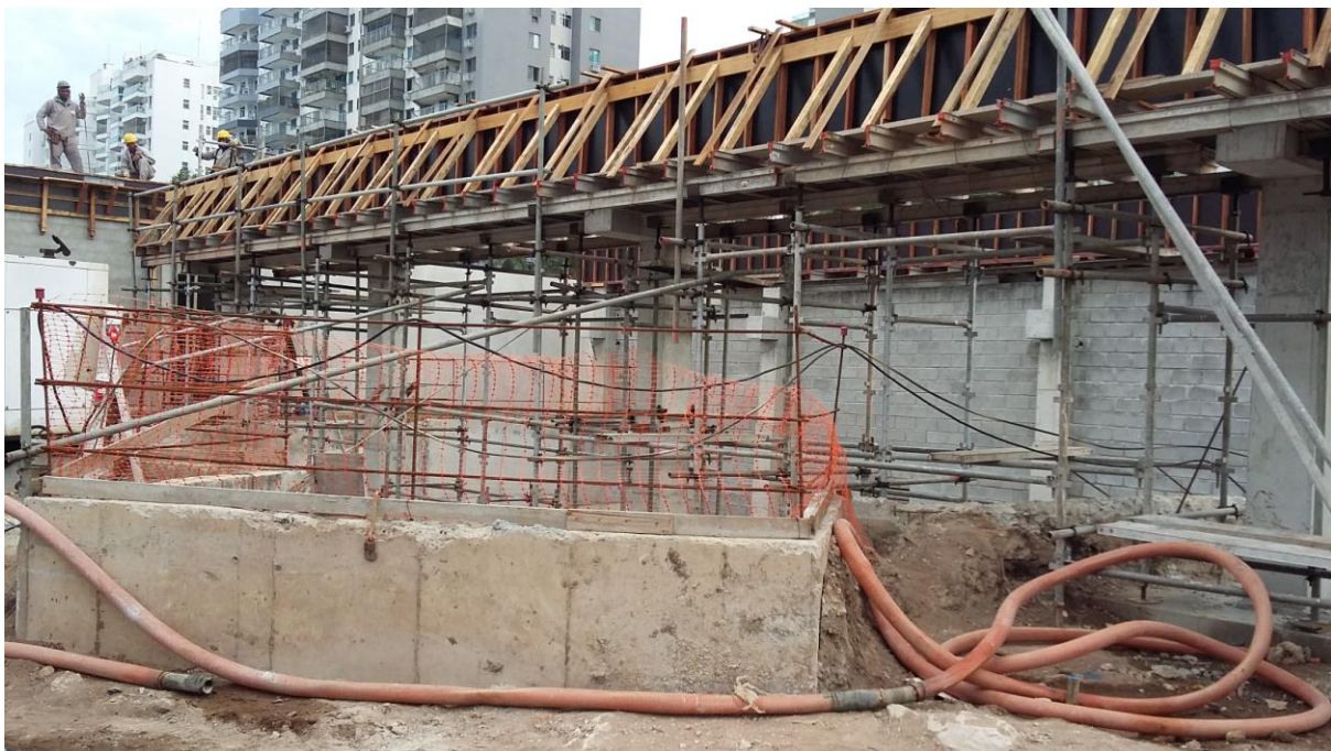
Concretagem de estrutura para içamento e remoção de equipamentos
