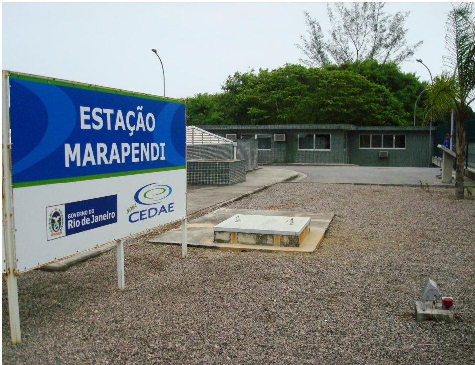
Esgotamento das Sub-bacias Marapendi Norte e Sul - concluída em Dezembro/2009
