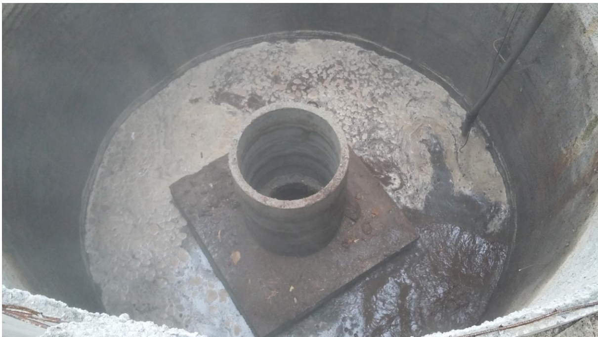
Avenida Célia Ribeiro da Silva Mendes - trecho em execução PV-77
