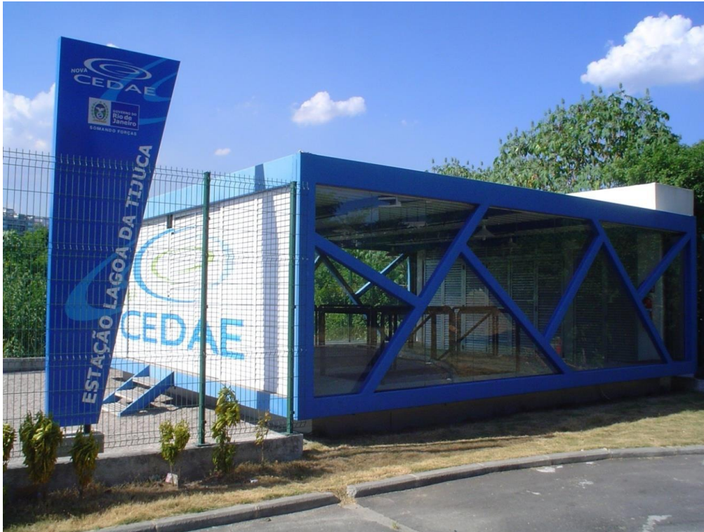
Elevatória Lagoa da Tijuca - concluída em Março/2010
