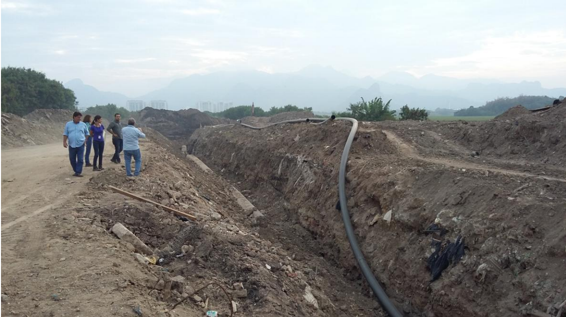
Tubulação provisória de PEAD de 250 mm do Empreendimento da Brookfield
