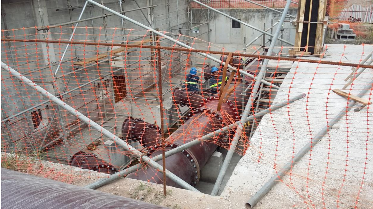
Montagem do barrilete
