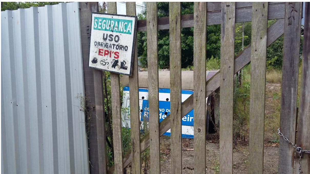
Canteiro de obras desativado
