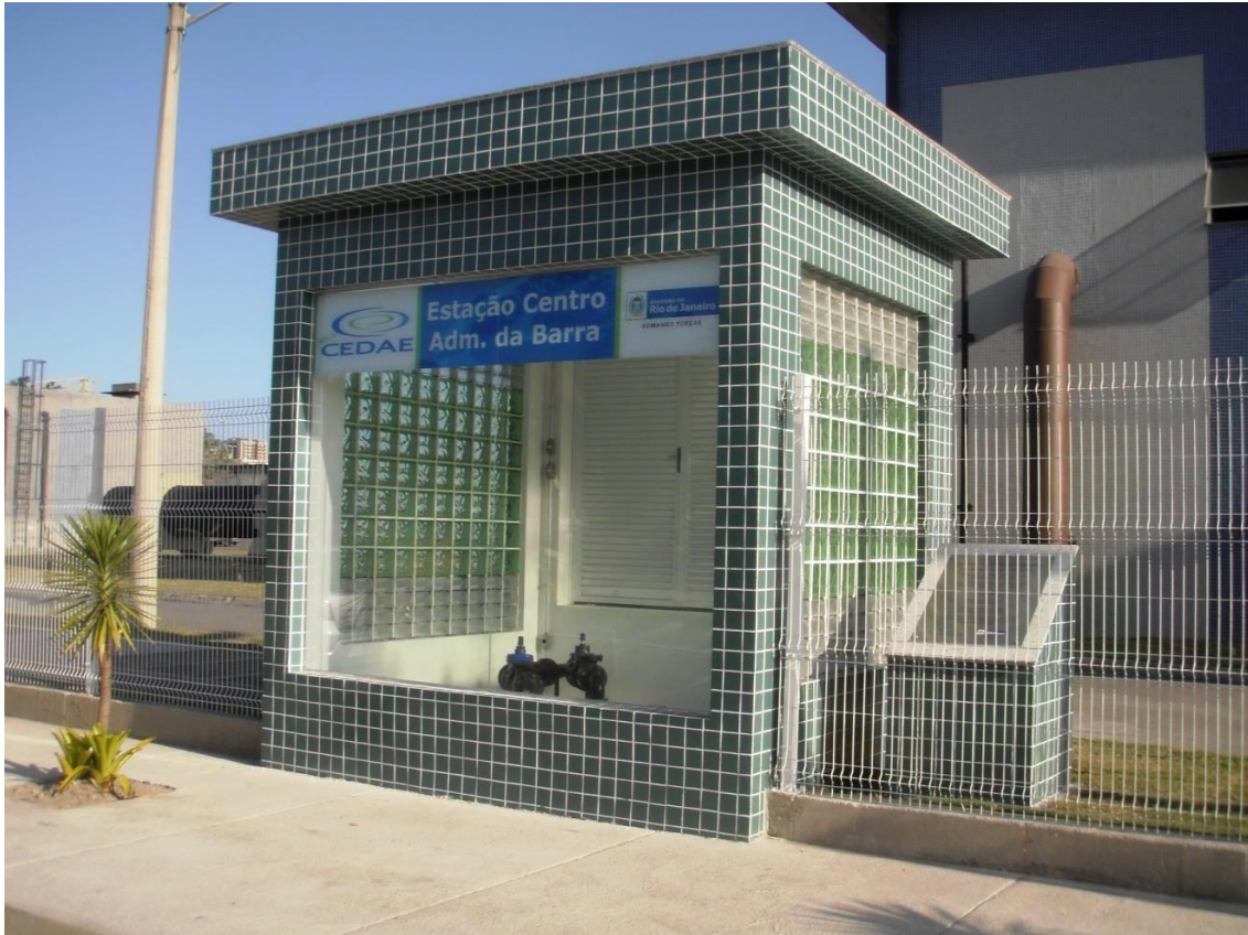
Estação Elevatória do Centro Administrativo da Barra - Concluído Setembro/2011
