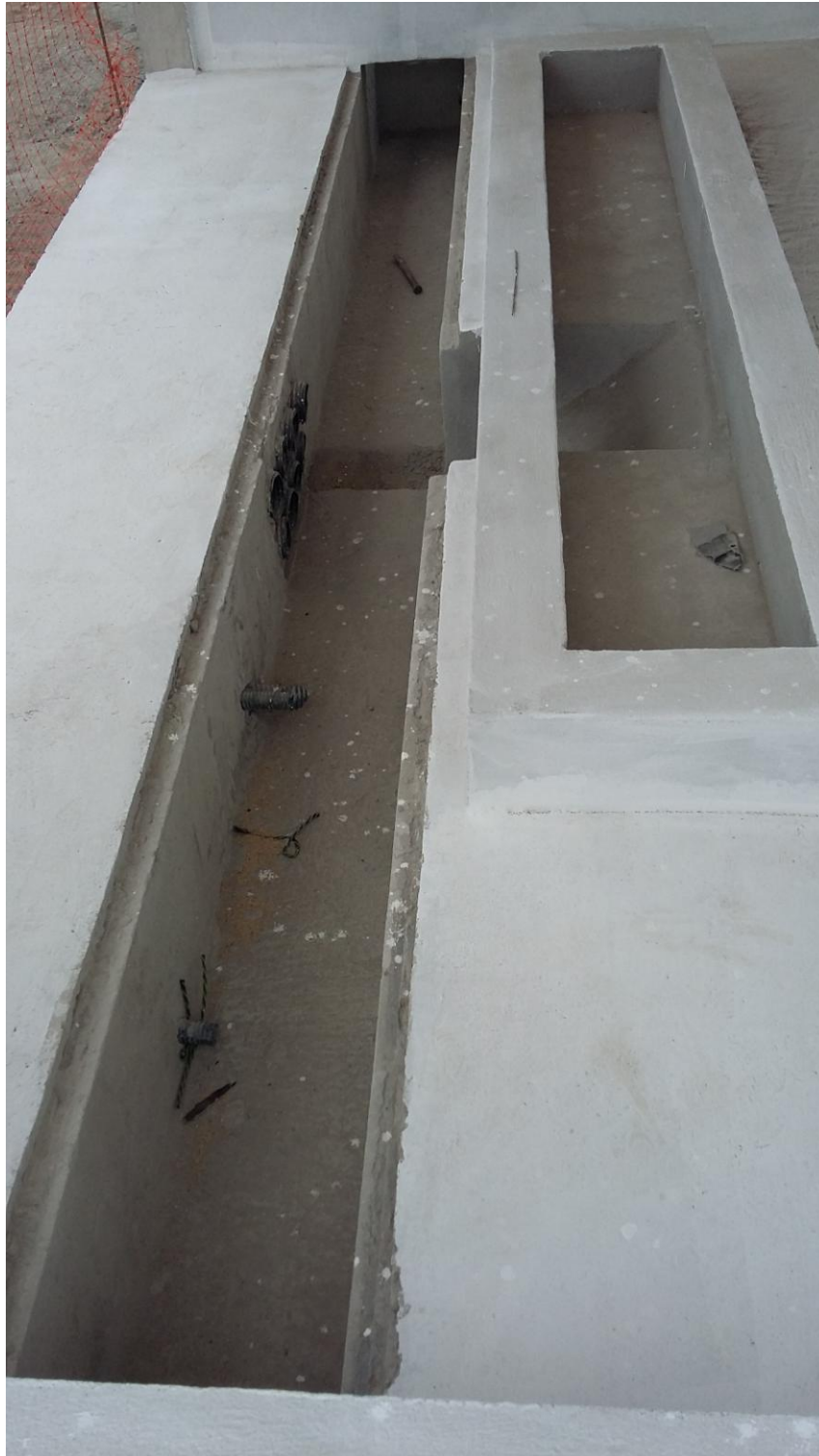
Canaletas para sistema de energização
