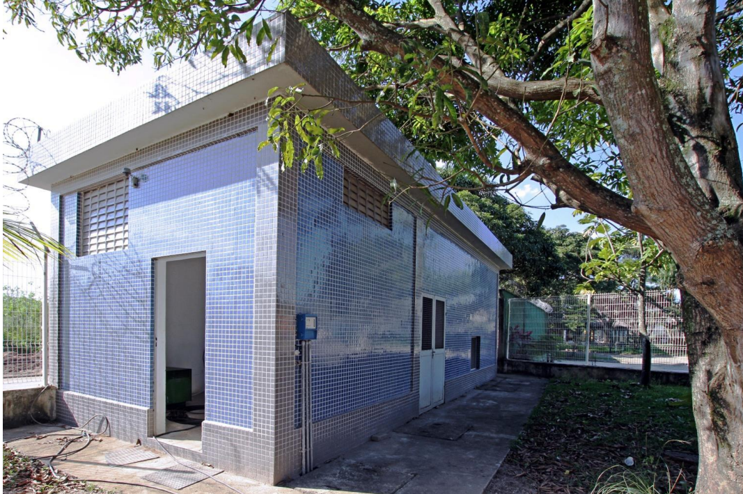
Estação Elevatória Santa Mônica - concluída outubro/2008
