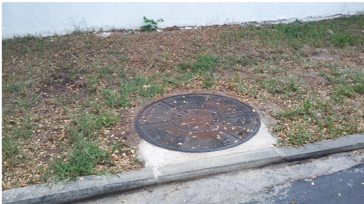
Avenida Célia Ribeiro da Silva Mendes - trecho com coletor tronco já assentado
