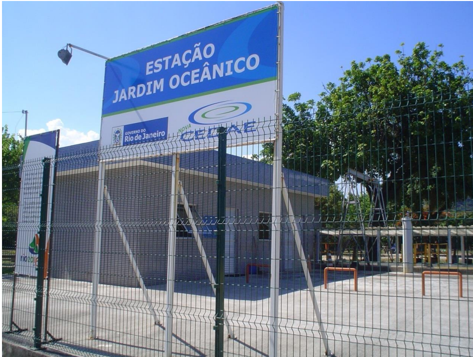
Esgotamento da Sub-bacia Jardim Oceânico - concluída em Agosto/2008
