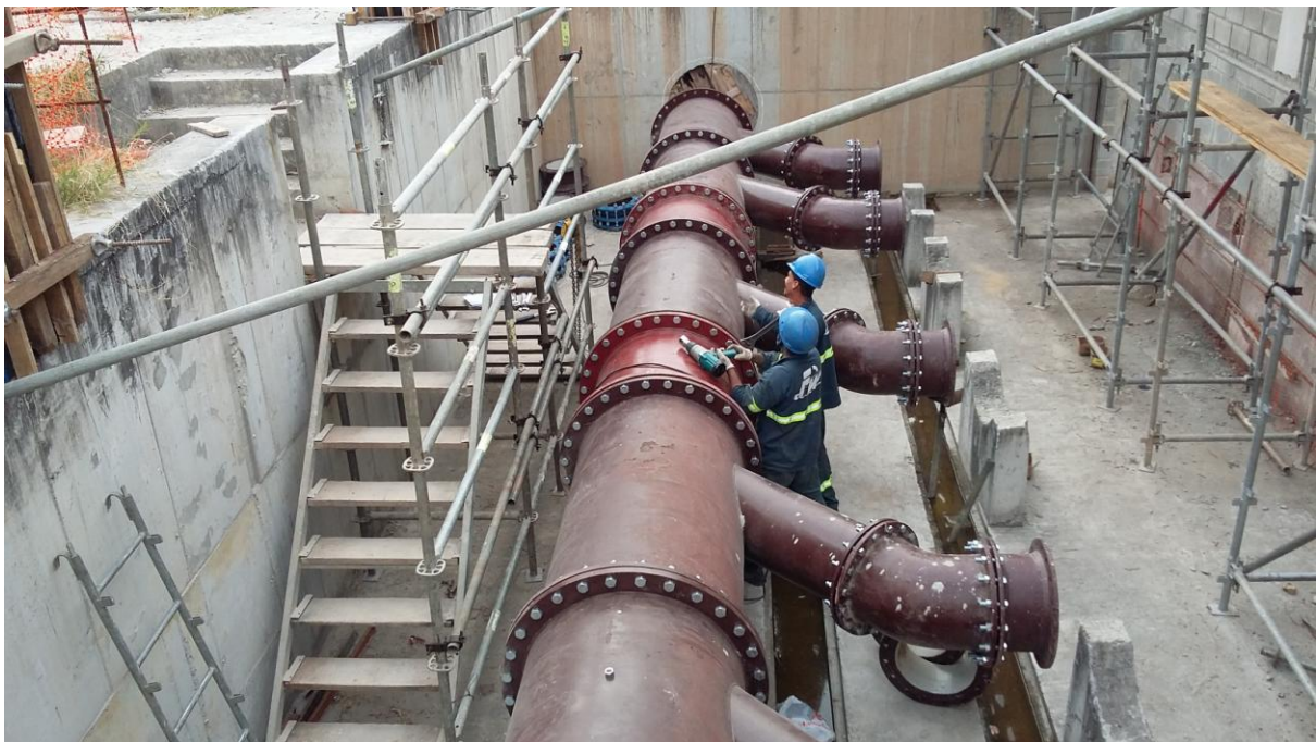
Montagem do barrilete
