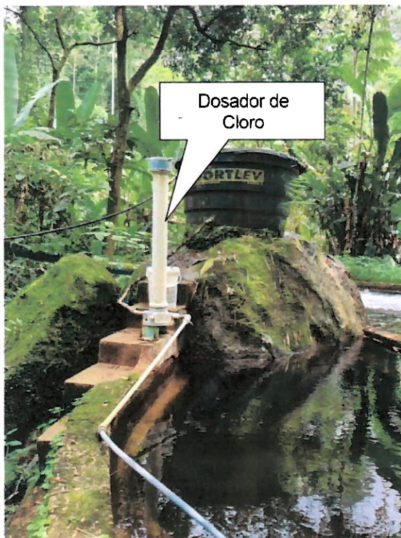
Dosador de Cloro para tablete Hypocal.
