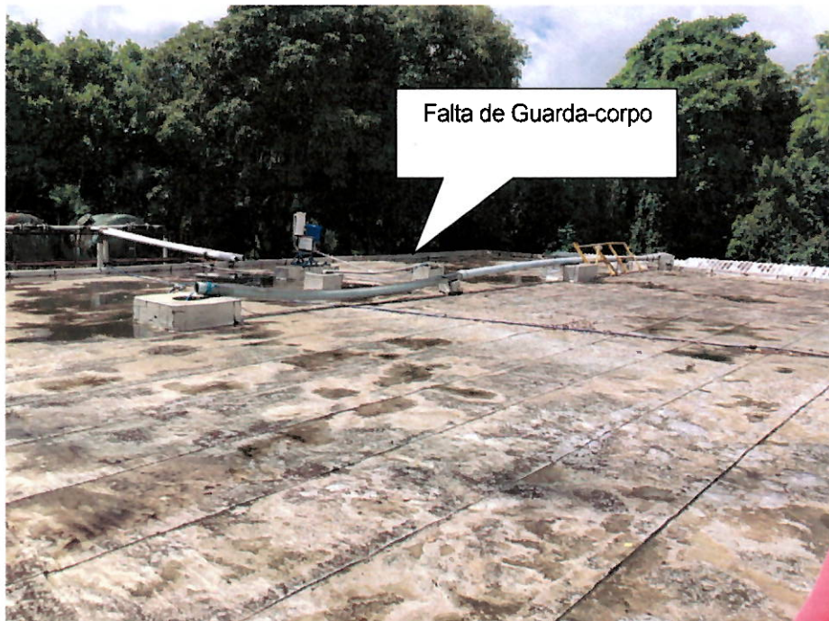
Cobertura do Reservatório
