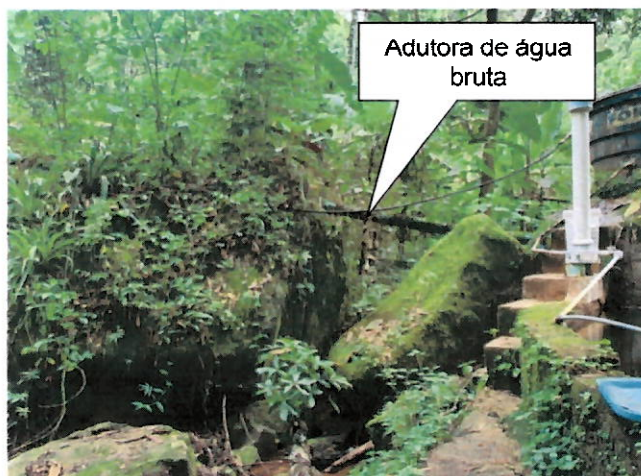
Chegada da água na UT através da adutora de Ferro Fundido DN 150 mm.
