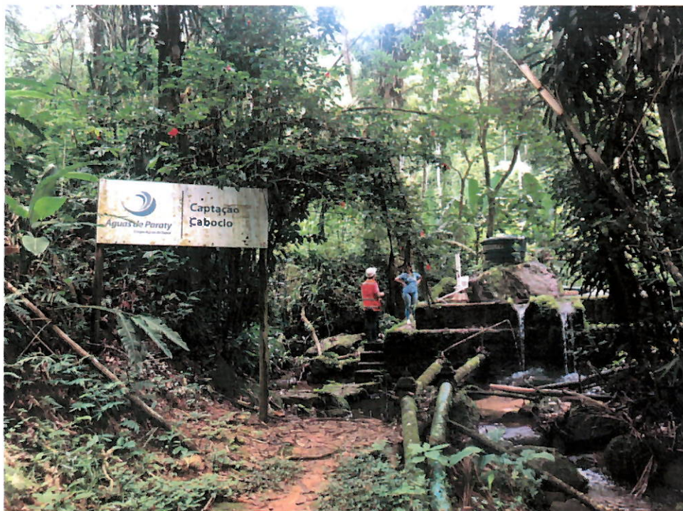
Unidade de Tratamento (U.T) de água do Caboclo - Paraty
