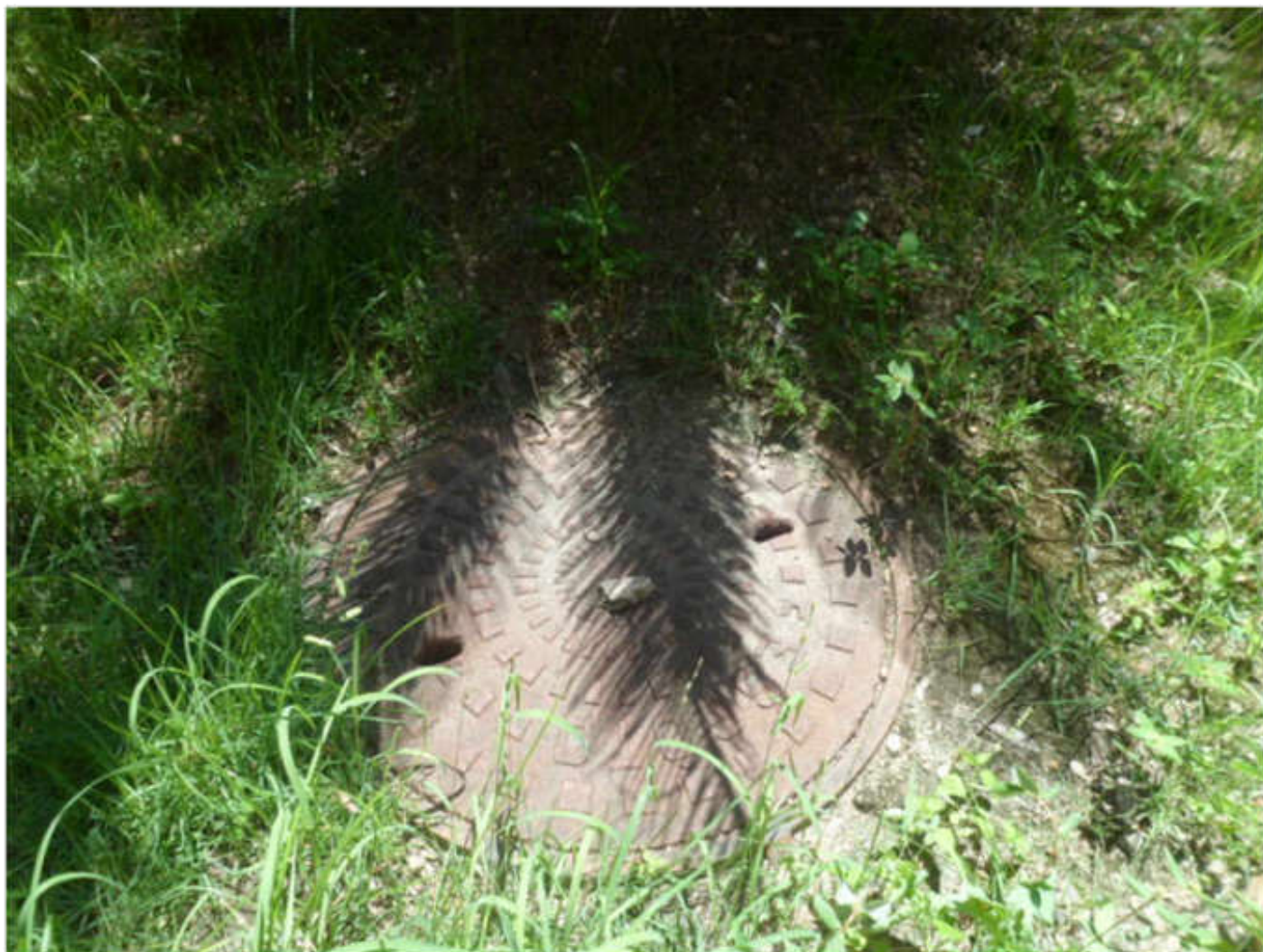
Foto 09 – PV na Parte Interna do Condomínio
