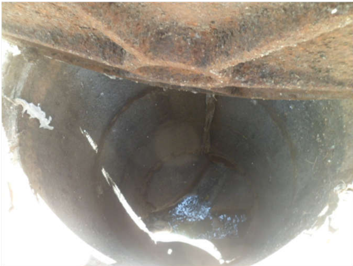
Foto 05 – Poço de Visita (PV) Dentro do Condomínio Cercado por Grades (fluxo normal)
