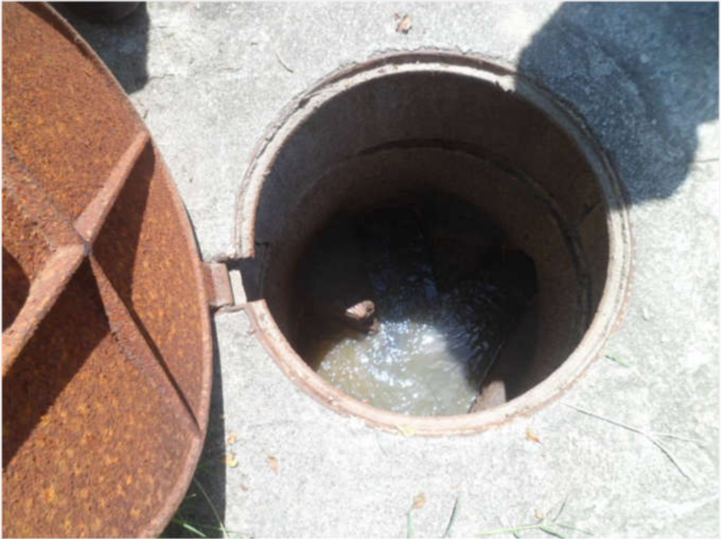
Foto 11 – Coletor da Rua Vlaminck, Receptor do Coletor de Esgoto da Rua Rodin (fluxo normal)
