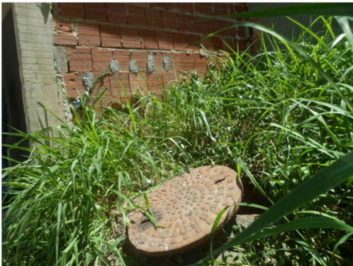
Foto 06 – Poço de Visita (PV)
