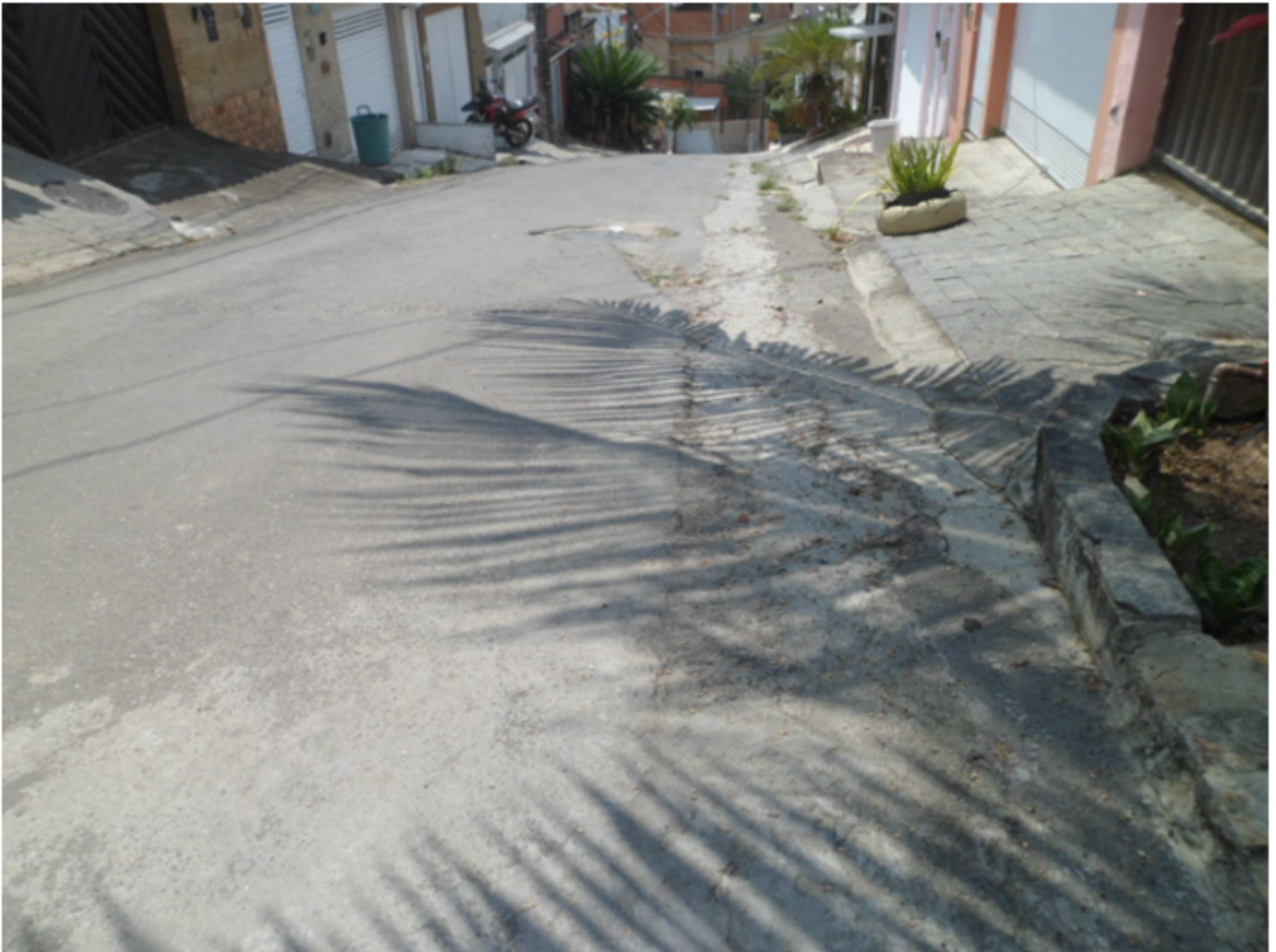
Foto 12 – Rua Arauanã, 185 – Vila Valqueire (Final da Obra da CEDAE)
