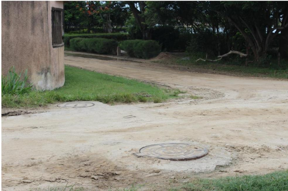
Foto 05 – Poço de visita de desvio para a Estação Elevatória
