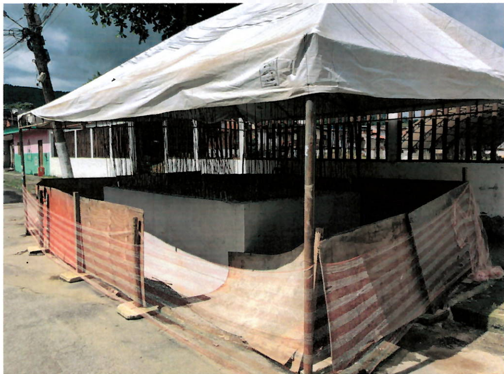
Caixa da Elevatória de Esgoto da Rua Cidade Cunha.
