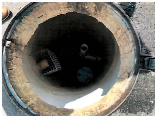
Poço de Visita executado pela Concessionária.
