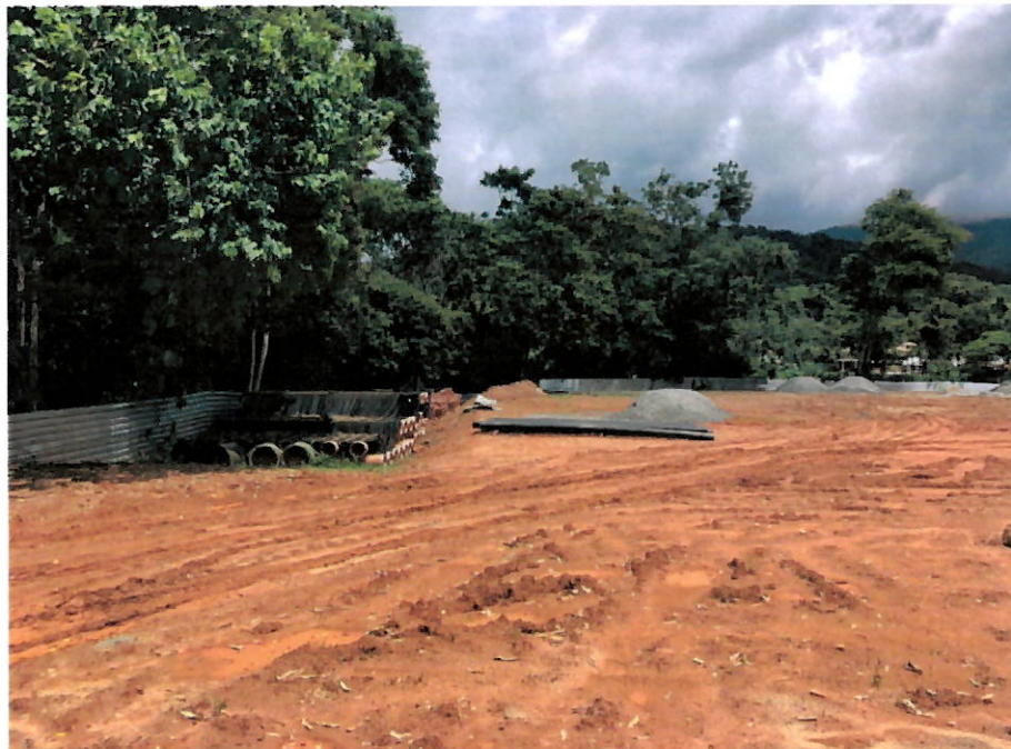
Aterro de 1,90 metros executado no terreno da ETE Paraty.
