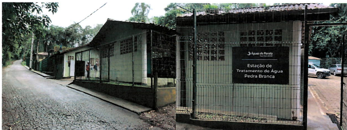
Estação de Tratamento de Água de Pedra Branca - Paraty
