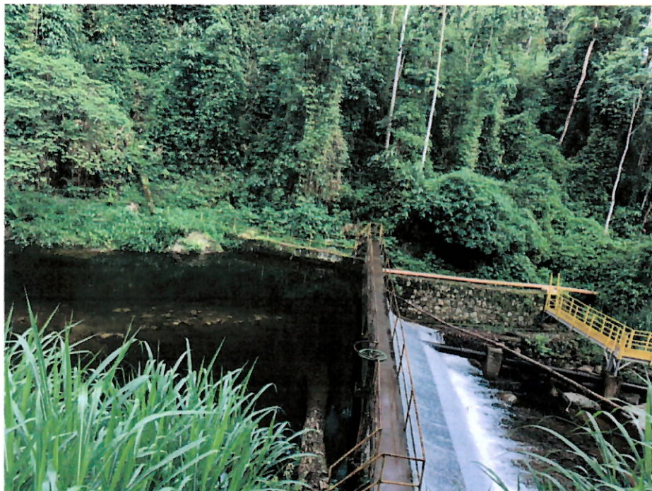
Captação – Vista Geral
