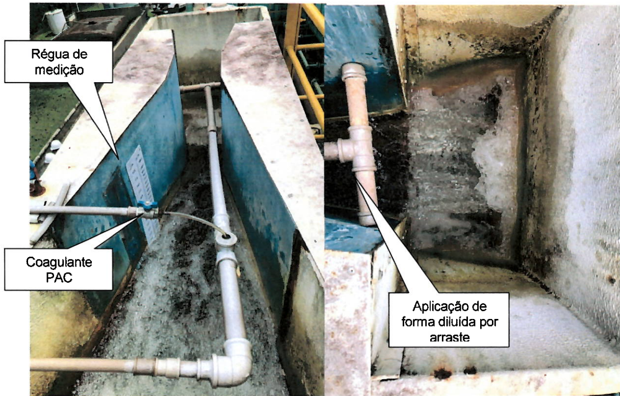
Calha Parshall e ponto de aplicação do PAC
