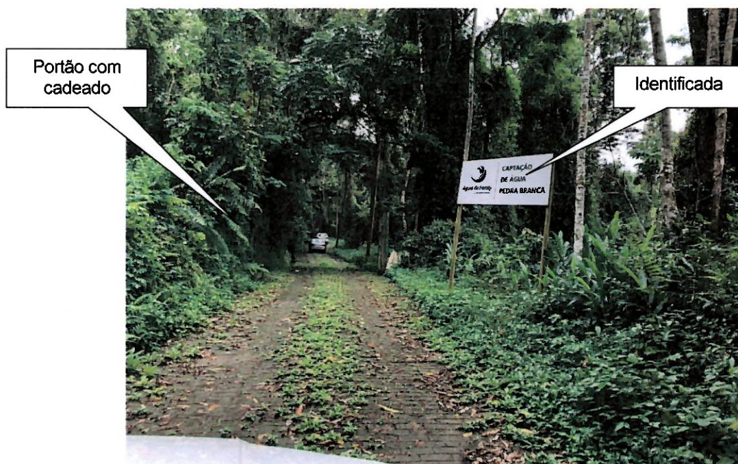
Entrada Captação Pedra Branca
