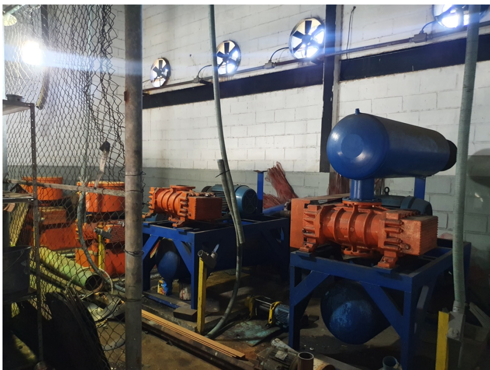
Foto 16 - Casa de Máquina
