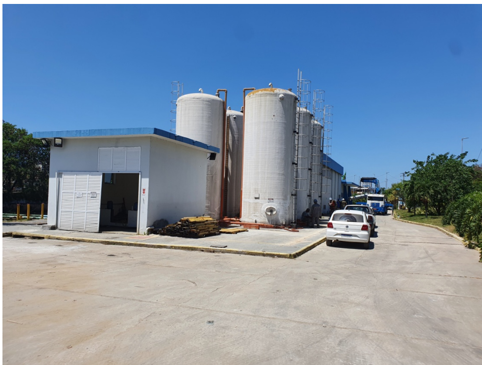
Foto 12 - Casa de Produtos Químicos
