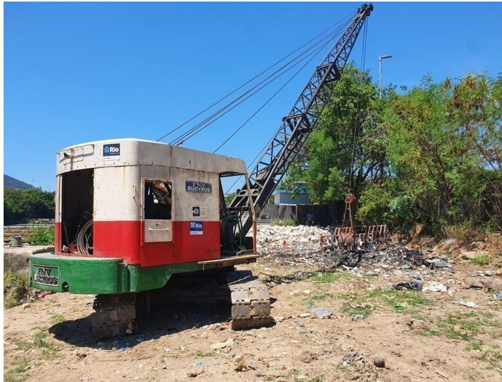
Foto 3 – Dragagem para limpeza da Ecobarreira
