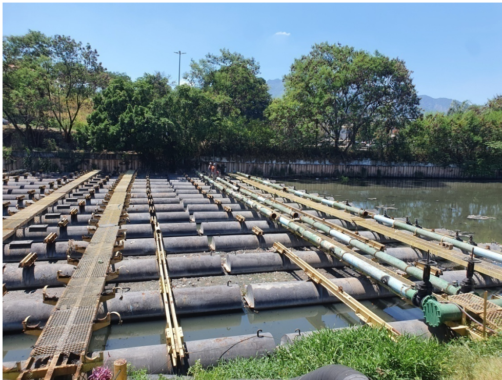
Foto 5 – Módulos flutuantes já separados
