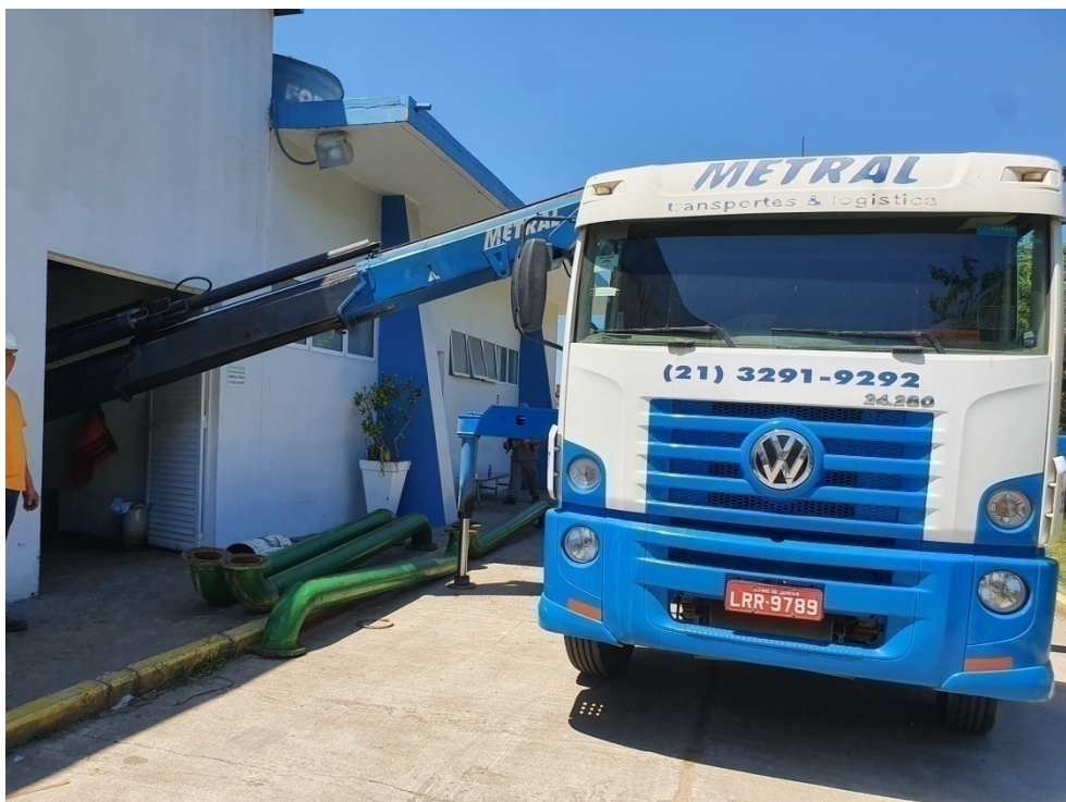
Foto 14 - Caminhão Munck retirando equipamentos
