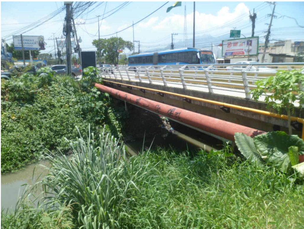
Foto 06 – Rua Castor, s/n, esquina com a Estrada dos Bandeirantes (sem presença de vazamento)
