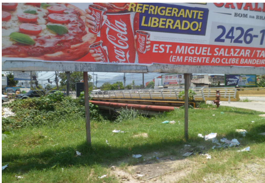
Foto 01 – Vista do PV Possivelmente de Esgoto Anterior a Válvula do Coletor Tronco de Esgoto
