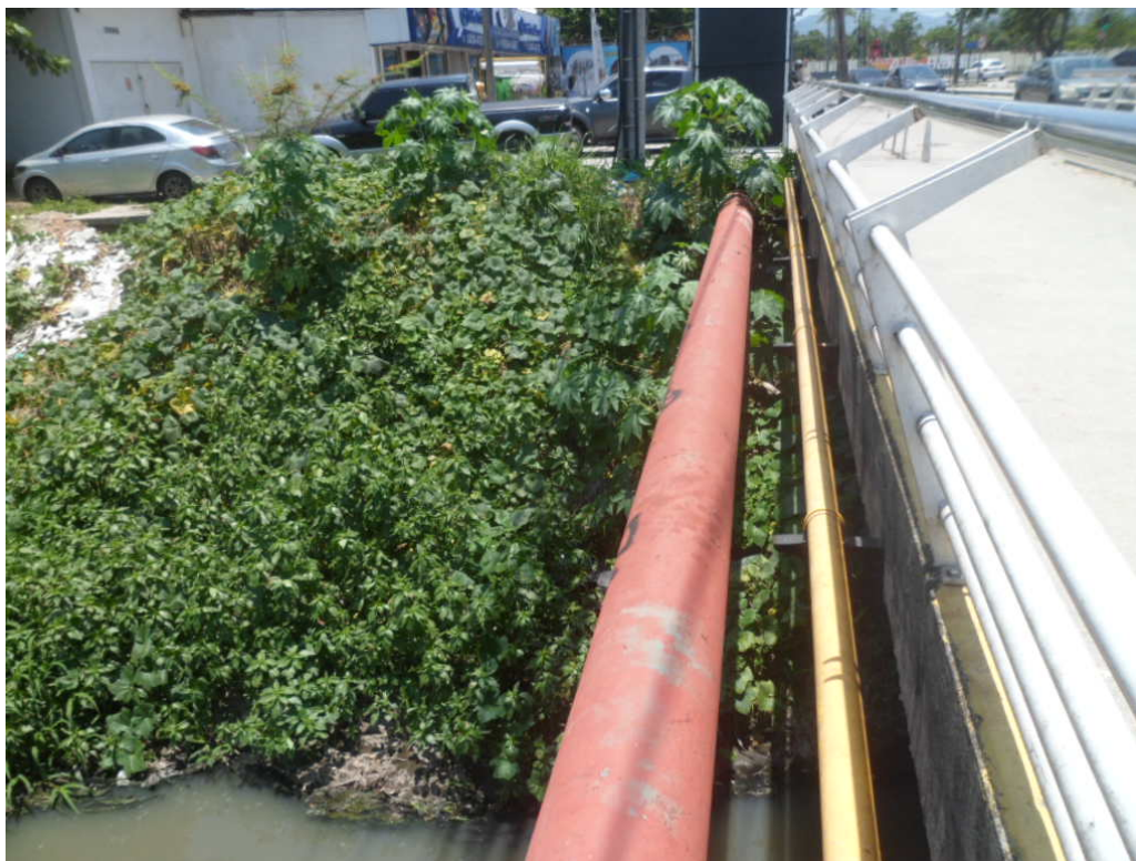
Foto 07 – Rua Castor, s/n, esquina com a Estrada dos Bandeirantes (sem presença de vazamento)
