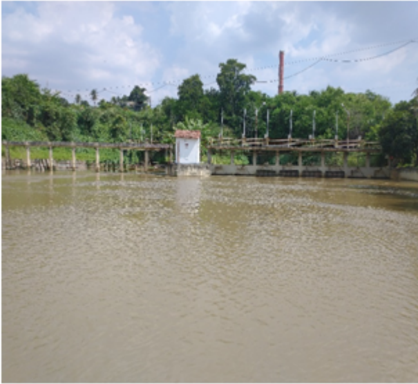
Foto 05 - Tomada de captação de água bruta da ETA Guandu
