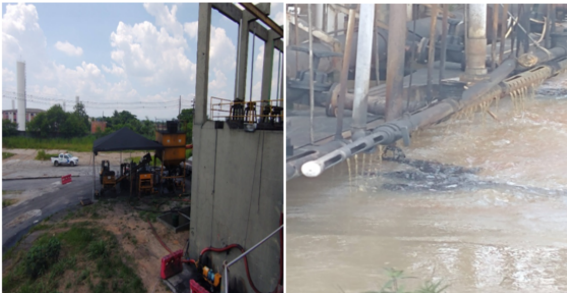
Foto 03 - Instalação e aplicação do carvão ativado
