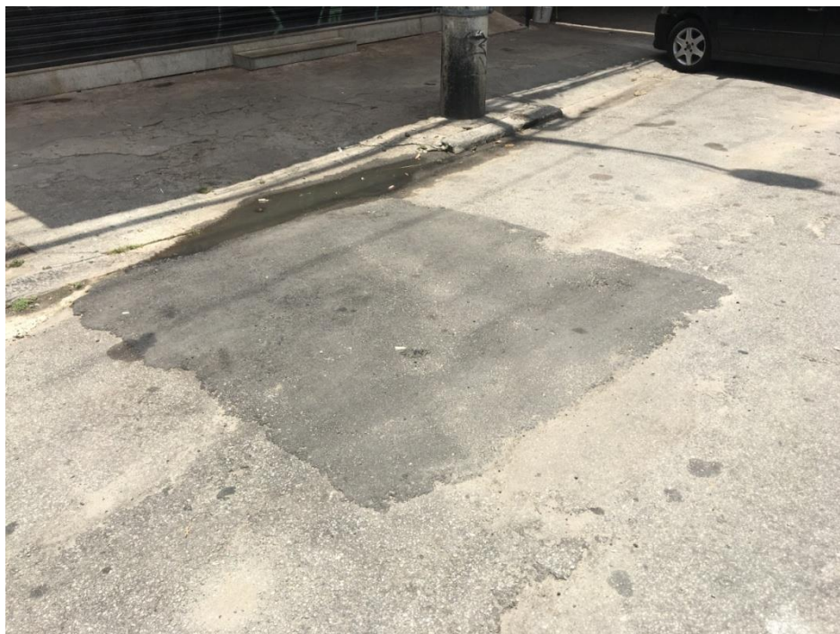
REPARO EXECUTADO - DETALHE
