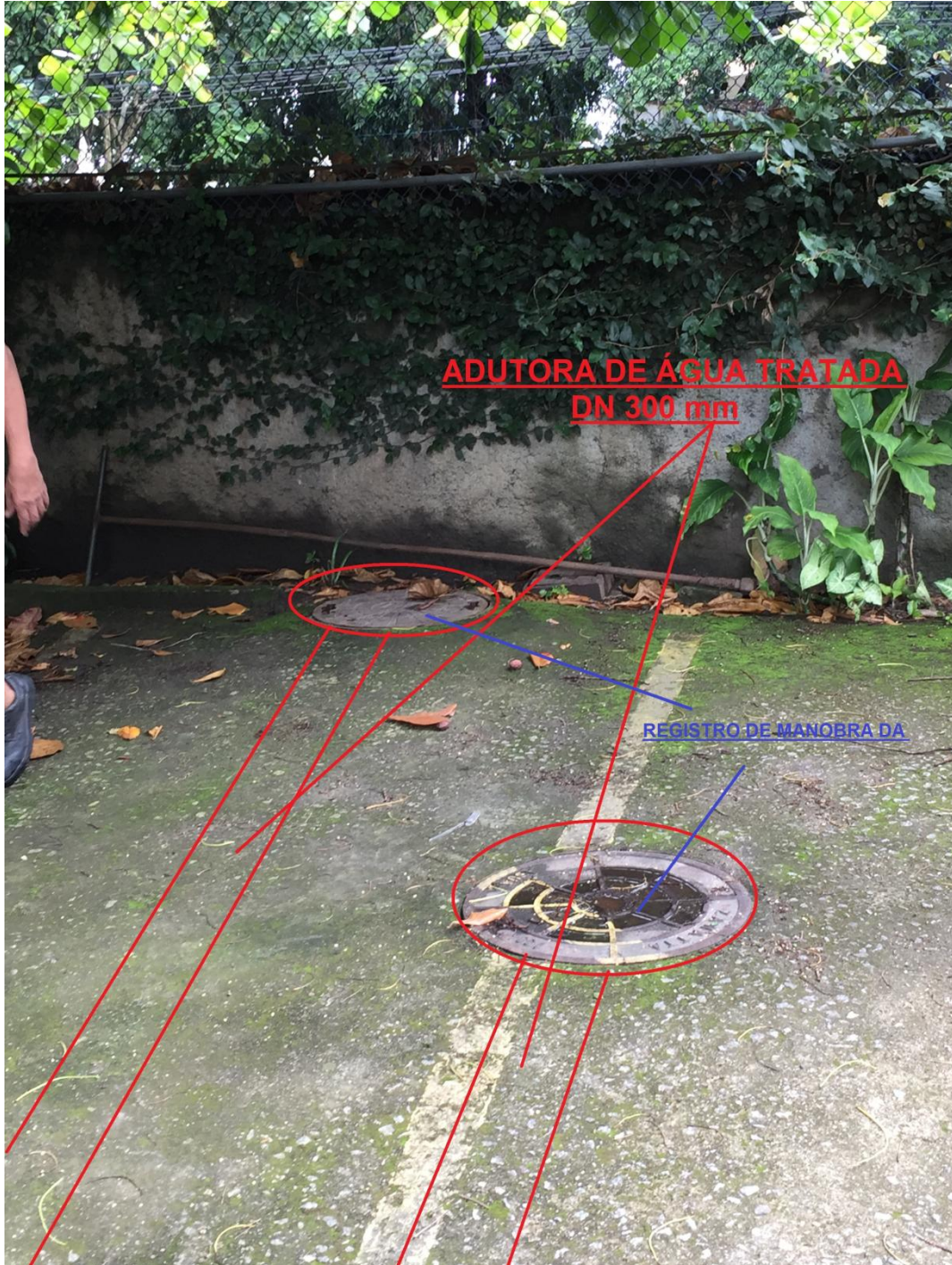
Percurso das adutoras DN 300 mm e o registro de manobra da rede de distribuição Pátio do estacionamento do Colégio
