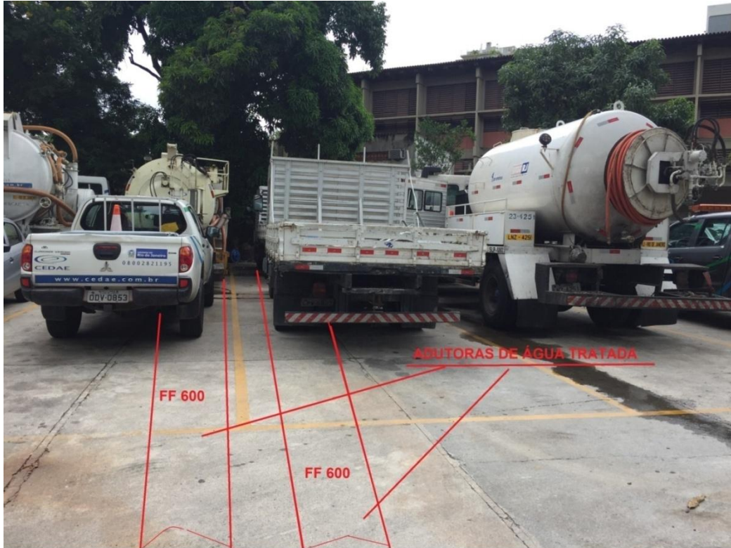
Percurso das adutoras DN 600 mm - Pátio de Estacionamento da CEDAE
