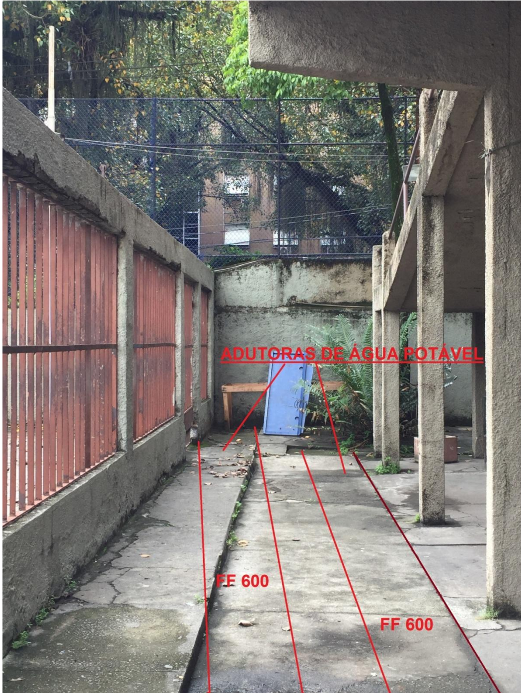
Percurso das adutoras DN 600 mm - próximas das sapatas do prédio do Colégio
