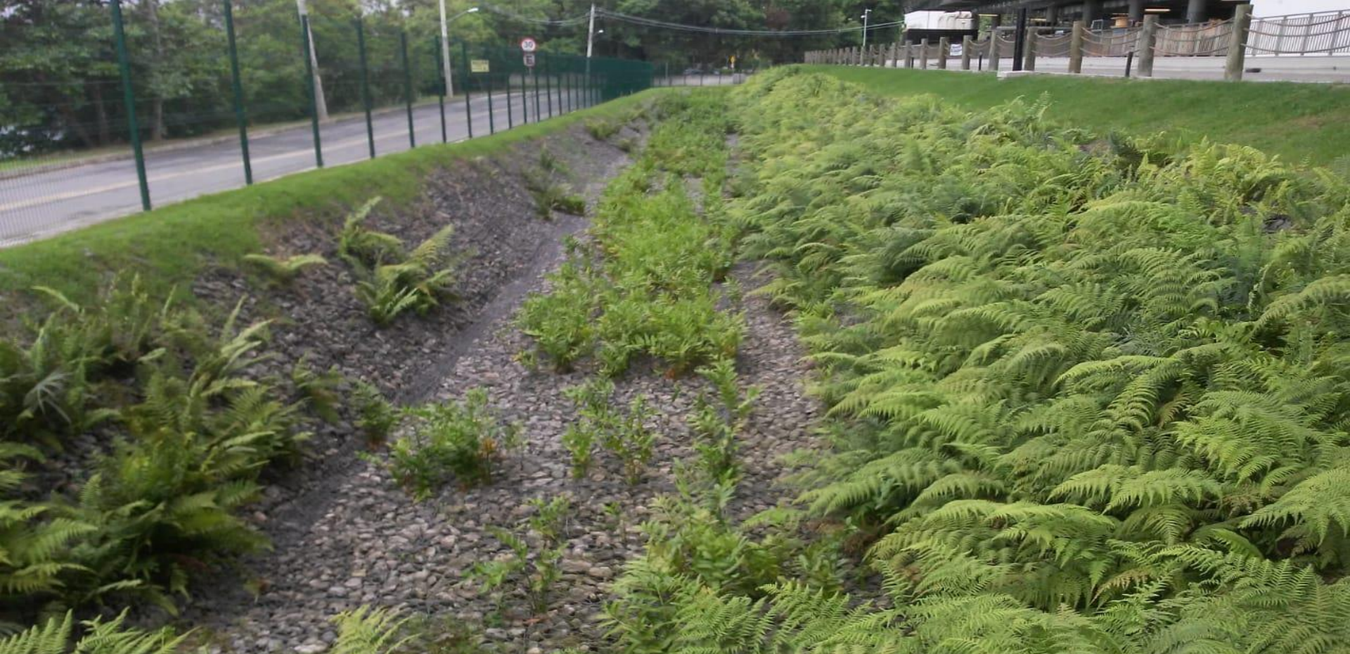
Lagoa de Retenção (Samambaias)
