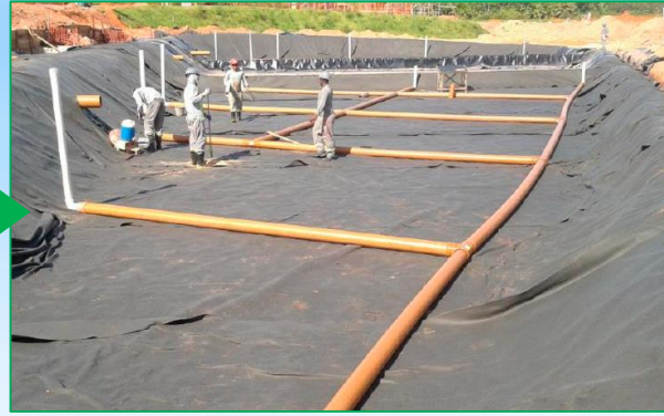
Impermeabilização e malha hidráulica
