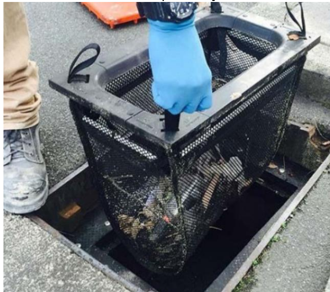
Figura 5: Demonstra a utilização de filtros em bueiros.
