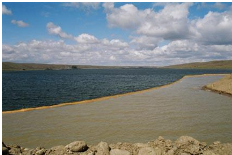
Figura 2: Demonstra a utilização de cortinas de sedimento durante a dragagem.
