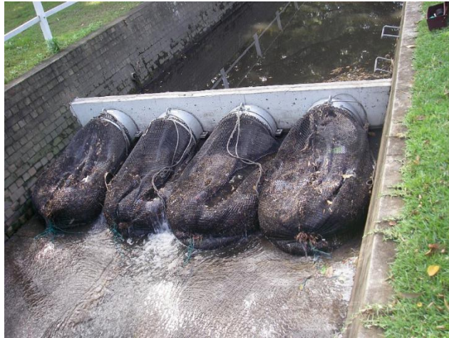
Figura 4: Demonstra a utilização de barreiras de resíduos sólidos.
