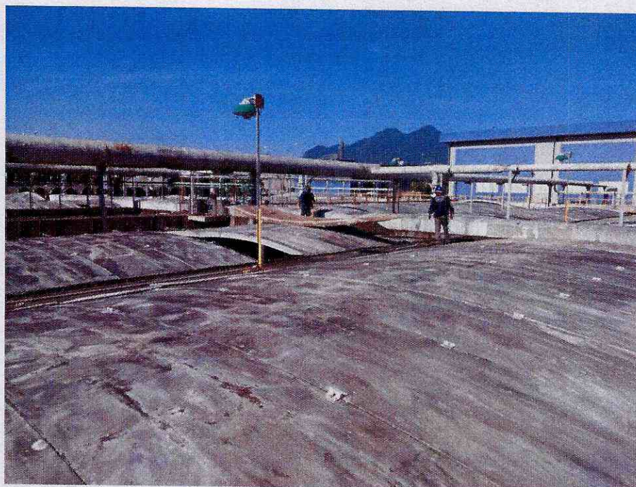
Figura 1 – Retirada das coberturas de fibra de vidro.
