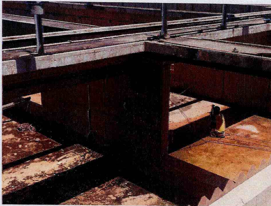
Figura 7 – Início da Limpeza das Células do Decantador
