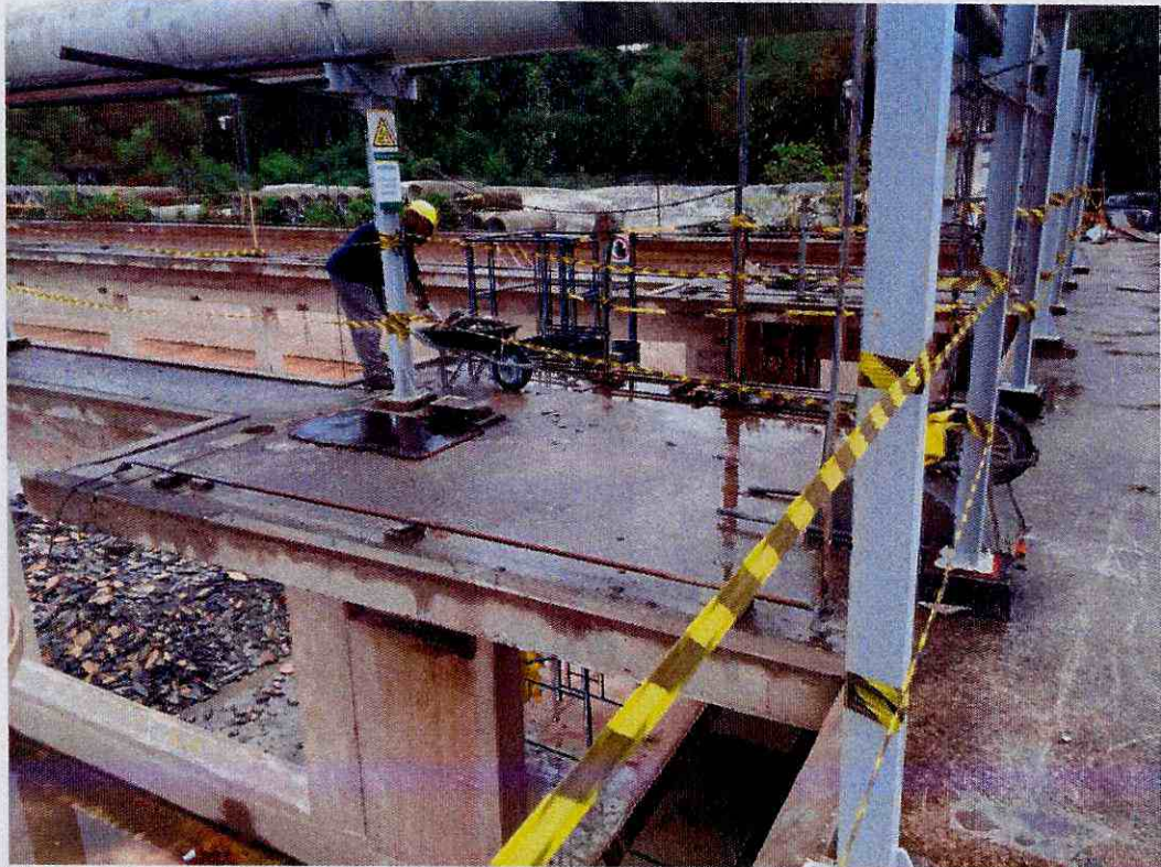
Figura 15 – Retirada da demolição do piso das células do Decantador nº 3
