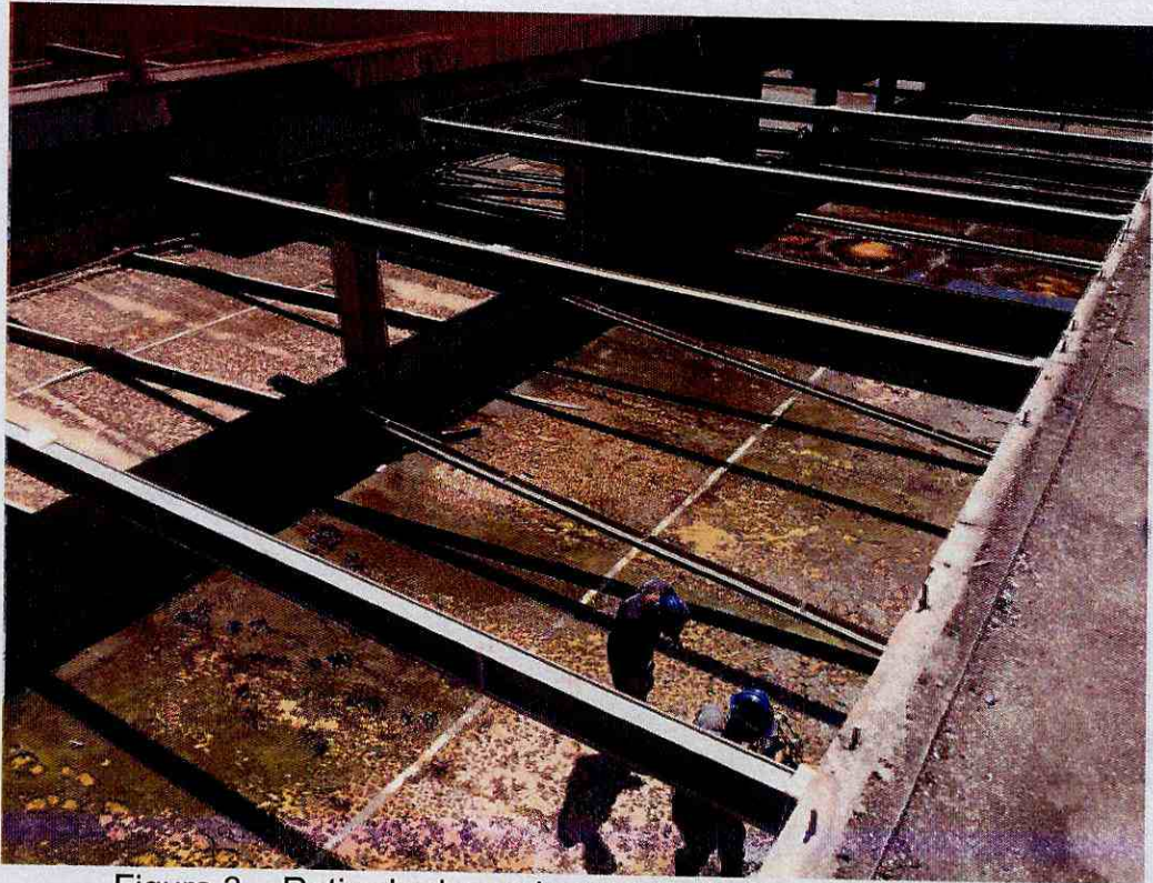
Figura 3 – Retirada do equipamento do Raspador de Lodo
