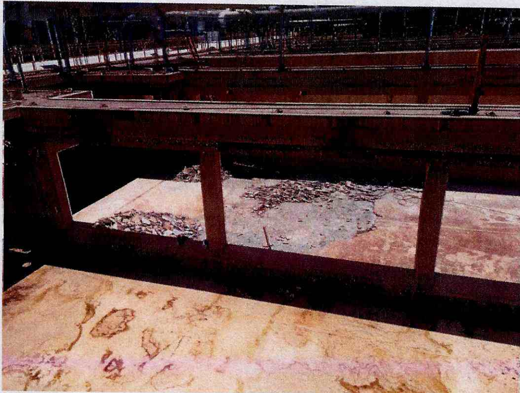
Figura 13 – Início da demolição do piso das células do Decantador nº 3
