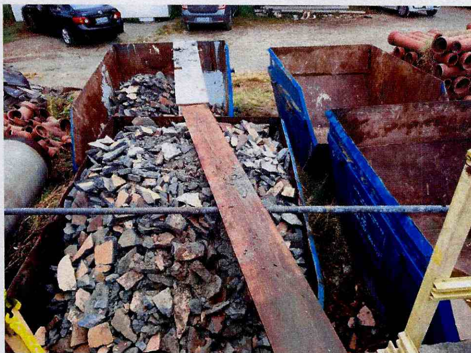
Figura 16 – Caçambas com o material demolido do Decantador
