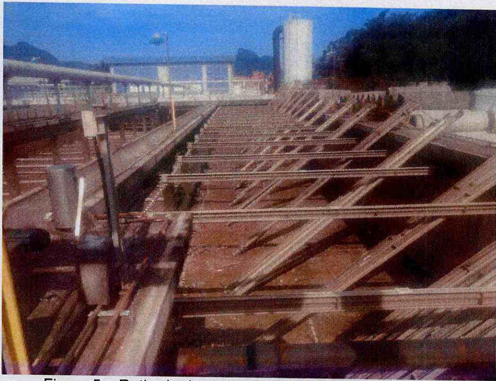
Figura 5 – Retirada do equipamento do Raspador de Lodo
