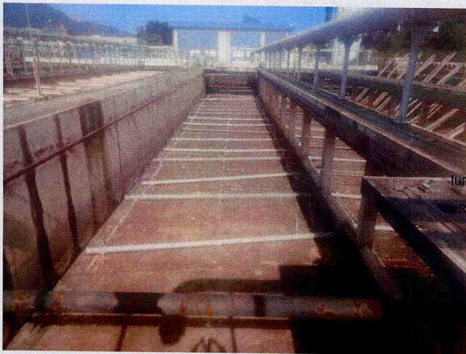
Figura 6 – Retirada do equipamento do Raspador de Lodo
