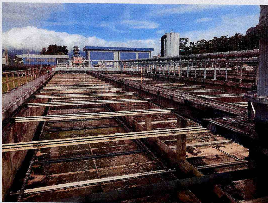
Figura 2 – Após a retirada de todas as coberturas.
