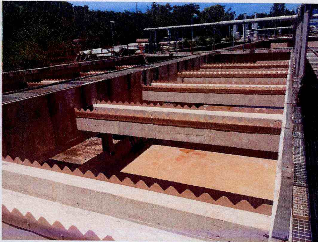
Figura 9 – Limpeza dos Canais do Decantador
