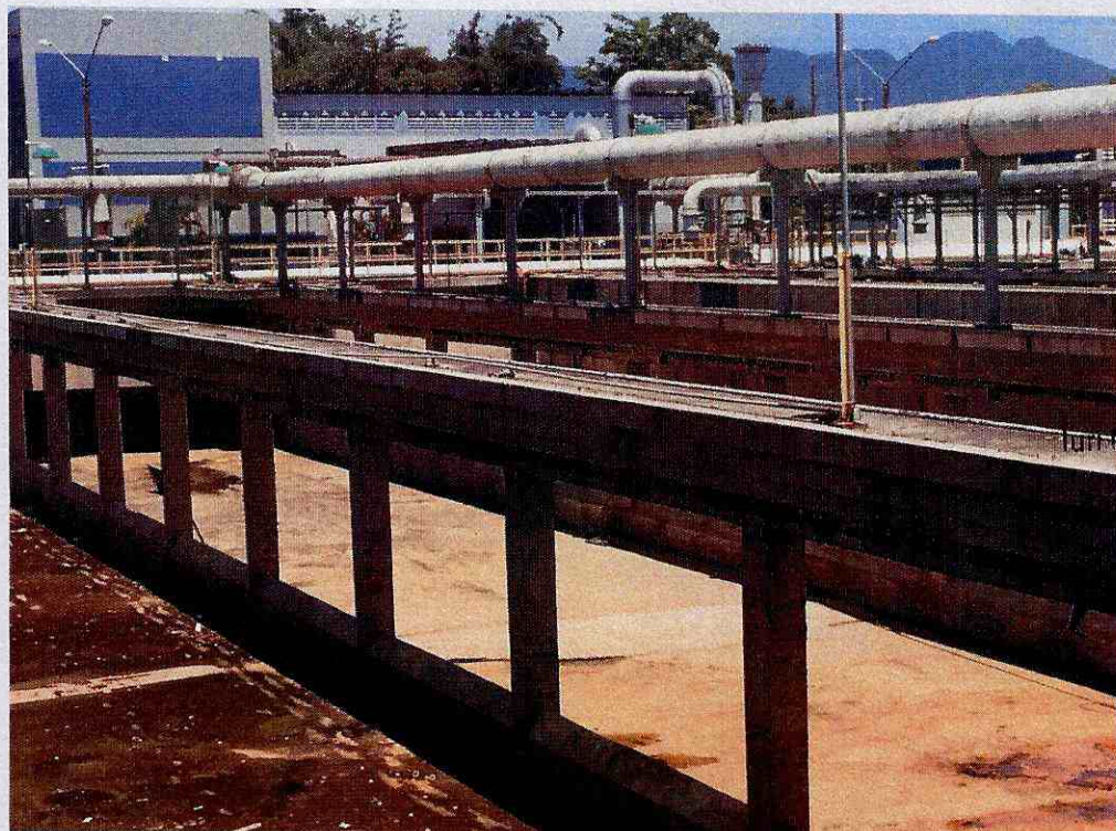
Figura 8 – Limpeza das Células do Decantador
