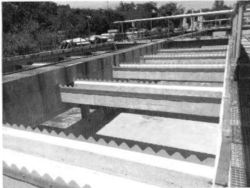
Figura 9 – Limpeza dos Canais do Decantador
