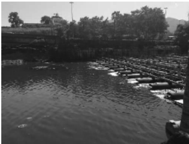
Figura A.3 – Trecho do rio imediatamente a jusante da barreira flutuante, onde se pode ter uma visão frontal da plataforma flutuante que abriga os sistemas de aeração e de injeção de produtos químicos que compõem o processo da ETR.
