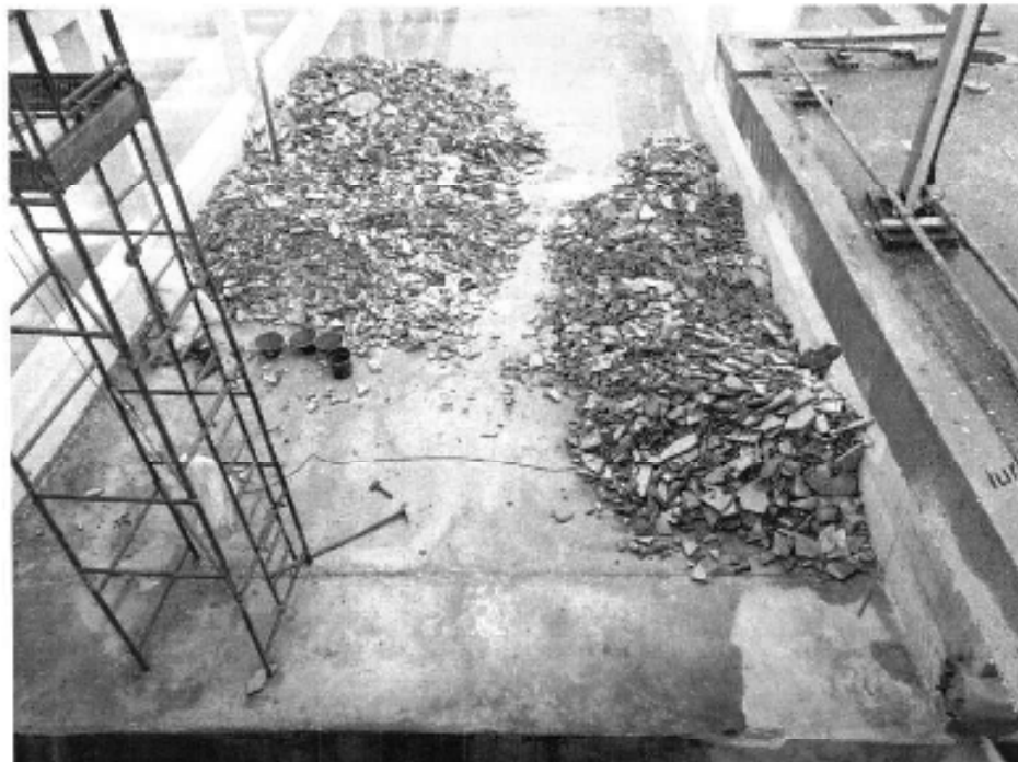
Figura 14 – Demolição do piso das células do Decantador nº 3
