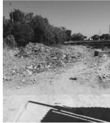
Figura A.2 – Área localizada na margem direita do rio e destinada ao armazenamento de resíduos sólidos retidos pela barreira flutuante e removidos do lodo pela peneira estática, em etapa posterior do processo da ETR.
