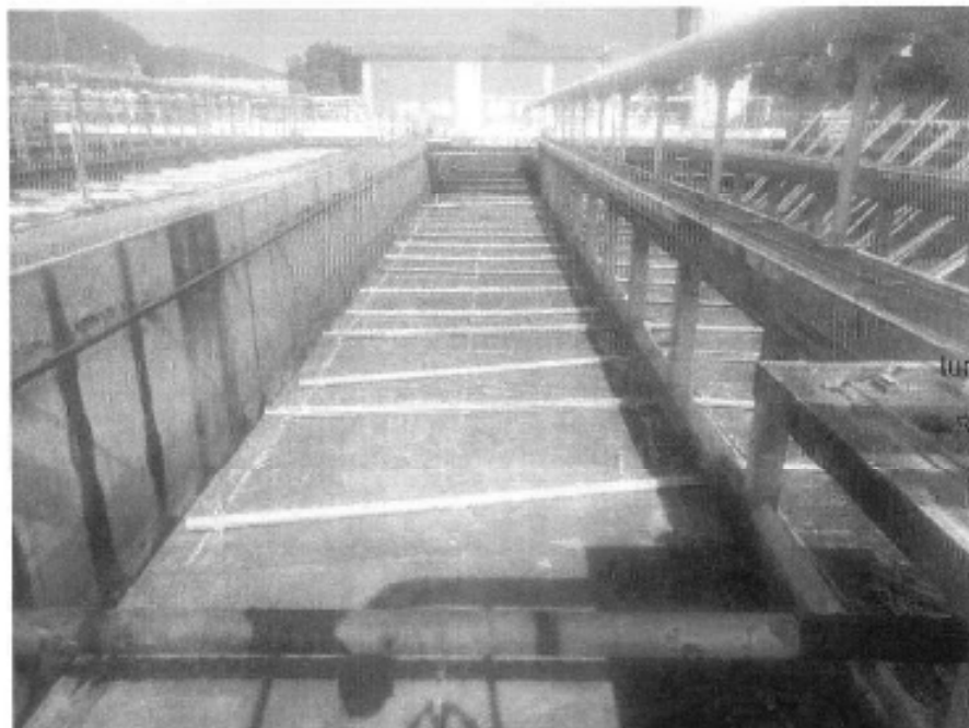
Figura 6 – Retirada do equipamento do Raspador de Lodo
