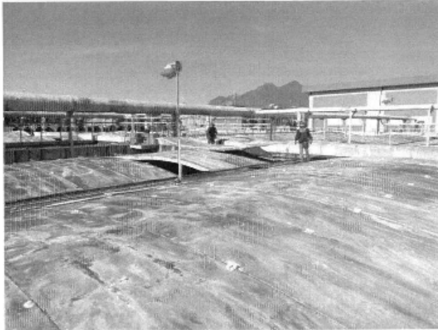
Figura 1 – Retirada das coberturas de fibra de vidro.
