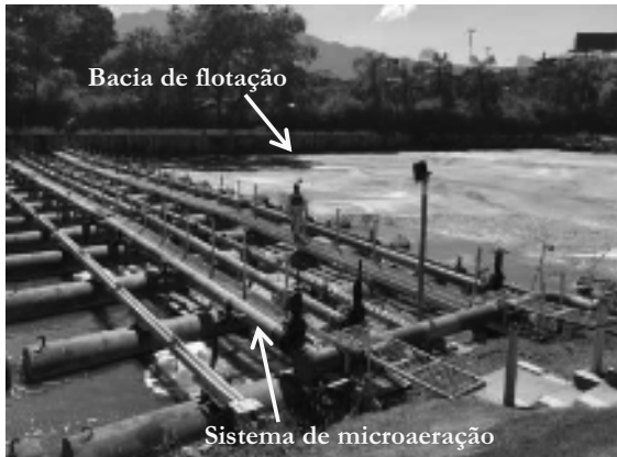
Figura A.9 – Etapa de flotação auxiliada por sistema de microaeração instalado na plataforma flutuante a jusante da bacia de coagulação.
