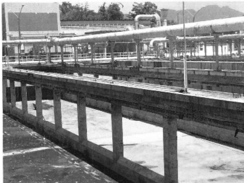
Figura 8 – Limpeza das Células do Decantador
