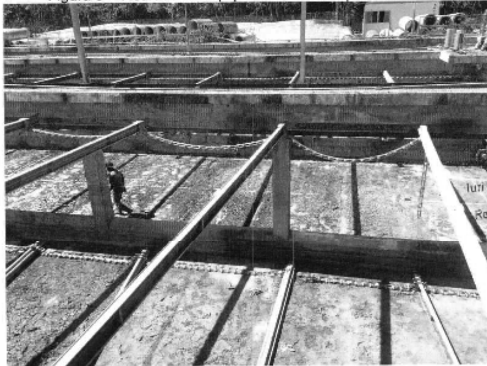
Figura 4 – Retirada do equipamento do Raspador de Lodo
