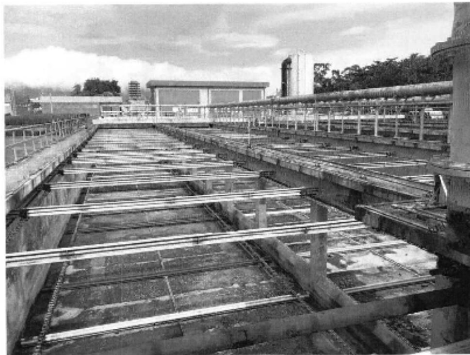
Figura 2 – Após a retirada de todas as coberturas.
