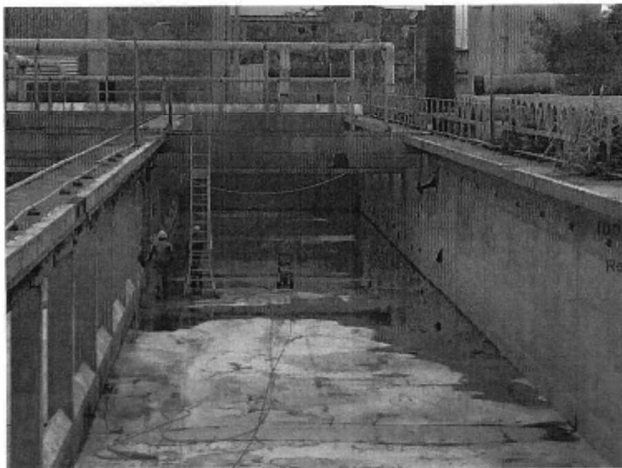
Figura 10 – Limpeza das células do Decantador
