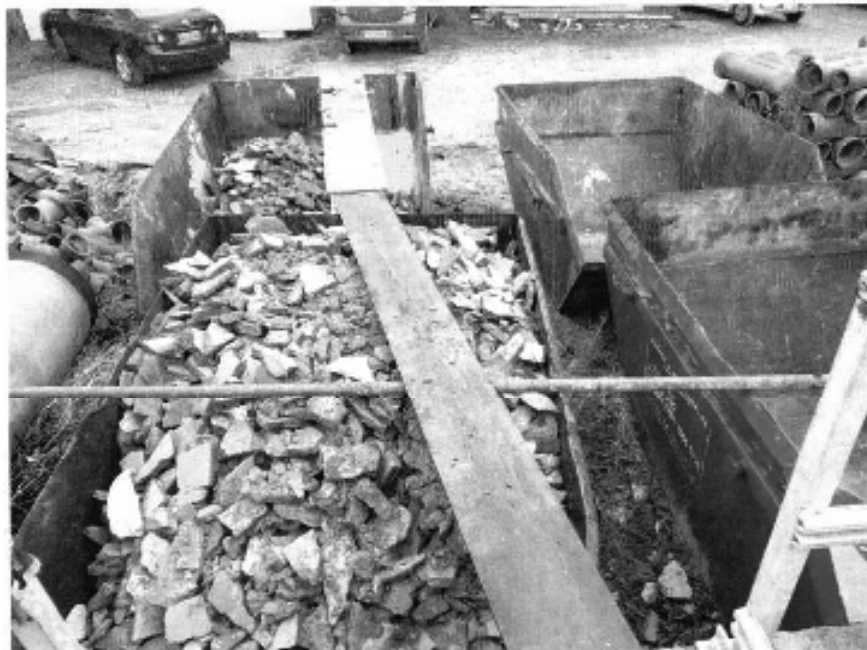
Figura 16 – Caçambas com o material demolido do Decantador
