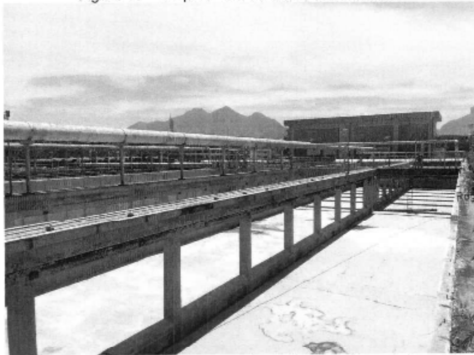
Figura 12 – Fim da limpeza das Células do Decantador
