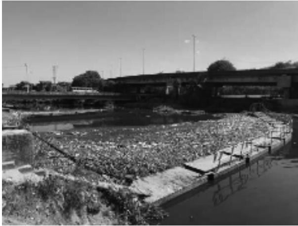
Figura A.1 – Barreira flutuante responsável pela retenção de resíduos sólidos flutuantes de maiores dimensões.
