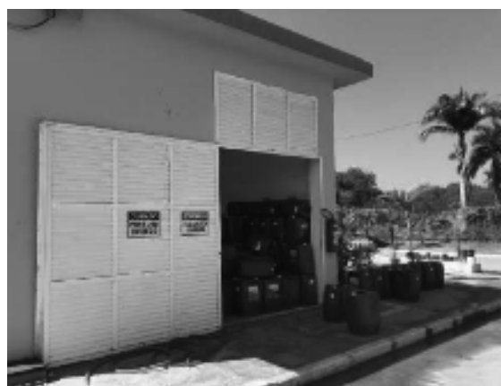
Figura A.20 – Local de estocagem dos produtos químicos utilizados na ETR.
