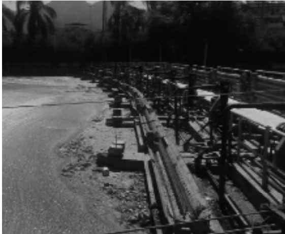
Figura A.13 – Rodas de dragagem responsáveis pela remoção do lodo flotado do leito do rio.
