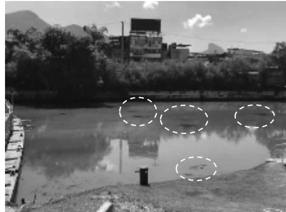
Figura A.14 – Trecho do rio imediatamente a jusante da última etapa do processo de tratamento realizado pela ETR. Destaca-se a presença de lodo fluante (chamado pelos operadores de “jacaré”) no leito do rio já neste trecho, logo a jusante da estação.
