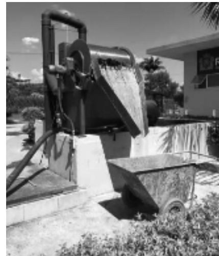
Figura A.16 – Peneira estática que remove os sólidos do lodo proveniente das rodas de dragagem. Estes sólidos são armazenados na área mostrada na Figura A.1, juntamente com os resíduos retidos pela barreira fluante.
