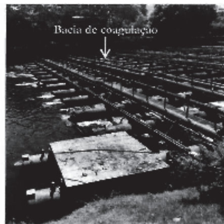
Figura A.4 - Etapa de coagulação realizada através da adição de sulfato de alumínio (coagulante) associada à aeração para mistura lenta, aplicados através de sistemas instalados na plataforma flutuante.
