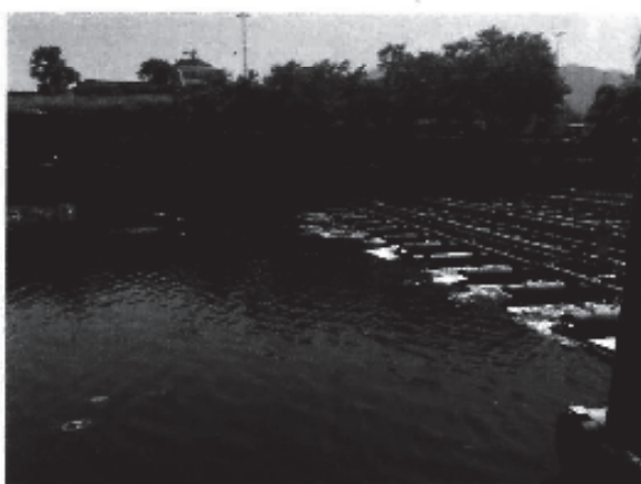
Figura A.3 - Trecho do rio imediatamente a jusante da barreira flutuante, onde se pode ter uma visão frontal da plataforma flutuante que abriga os sistemas de aeração e de injeção de produtos químicos que compõem o processo da ETR.
