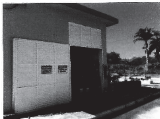
Figura A.20 – Local de estocagem dos produtos químicos utilizados na ETR.
