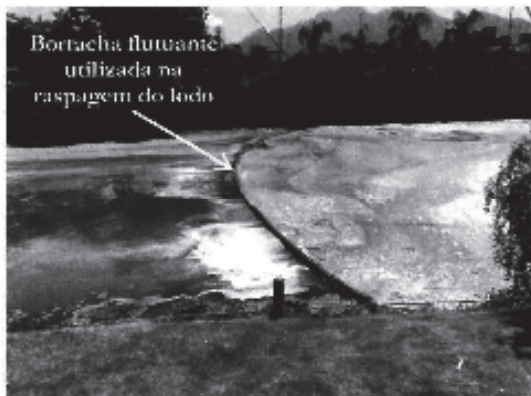
Figura A.11 – Processo de raspagem superficial do lodo flotado feito por uma estrutura de borracha flutuante. Nota-se que parte do lodo ainda permanece na bacia de flotação após a raspagem.
