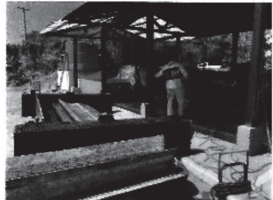
Figura A.22 – Área destinada à oficina para manutenção dos equipamentos utilizados no processo realizado na estação.
