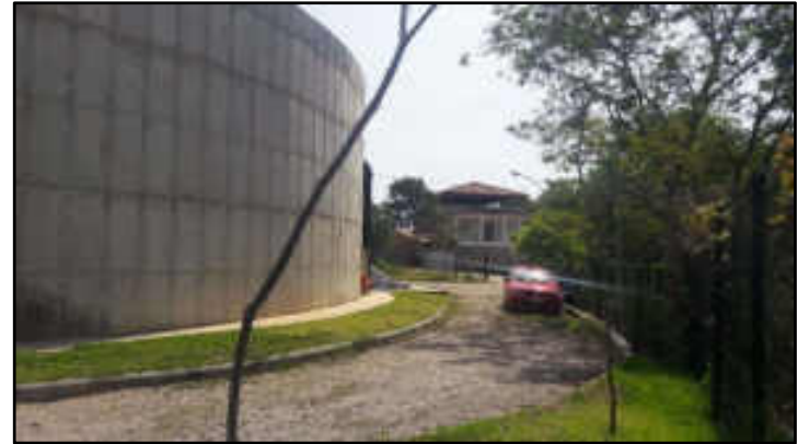
Área interna - terreno
