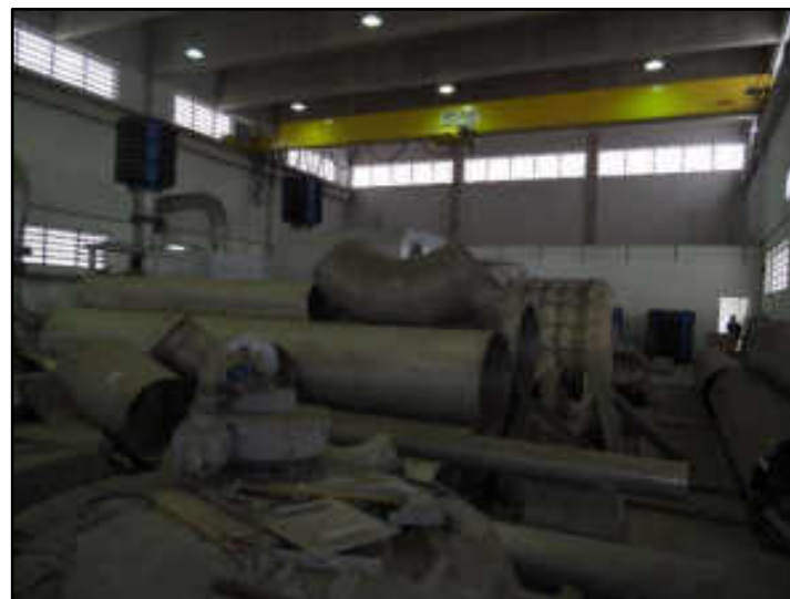
Sala dos sopradores
