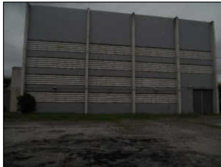
Fachada lateral - elevatória de retorno de lodo
