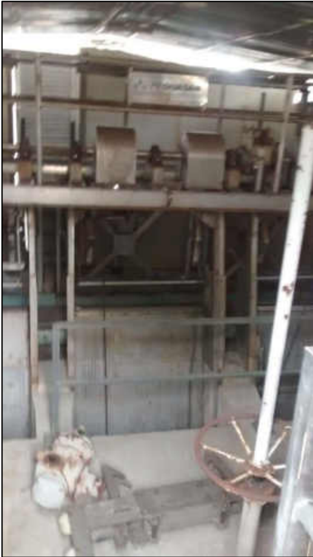
Área interna da sala de grades
