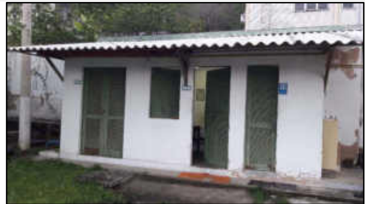
Sala do operador
