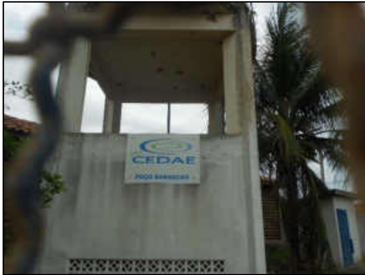
Identificação do Poço Barracão
