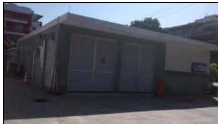
Acesso a sala do gerador
