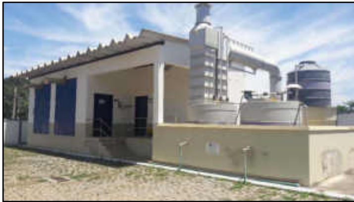
Casa de cloração
