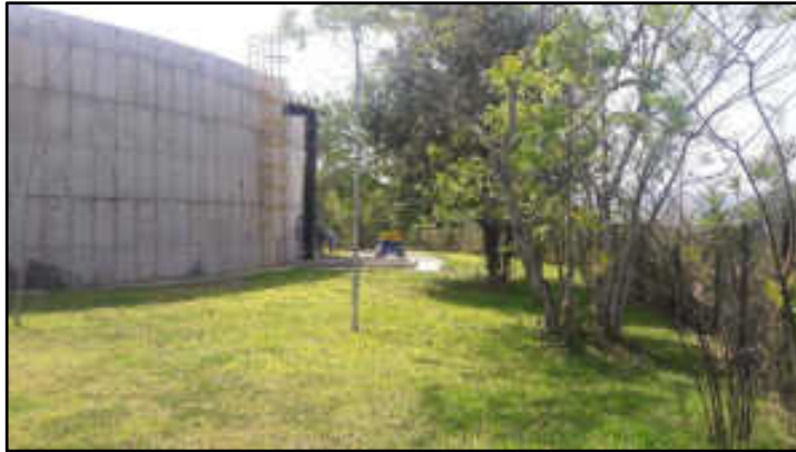
Área interna - terreno
