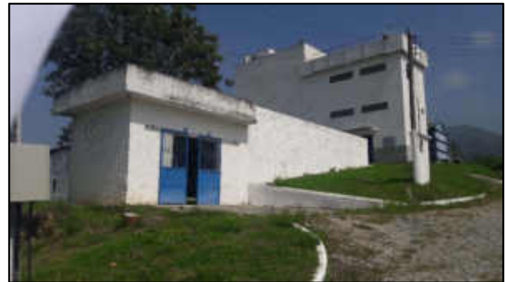
Salão de bombas e reserv
