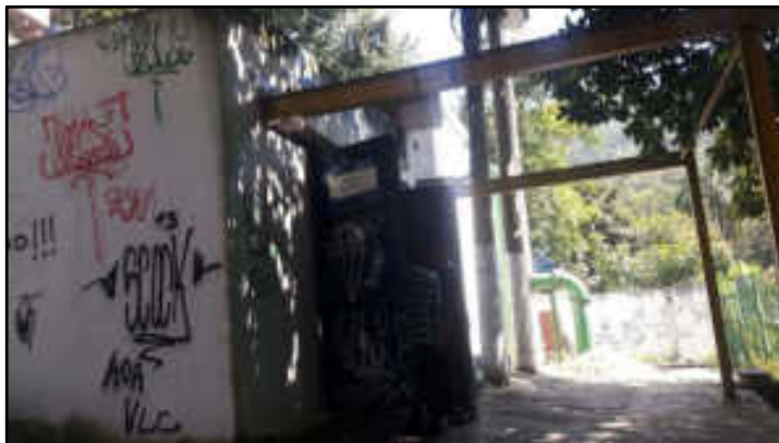
Fachada principal do salão de bombas
