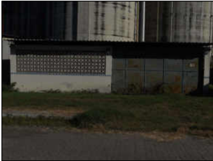
Sala do gerador - alimentação do gás
