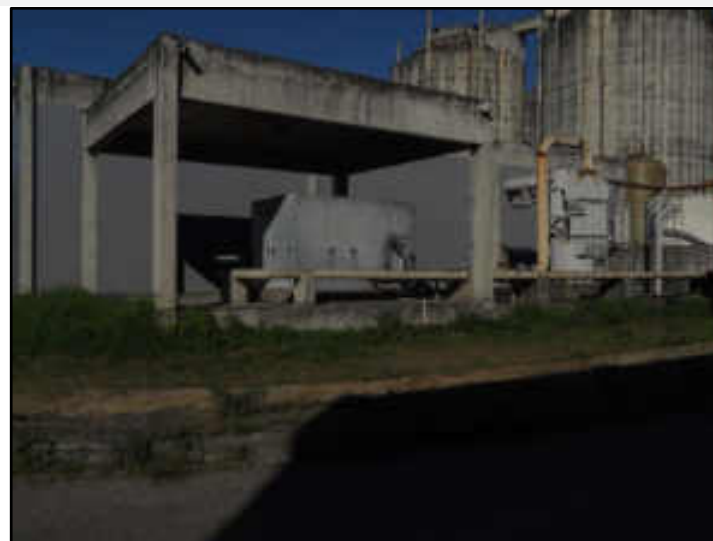
Prédio de desidratção de lodo
