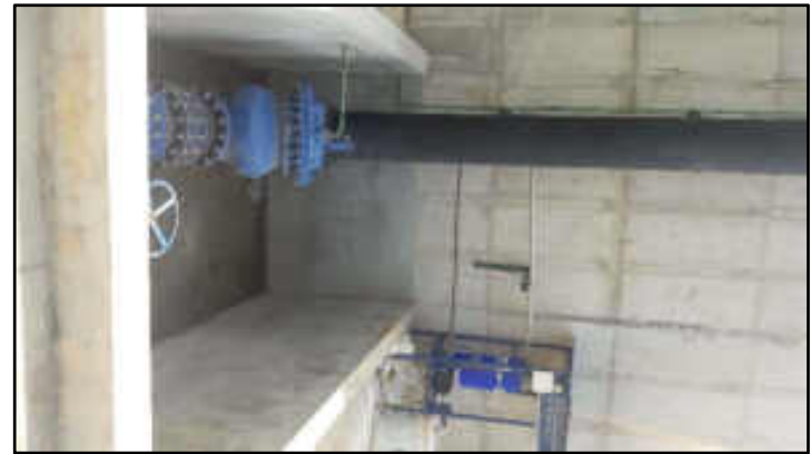
Chegada d'água e sistema de cloro
