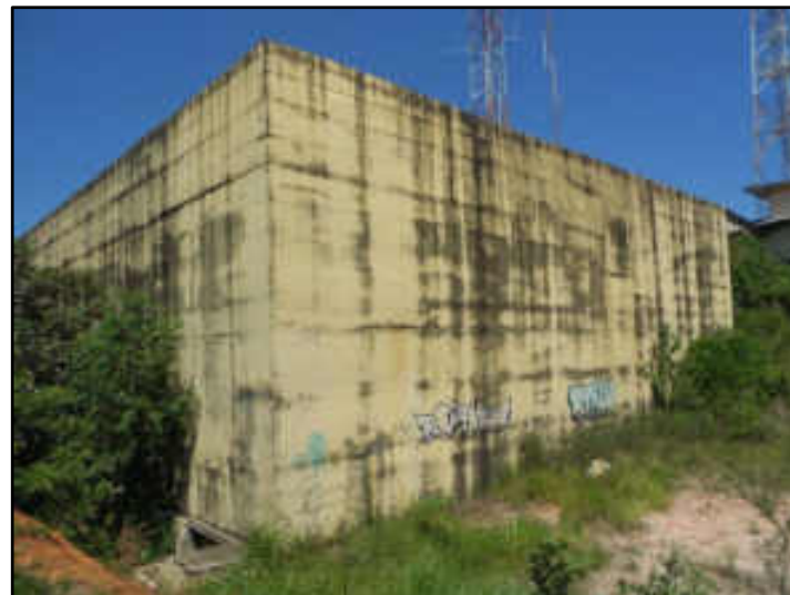
Reservatório Santa Monica em Macaé
