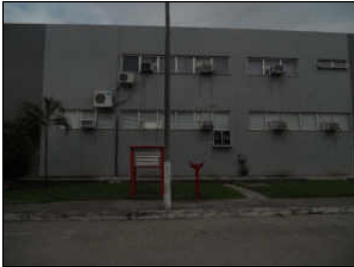
Fachada lateral do prédio adm
