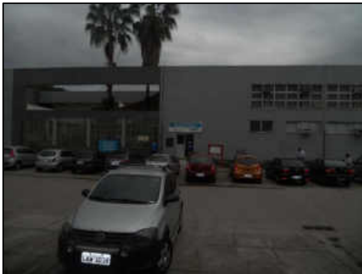
Fachada principal do prédio adm
