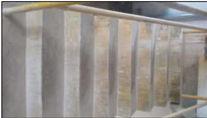
Escada de acesso ao 3º pavto
