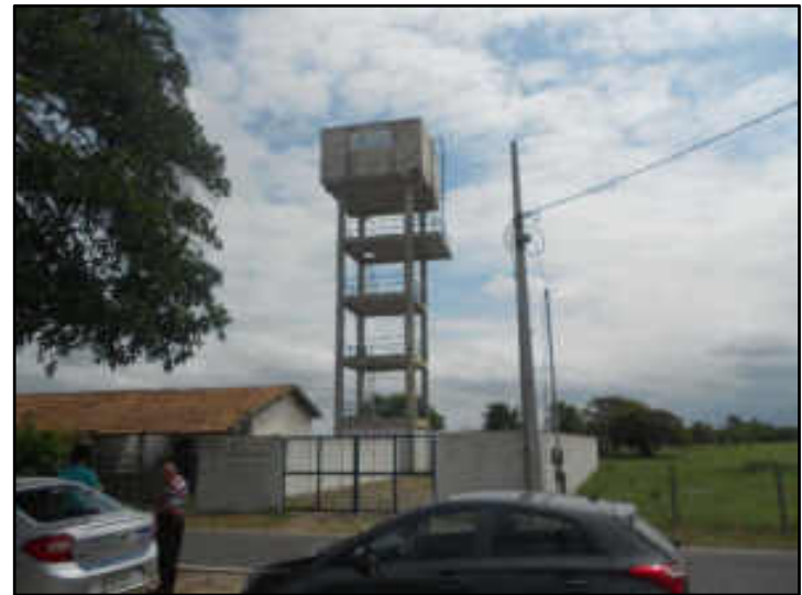
Vista geral da UT de Pipeiras
