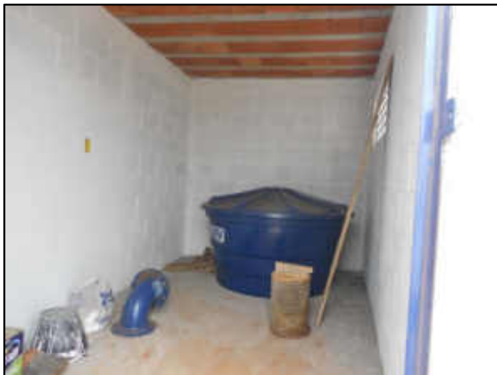
Vista interna da futura casa de química do Poço Máquinas
