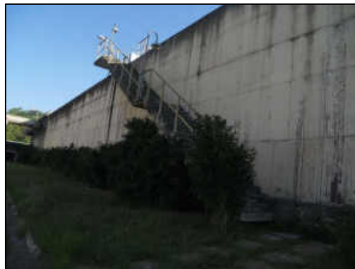
Tanque de aeração
