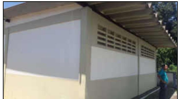
Estação elev. de lavagem de filtro - recirculação
