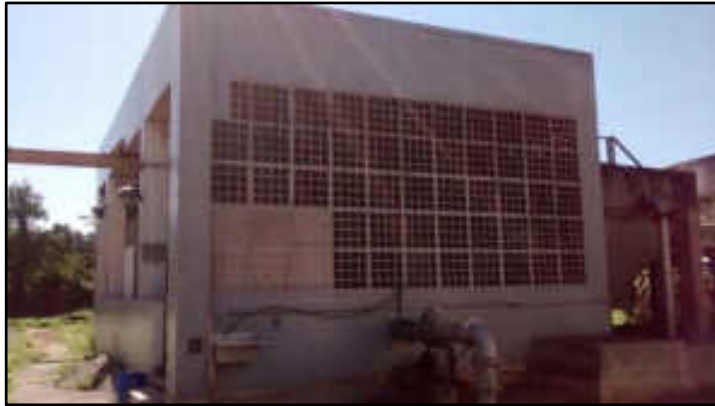
Vista da elevatória de lodo adensado
