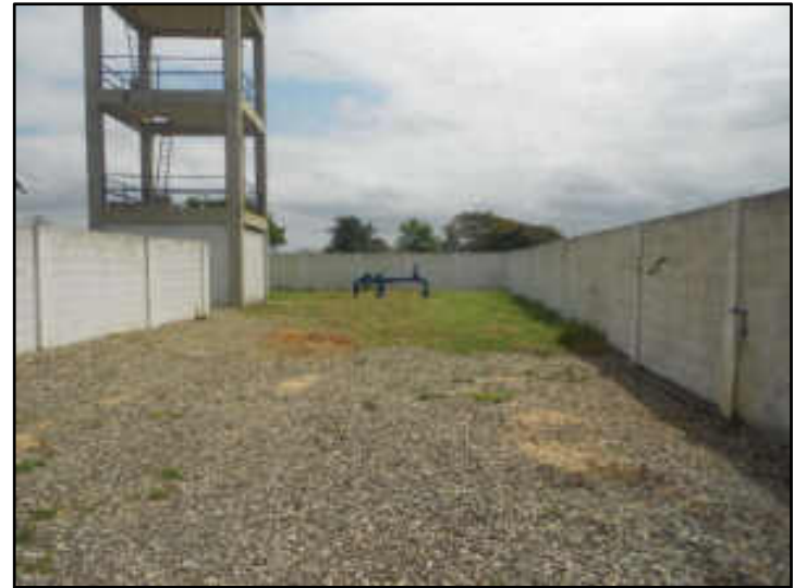
Vista do terreno da UT de Pipeiras
