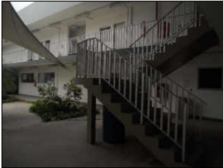
Escada de acesso ao 2º pavto
