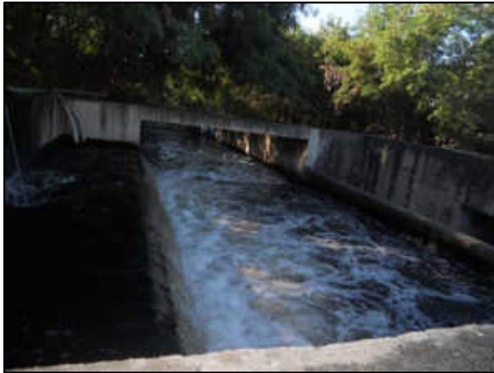
Canal de saída do efluente secundário
