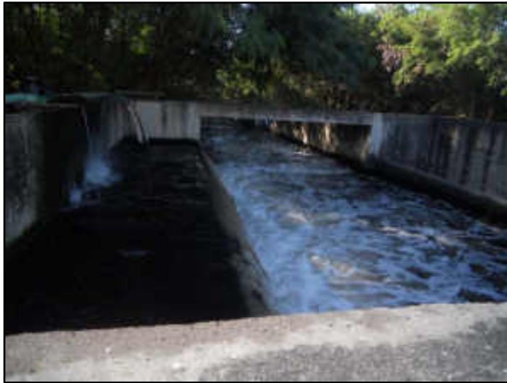
Canal de saída do efluente secundário
