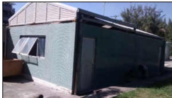
Acesso à sala de gradeamento grosseiro
