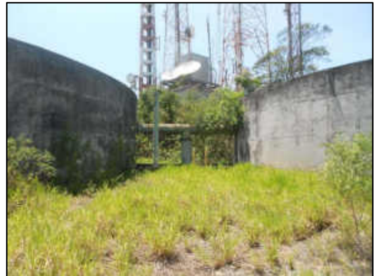
Vista dos 2 reservatório de 1250 m 3 cada Costazul
