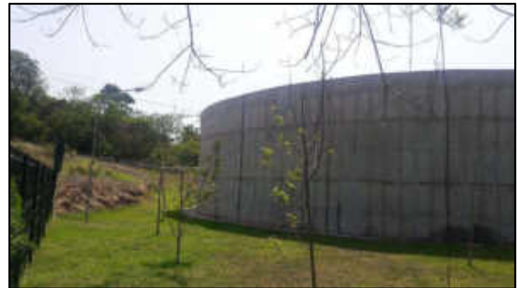
Área interna - terreno
