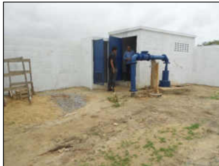
Vista nº 2 do terreno do Poço Máquinas
