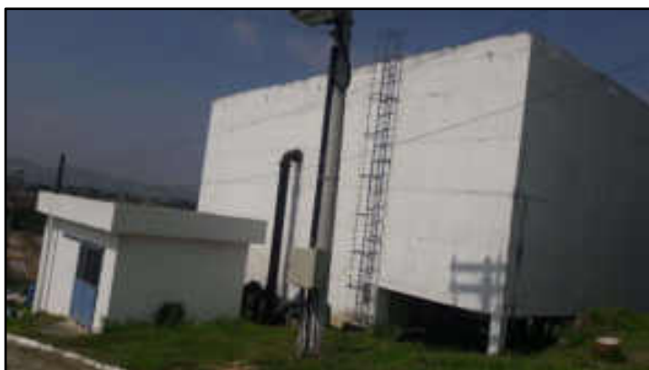
Reservatório e salão de bombas - novo
