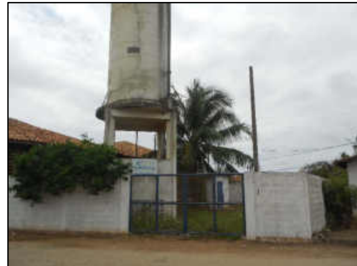
Vista geral do Poço Barracão
