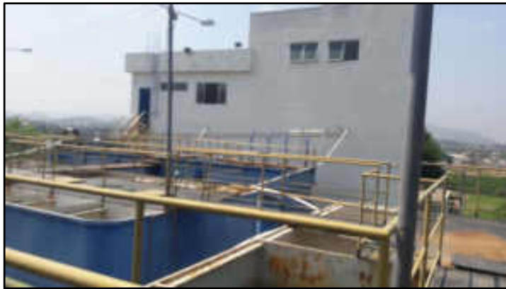
Vista geral - ETA e prédio operacional
