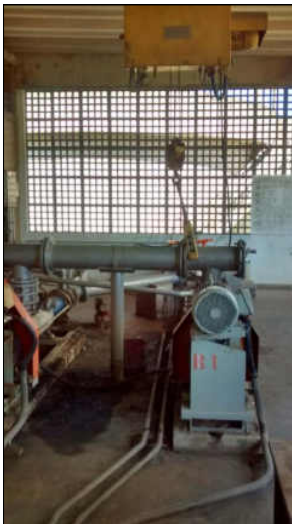
Área interna da elev. lodo adensado
