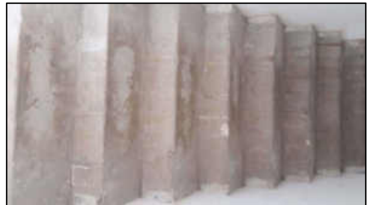
Escada de acesso ao 2º pavto
