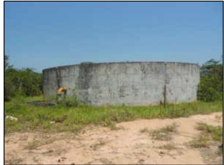
Reservatório nº 1 de 1250 m 3 Costazul
