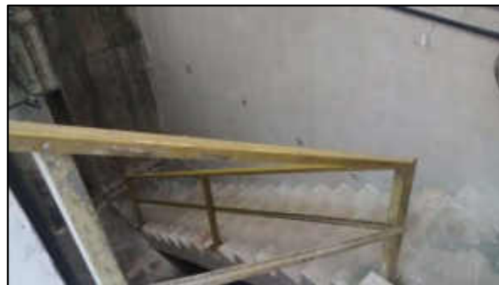
Escada de acesso ao salão de bombas
