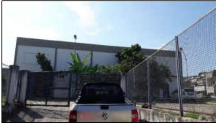
Acesso ao booster
