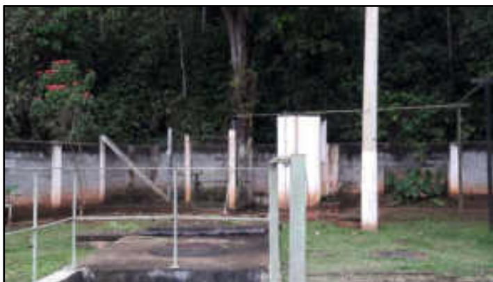
Vista geral - chegada do gás oxigênio
