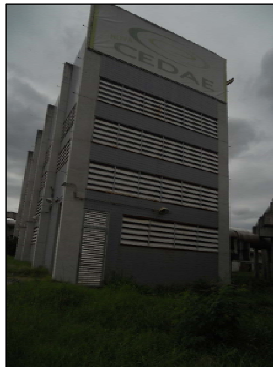
Fachada principal - elevatória de retorno de lodo
