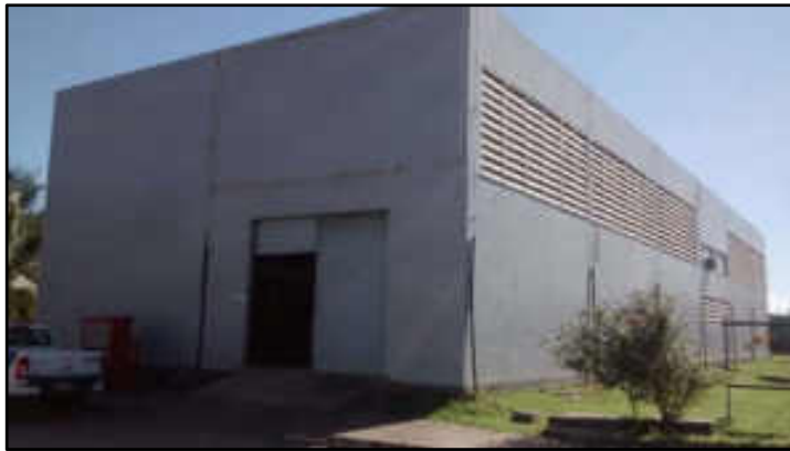
Vista geral do prédio da manutenção
