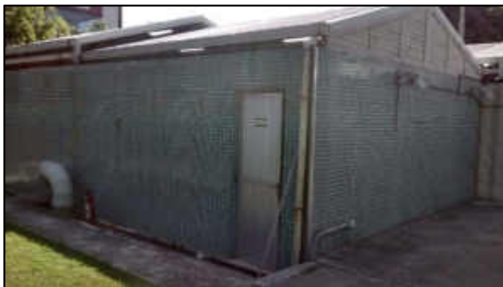
Fachada principal da sala de gradeamento grosseiro
