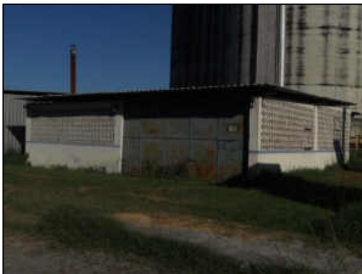
Sala do gerador - alimentação do gás
