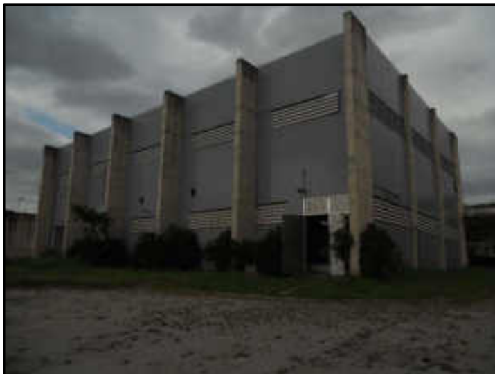
Fachada do prédio dos sopradores
