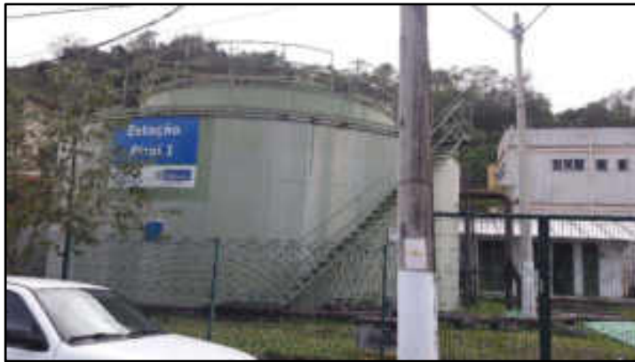
Vista geral - ETE
