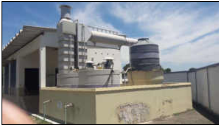
Sistema de tratamento de gases
