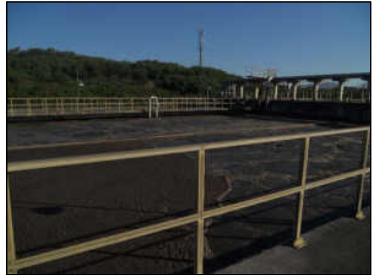
Tanque de aeração
