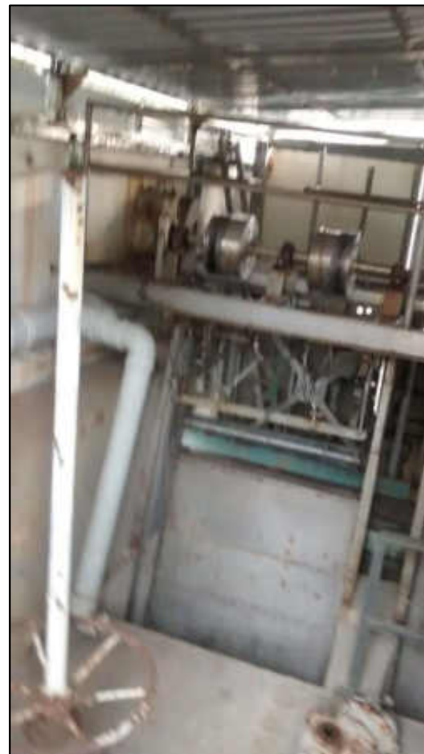
Área interna da sala de grades
