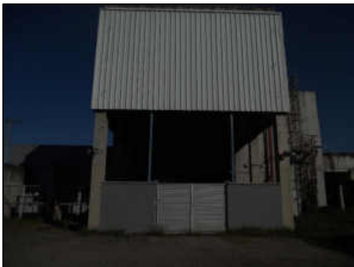
Prédio de desidratação de lodo - fachada
