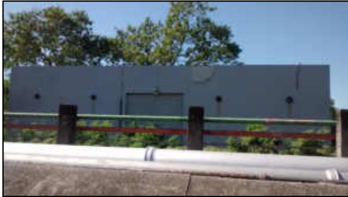
Fachada da subestação elétrica secundária
