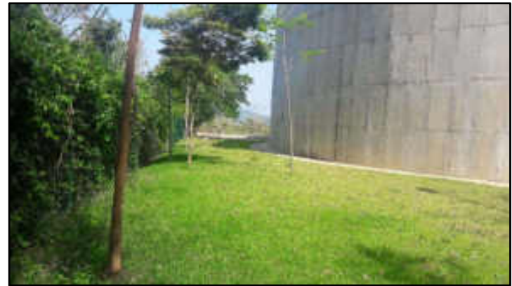
Área interna - terreno
