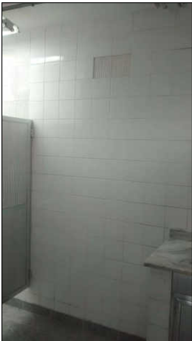
Prédio principal banheiro
