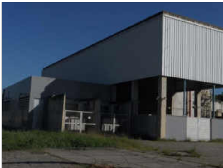
Prédio de desidratação de lodo - fachada
