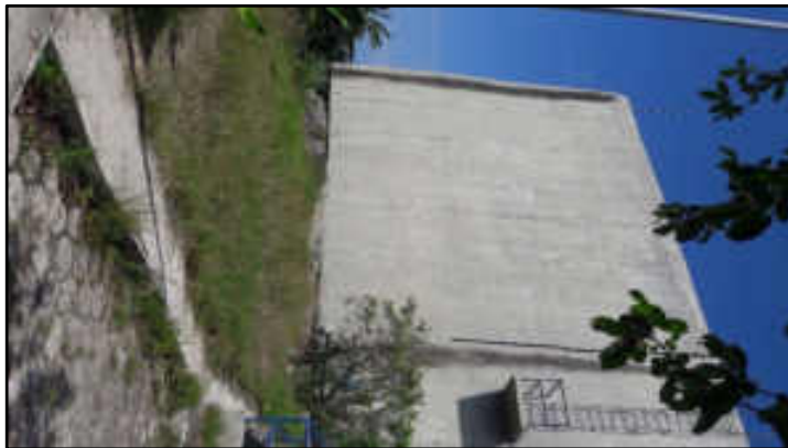
Rea interna - terreno
