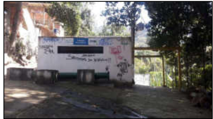
Vista lateral do salão de bombas
