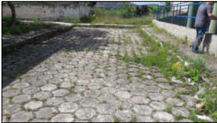
Área interna - terreno
