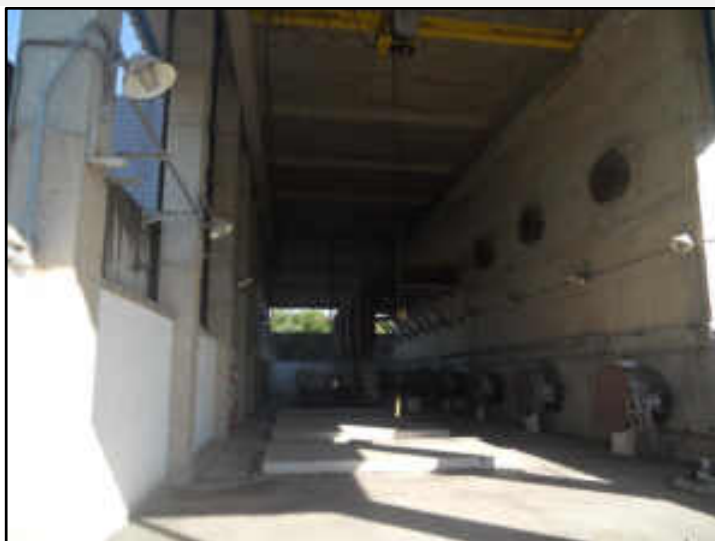
Prédio de desidratção de lodo
