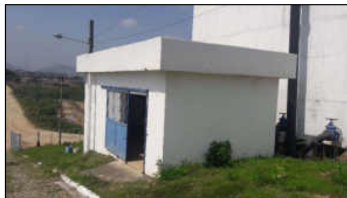
Salão de bombas
