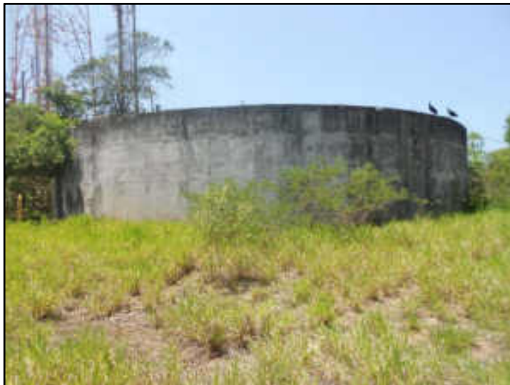
Reservatório nº 2 de 1250 m 3 Costazul
