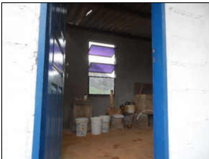
Vista interna do reservatório de Ourânia, Natividade
