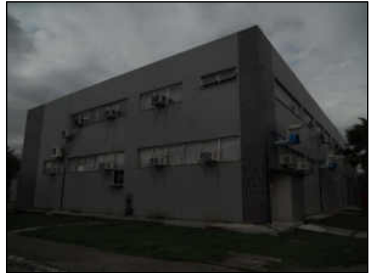
Fachada lateral do prédio adm
