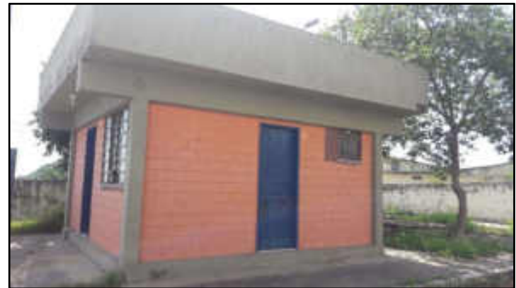
Sala do operador
