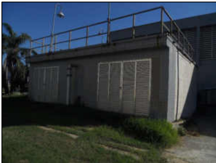
Elevatória de excesso de lodo - fachada
