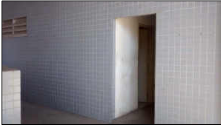
Acesso ao WC e à sala
