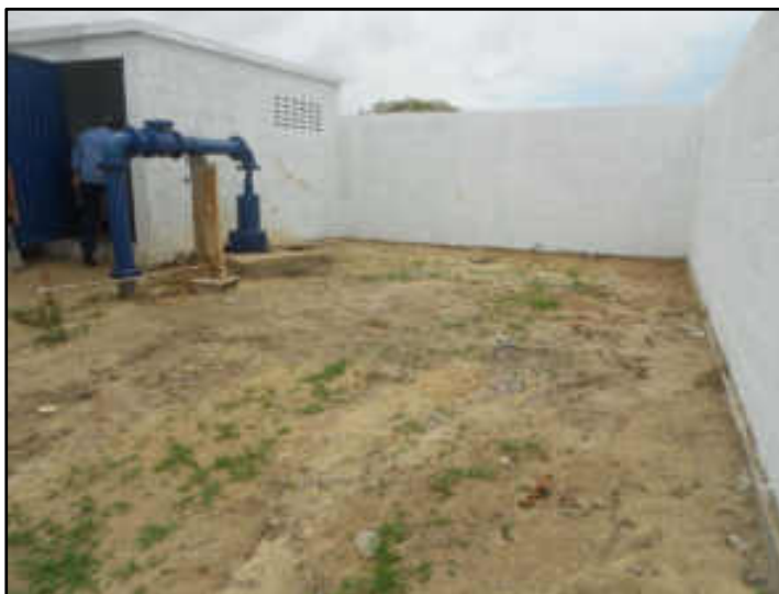
Vista Terreno do Poço Máquinas
