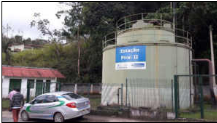
Vista geral da ETE
