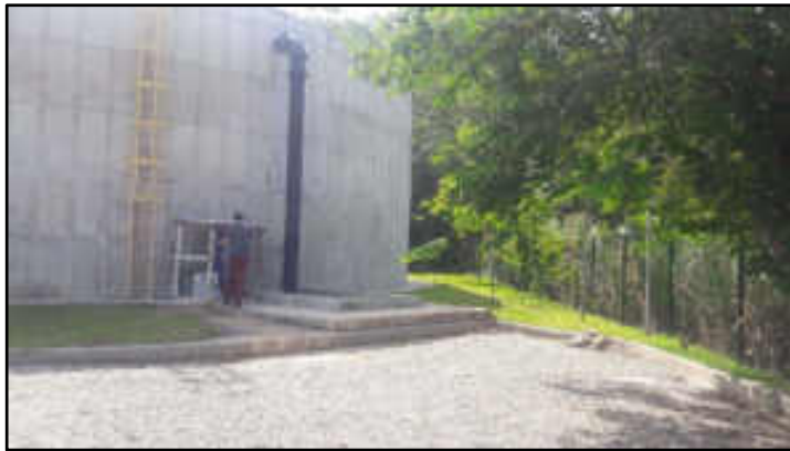
Área interna - terreno
