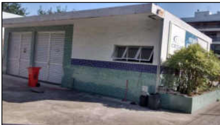
Vista geral da sala do gerador
