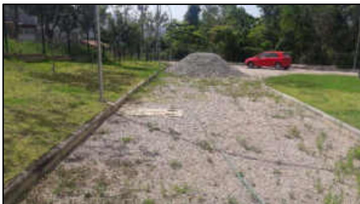
Área interna - terreno
