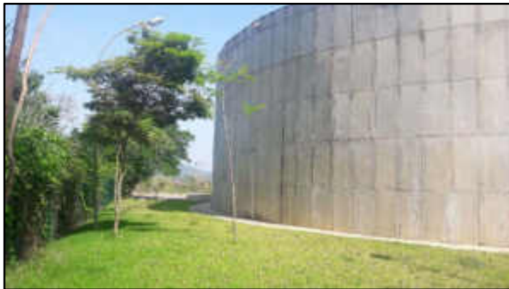
Área interna - terreno
