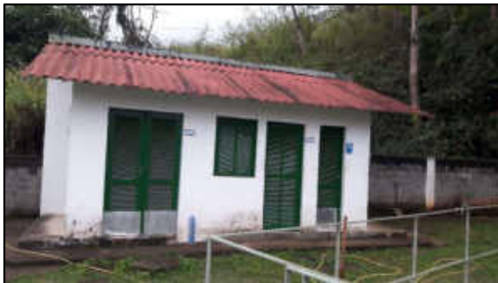
Sala do operador
