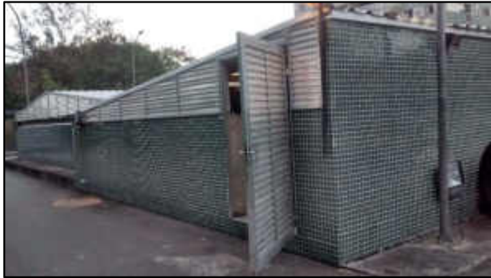
Acesso ao salão de bombas
