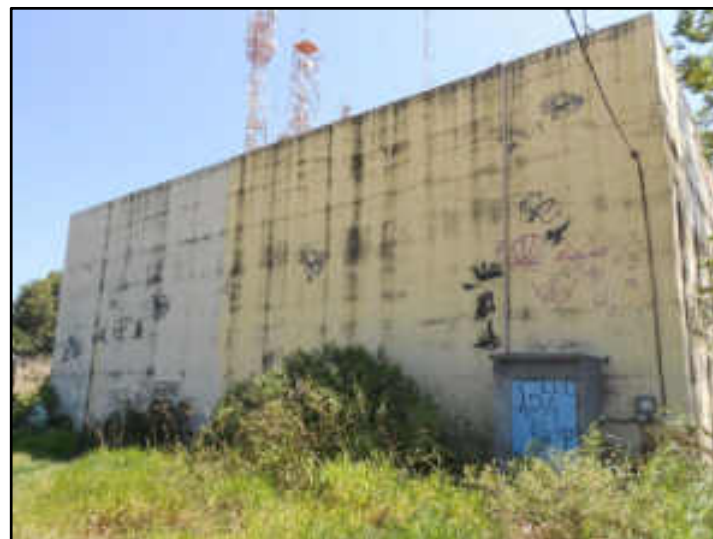
Vista lateral reservatório Santa Monica em Macaé
