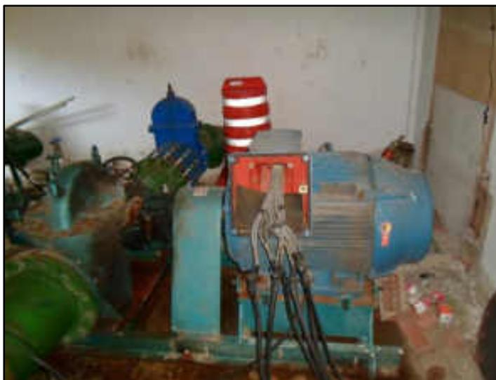
4.1 MOTOR DE INDUÇÃO WEG W 22 PLUS 3560 RPM HP 75 100 CV 60 HZ 220 380 440 V
