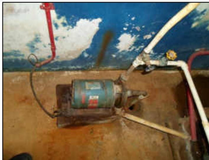
5.36.1. ETA VARRE-SAI - BOMBA D'AGUA NA.DANCOR NA 0,75 CV 3460 RPM 60 HZ 220V
