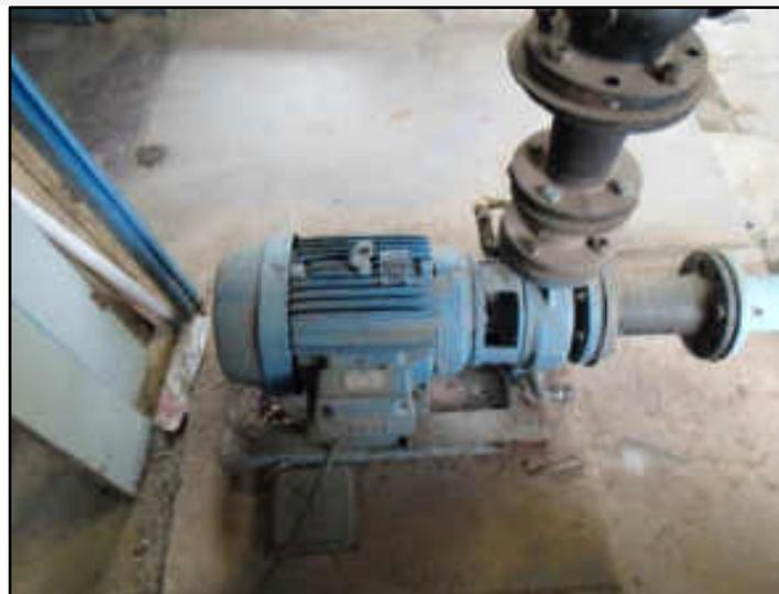
5.37.4. ETA VELHA MIRACEMA - MOTOR DE INDUÇÃO TRIFASICO NA WEG NA 15 CV 60 HZ 220 380 440 V
