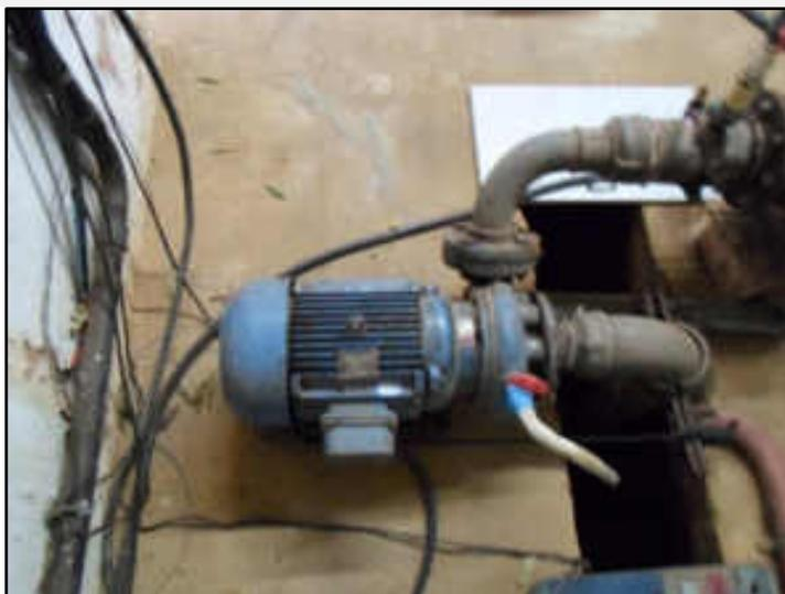
5.42.1. RESERVATORIO DO HORTO - MOTOR INDUÇÃO TRIF EBERLER PB 132 M2 E2428 15 CV 60 HZ 3515 RPM
