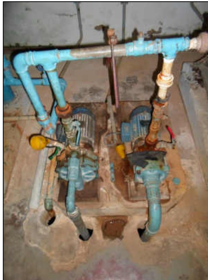
5.26.14. ETA E CAPTAÇÃO ITAPERUNA - MOTOR DE INDUÇÃO TRIF WEG NA 3 CV 220 380 V 60 HZ
