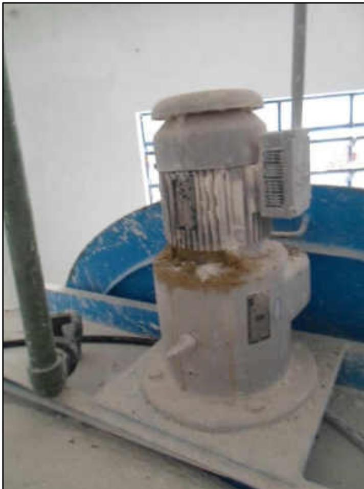
5.26.13. ETA E CAPTAÇÃO ITAPERUNA - MISTURADOR DE CAL MOTOR DE INDUÇÃO WEG 0,5
