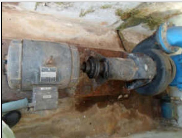
5.35.3. ETA PORTELA - MOTOR DE INDUÇÃO TRIFASICO BUFALO 25 CV 60 HZ RPM 1160 Z 7757 8
