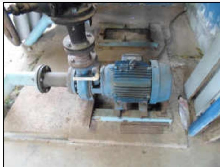
5.32.6. ETA MIRACEMA PARAOQUENA - MOTOR INDUÇÃO TRIF NA WEG NA 15 CV 60 HZ 220 380 440 V
