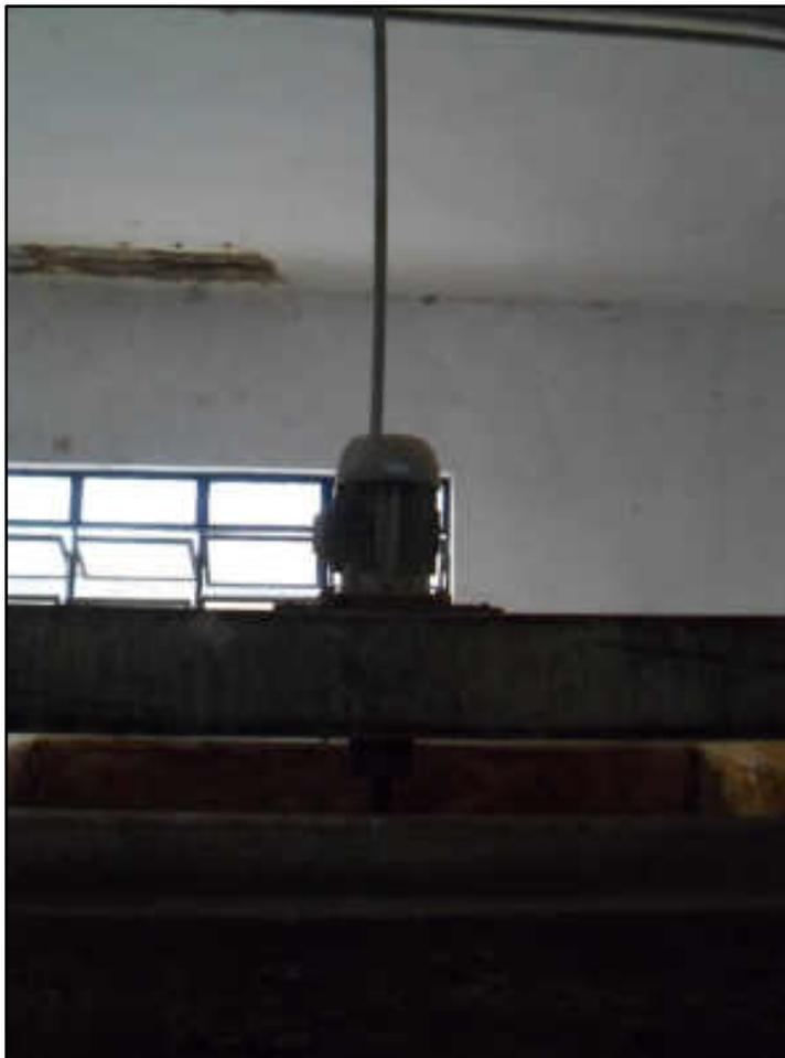
5.26.9. ETA E CAPTAÇÃO ITAPERUNA - MISTURADOR DE CAL ( MOTOR DE INDUÇÃO) NA WEG NA 0,5 CV
