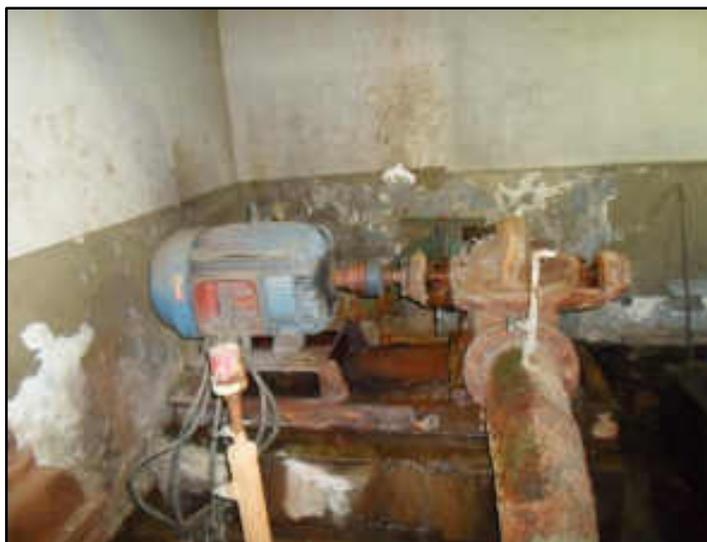
5.1 MOTOR DE INDUÇÃO WEG HP 75 RPM 1775 220 380 440 V
