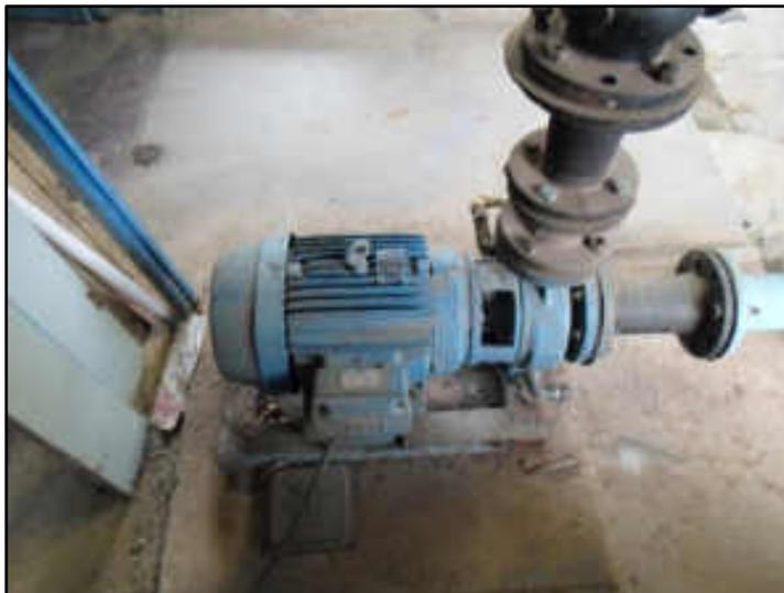
5.32.7. ETA MIRACEMA PARAOQUENA - MOTOR INDUÇÃO TRIF NA WEG NA 15 CV 60 HZ 220 380 440 V
