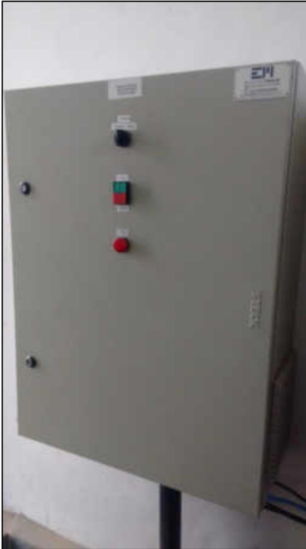
7.10.8. ETA SUMIDOURO - PAINEL DE PARTIDA DOS MOTORES
