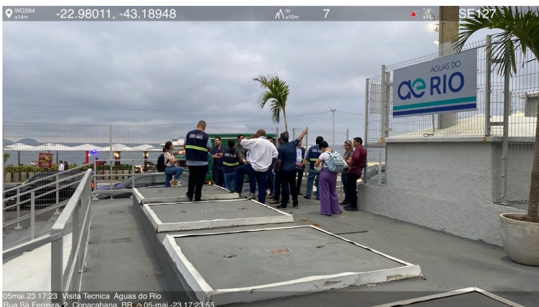
Foto 3: Estação Elevatória Parafuso na praia de Copacabana, vista externa.
